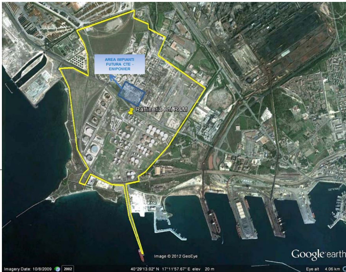
Figura 5-B- Ubicazione dello Stabilimento EniPower di Taranto
