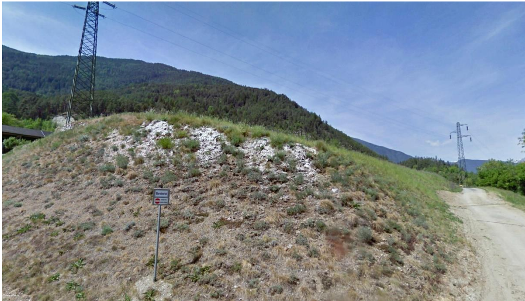
Vista 19: Vista dal comune di Velturmo, in direzione della linea elettrica in demolizione (Fonte: Google Earth).
