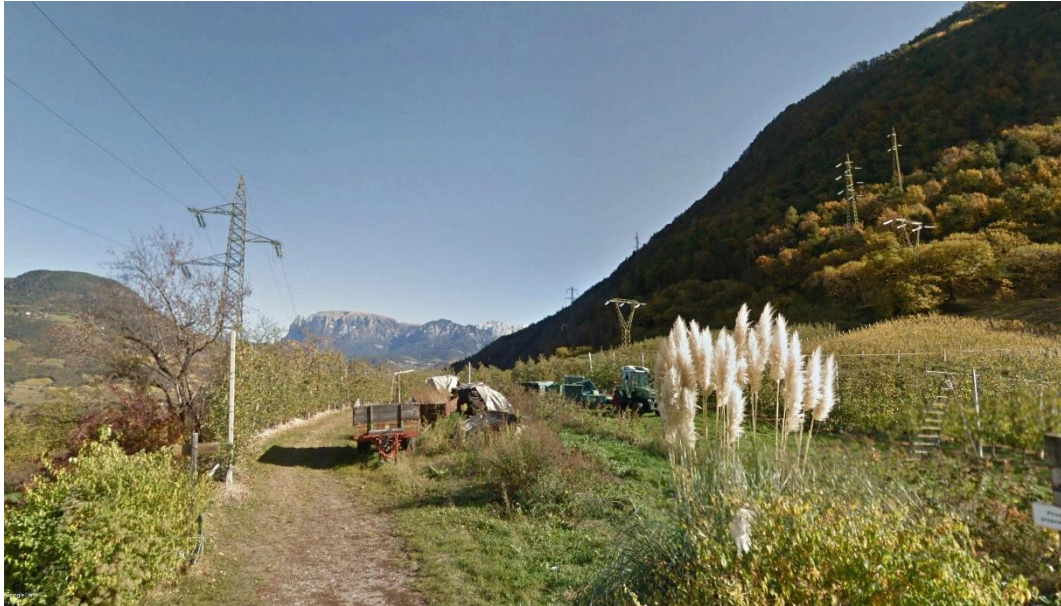
Vista 40: Vista dal comune di Bolzano, in direzione della linea elettrica esistente e quella in demolizione (Fonte: Google Earth).
