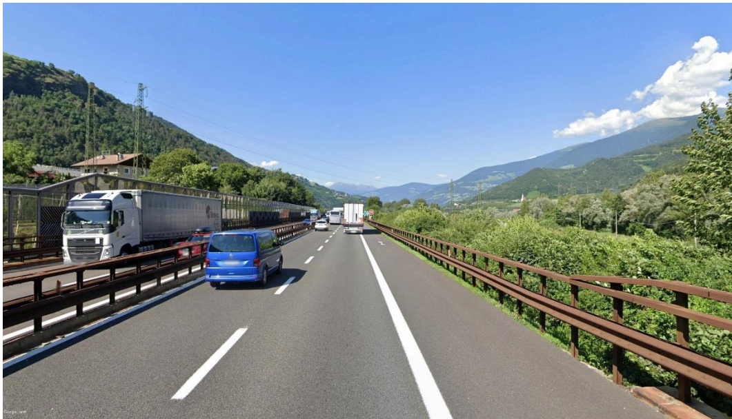
Vista 24: Vista dal comune di Chiusa, in direzione della linea elettrica in demolizione (Fonte: Google Earth).
