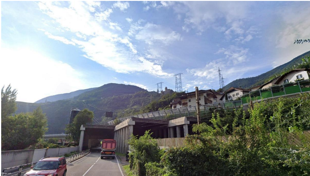
Vista 39: Vista dal comune di Cornedo all'Isarco, in direzione della Stazione Elettrica esistente - Terna (Fonte: Google Earth).
