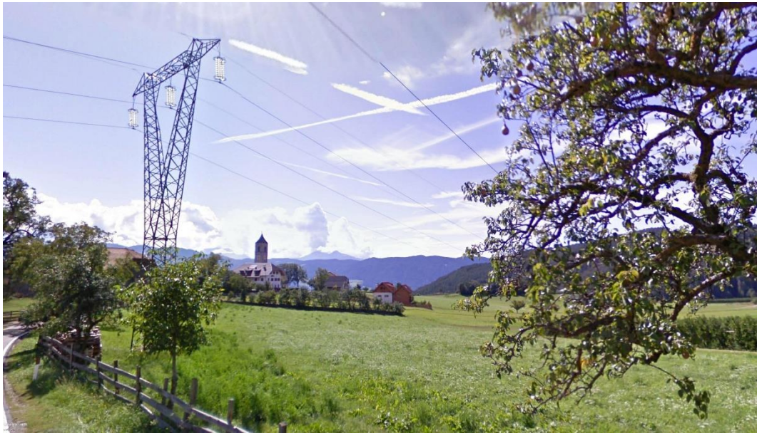
Vista 34: Vista dal comune di Renon, in direzione della linea elettrica in demolizione (Fonte: Google Earth).
