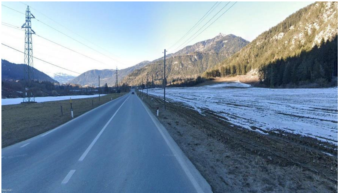
Vista 2: Vista dal comune di Capo di Trens, in direzione dell'opera "Variante elettrodotto 132 kV – Singola Terna" (Fonte: Google Earth).
