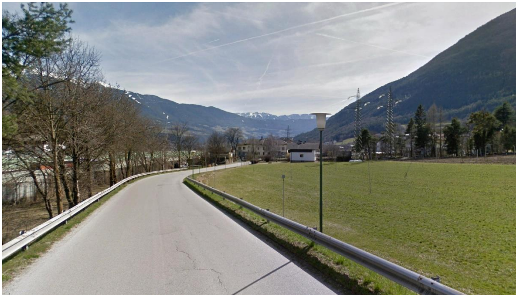
Vista 14: Vista dal comune di Varna, in direzione della linea elettrica in demolizione (Fonte: Google Earth).
