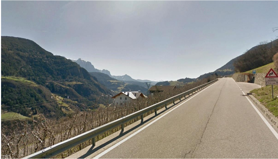
Vista 30: Vista dal comune di Barbiano, in direzione della linea elettrica in demolizione (Fonte: Google Earth).
