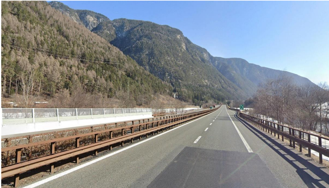
Vista 7: Vista dal comune di Fortezza, in direzione dell'opera "Direttrice 220kV – Singola Terna - Resiliente" e del tratto di linea in demolizione (Fonte: Google Earth).
