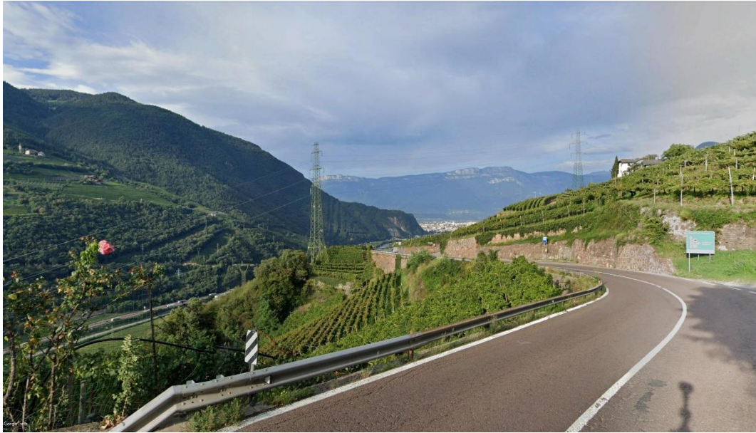
Vista 38: Vista dal comune di Bolzano, in direzione della linea elettrica esistente e quella in demolizione (Fonte: Google Earth).
