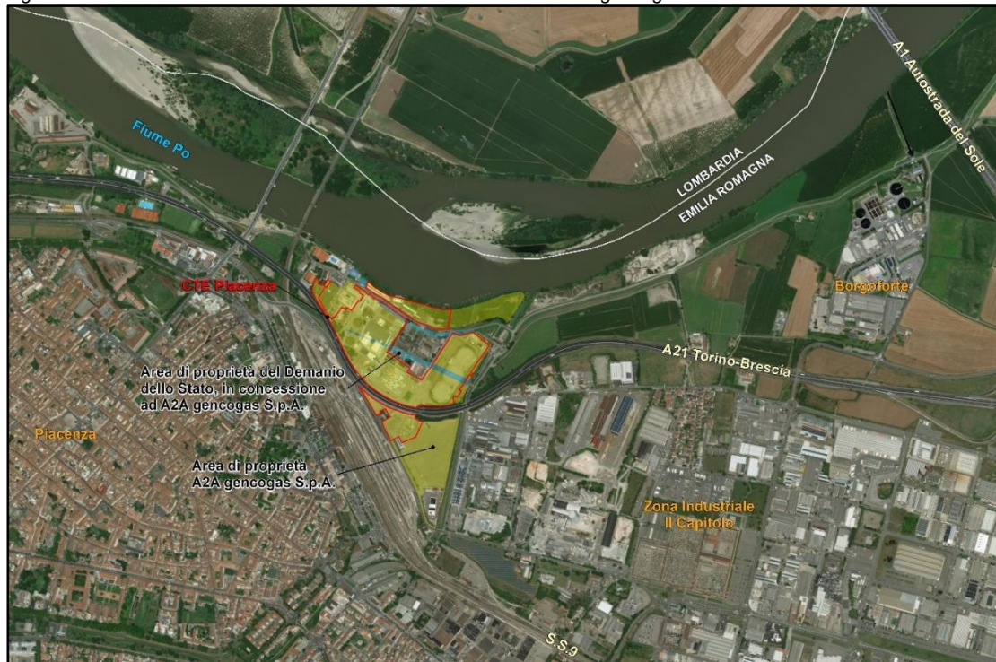
Figura 2.1a Localizzazione della Centrale Termoelettrica A2A gencogas di Piacenza
