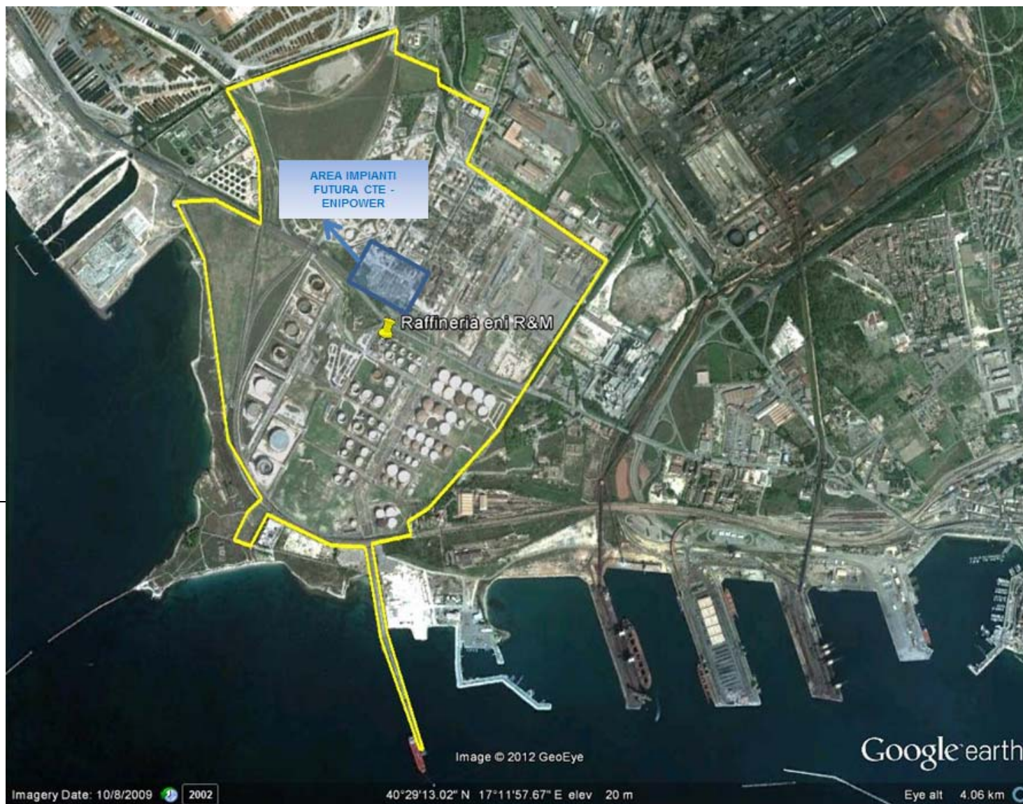
Figura 1-B- Ubicazione dello Stabilimento EniPower di Taranto
