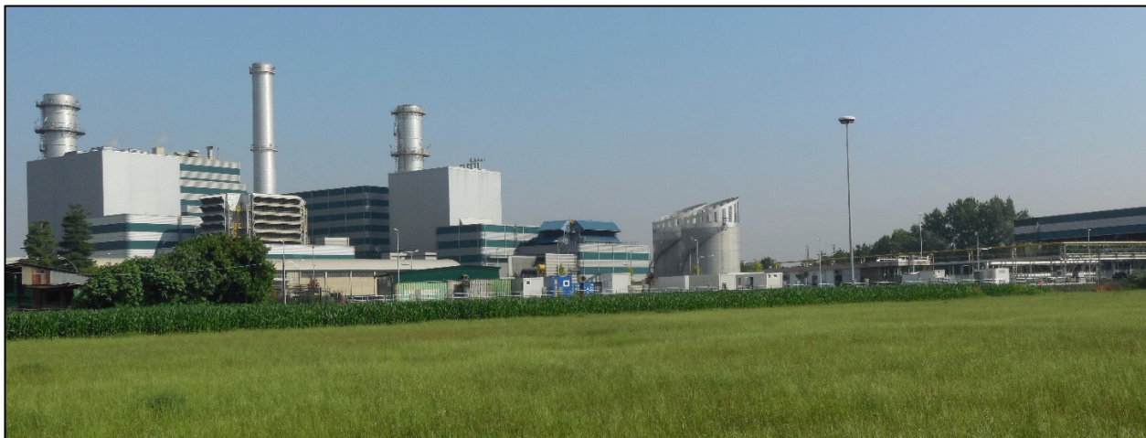
Figura 4.5.5/9 Aree agricole a seminativo prossime alla Centrale – Vista da sud
