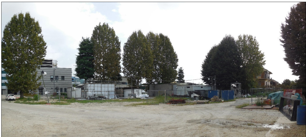
Figura 4.4.2.1/4 Situazione attuale del sito di prevista localizzazione dell'edificio officina e laboratorio
