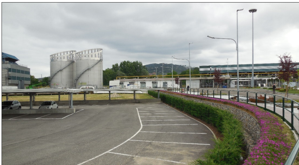
Figura 4.5.5/13 Area aerocondensatore - Bordura d'arredo arbustiva e floreale (interferita)
