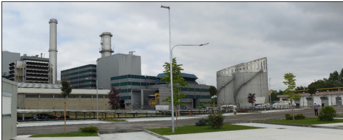
Figura 4.5.6/15 Area aerocondensatore - Esempari arborei interferiti dalle opere in progetto
