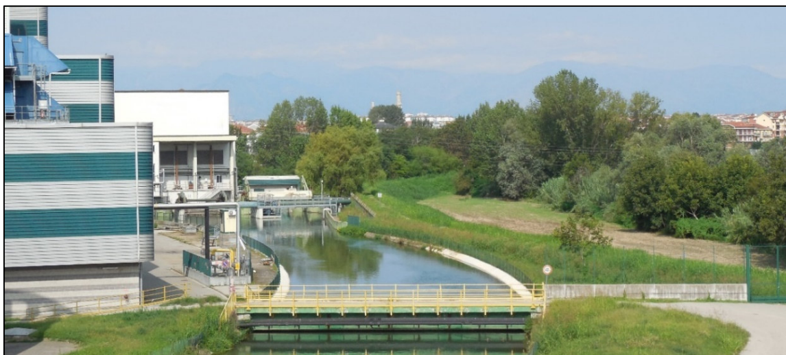
Figura 4.5.5/1 La centrale esistente è ubicata in prossimità della vegetazione spondale a latifoglie miste del Po, visibile sulla destra dell'immagine, da cui è separata da terreni a copertura prativa o adibiti a seminativo
