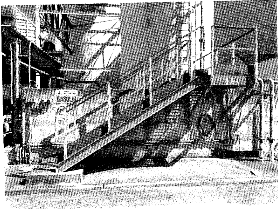
Figura 4: Serbatoi gasolio - particolare bacino di contenimento in c/c
