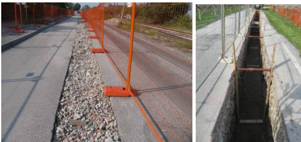
Taglio dell'asfaltatura e scavo aperto
