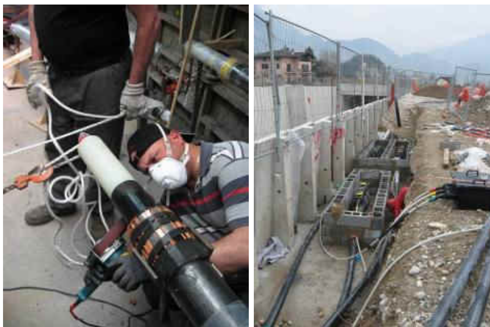
Esecuzione giunto esempio di buca giunti
