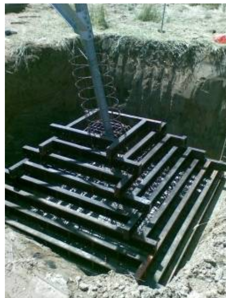
Esempio di realizzazione di una fondazione a plinto con riseghe. Nell'immagine di sinistra di può osservare un disegno di progetto mentre nell'immagine di destra la fase di cassetta della fondazione
