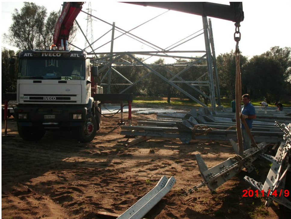
Fasi di montaggio sostegno a traliccio
