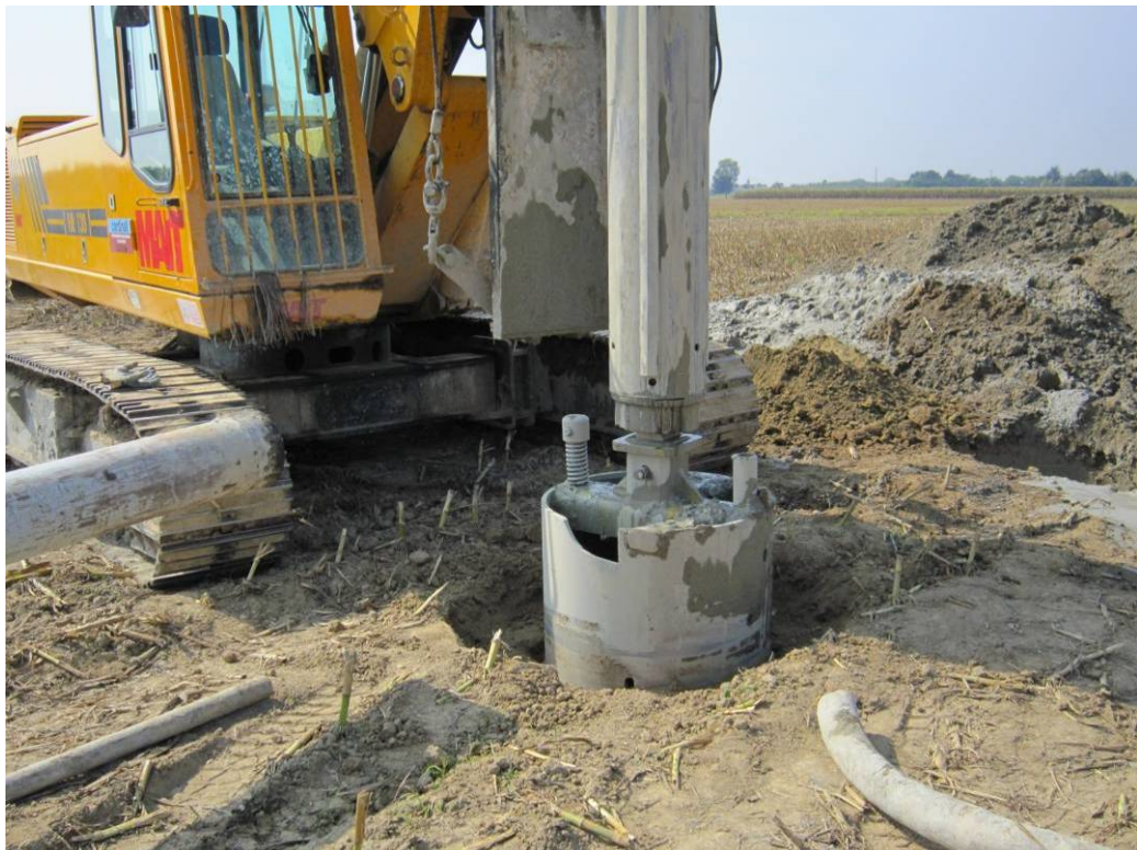
Macchina operatrice per la realizzazione di pali trivellati. Particolare del "carotiere"
