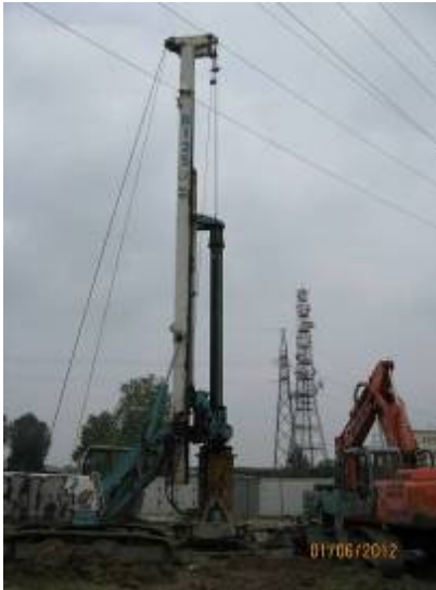
Esempio di realizzazione di una fondazione su pali trivellati.
