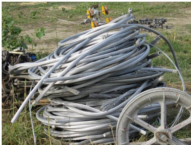
Fasi demolizione di un sostegno a traliccio
