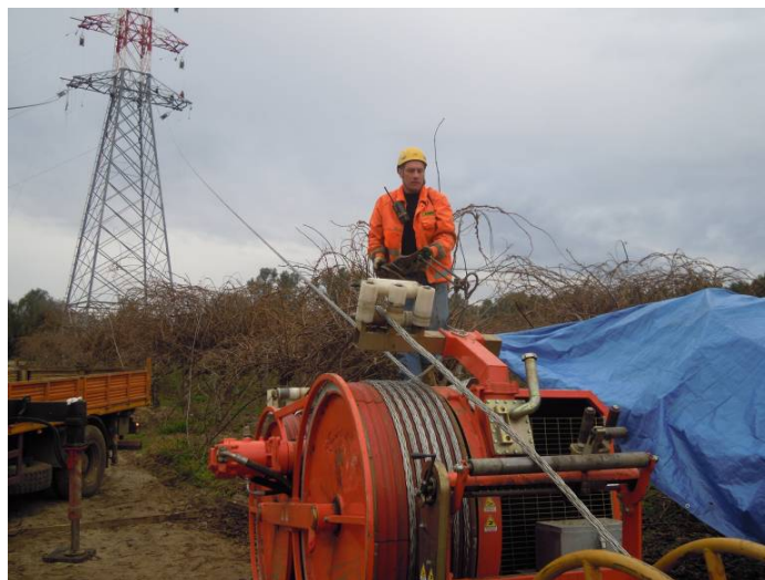
Fasi di tesatura della linea elettrica
