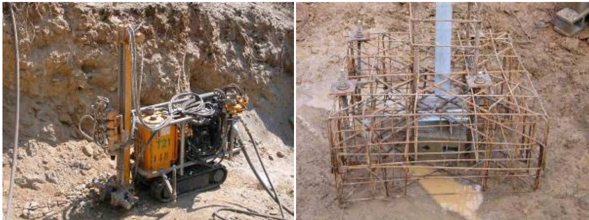
Esempio di fondazione con tiranti in roccia
