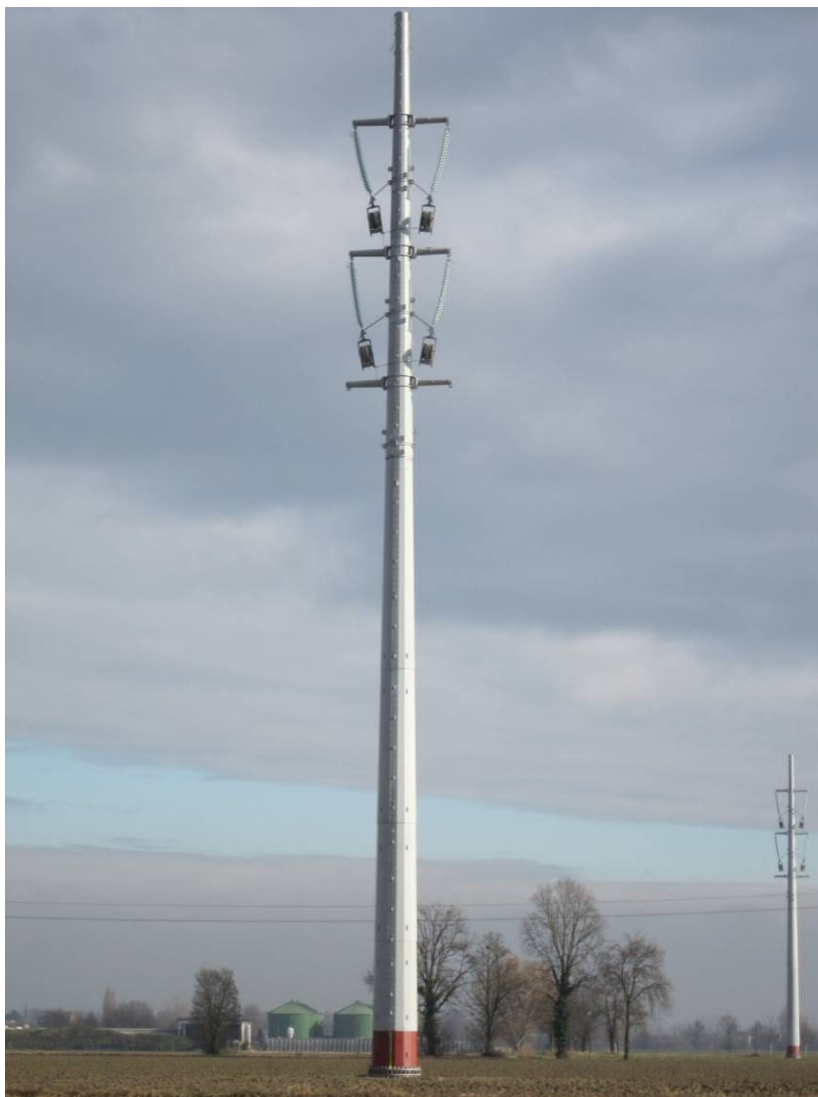
Sostegno monostelo montato. Si notino le carrucole collegate alle catene degli isolatori, fase che precede la "tesatura" dei conduttori
