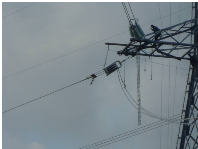
Fasi di tesatura della linea elettrica
