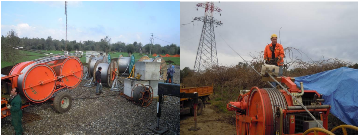
Figura 24: Fasi di tesatura della linea elettrica
