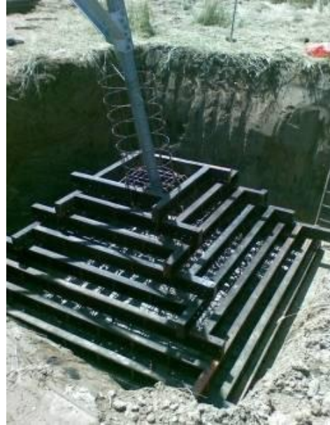
Figura 10: Esempio di realizzazione di una fondazione a plinto con riseghe. Nell'immagine di sinistra di può osservare un disegno di progetto mentre nell'immagine di destra la fase di casseratura della fondazione
