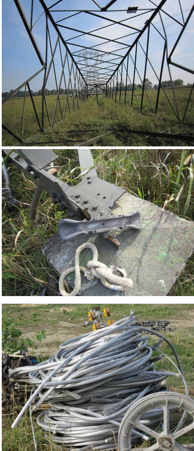
Figura 26: Fasi demolizione di un sostegno a traliccio
