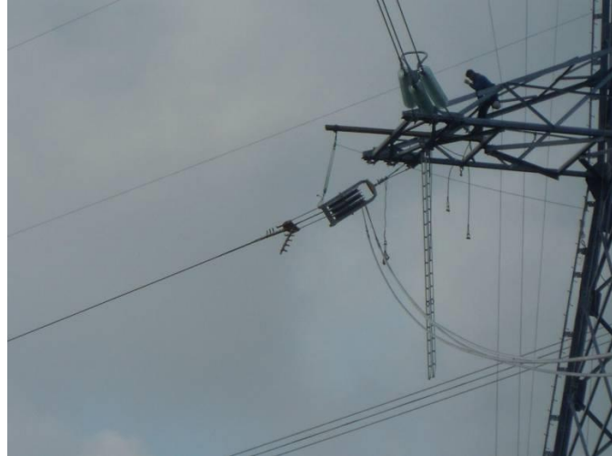
Figura 25: Fasi di tesatura della linea elettrica
