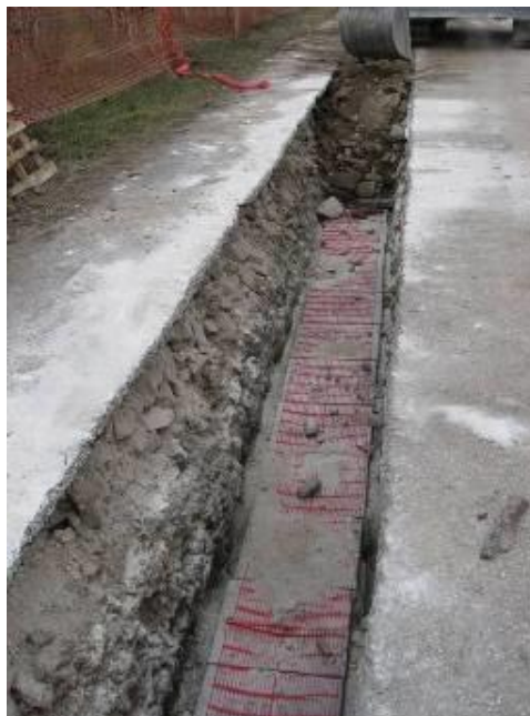
Figura 32: Rinterro con posa delle piastre di protezione e rete PVC
