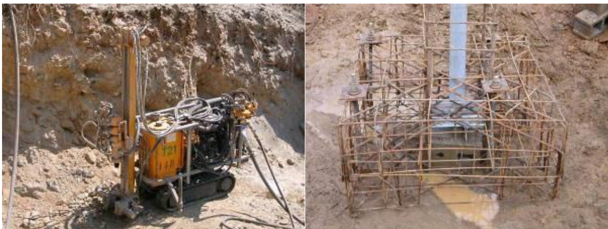
Figura 11: Esempio di fondazione con tiranti in roccia
