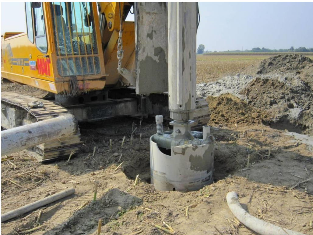
Figura 17: Macchina operatrice per la realizzazione di pali trivellati. Particolare del "carotiere"
