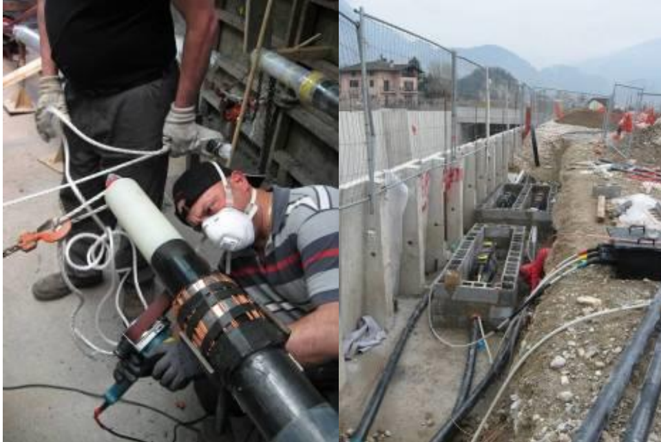
Figura 31: Esecuzione giunto esempio di buca giunti
