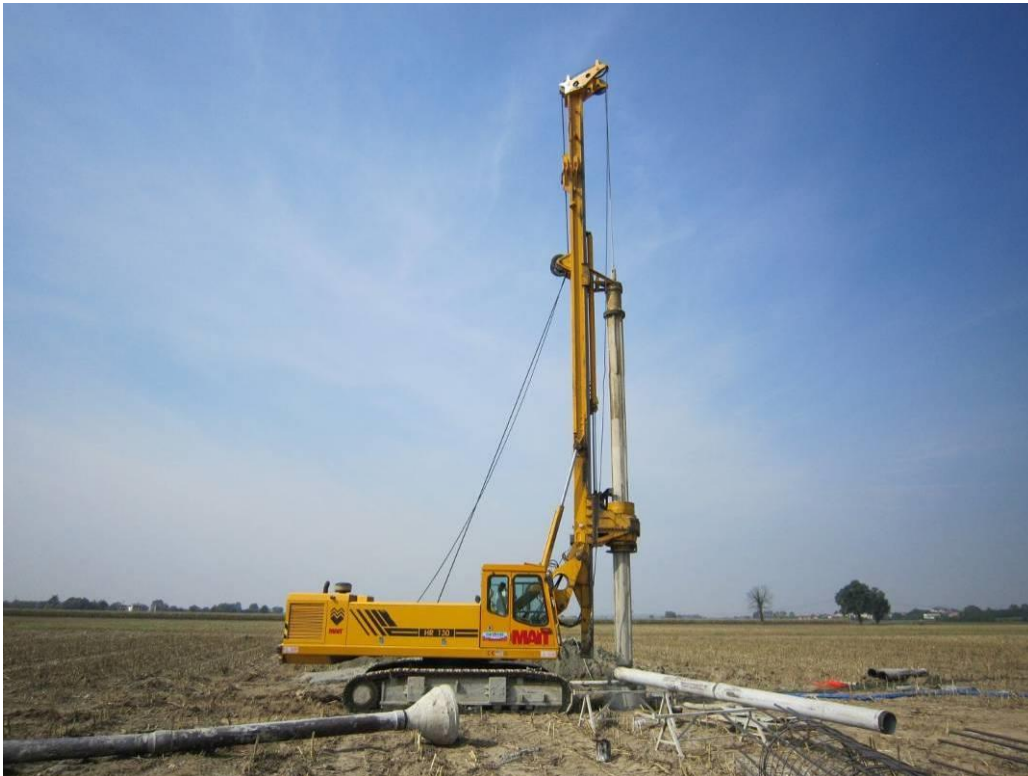
Figura 16: Macchina operatrice per la realizzazione di pali trivellati
