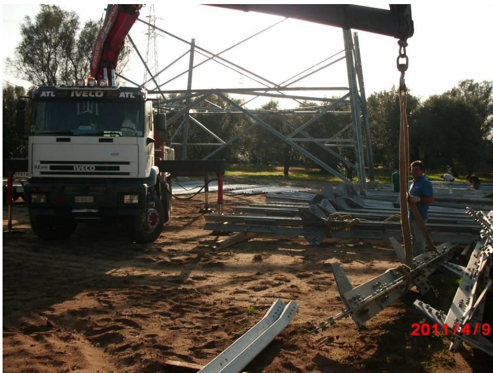
Figura 20: Fasi di montaggio sostegno a traliccio
