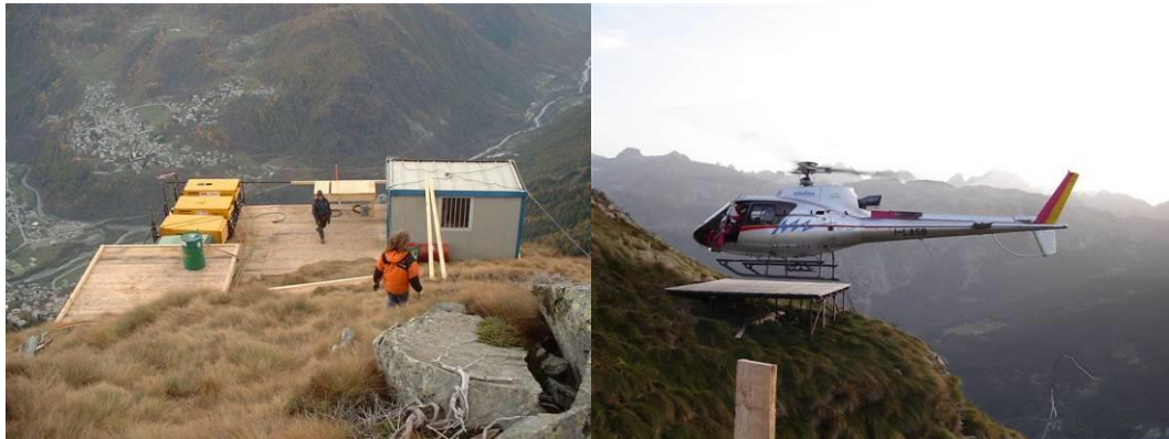
Figura 21: Esempi micro - cantieri in quota
