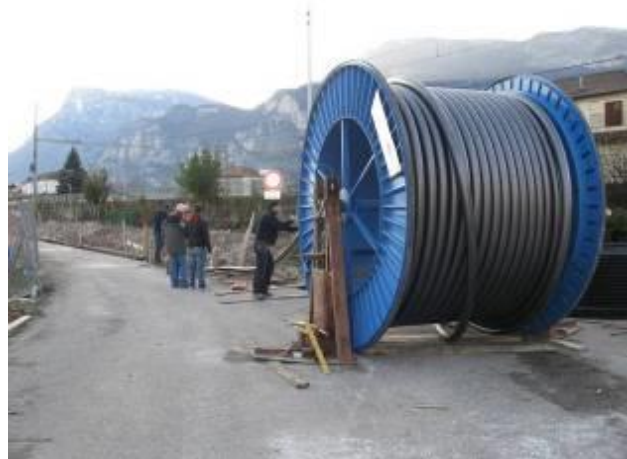
Figura 30: Posa rulli lungo lo scavo e stendimento del cavo
