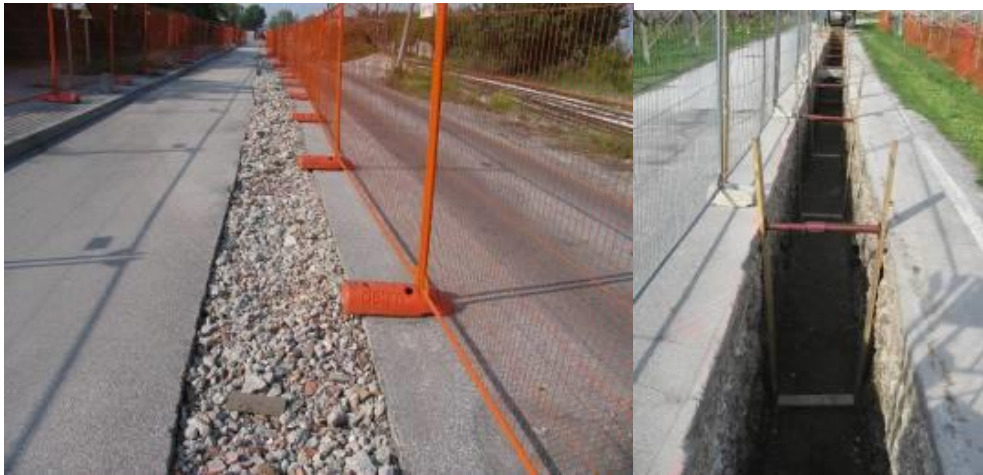
Figura 29: Taglio dell'asfaltatura e scavo aperto
