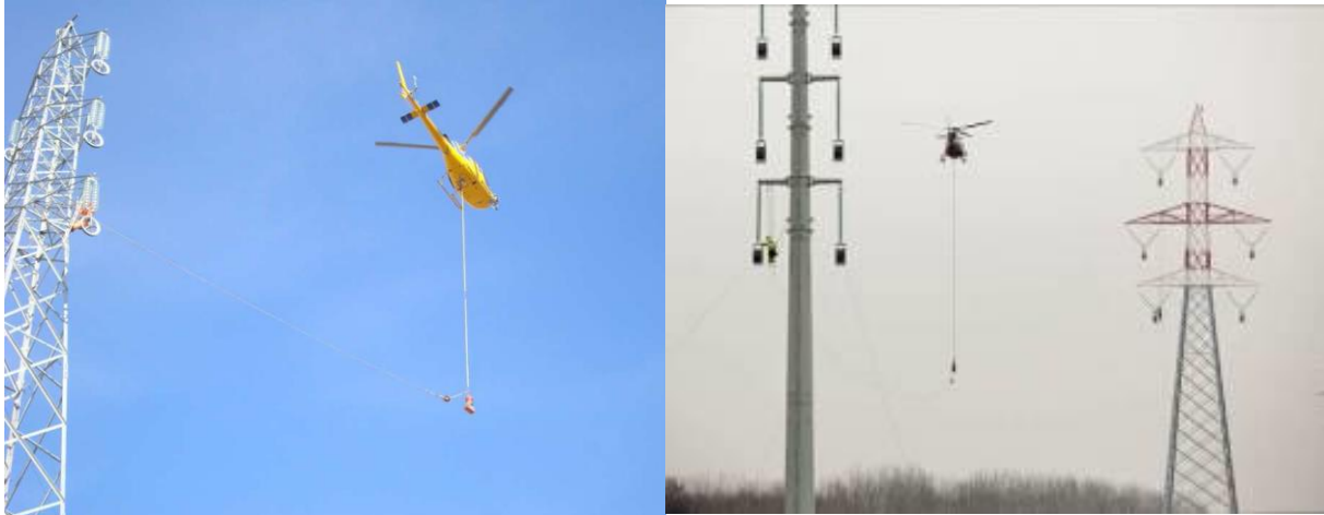
Figura 23: Utilizzo dell'elicottero per la stesura della fune pilota
