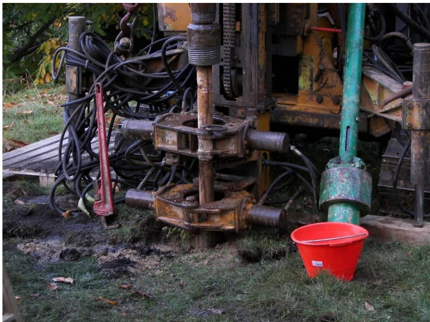
Figura 18: Macchina operatrice per la realizzazione di micropali tubfix; sistema di scavo a rotopercolazione
