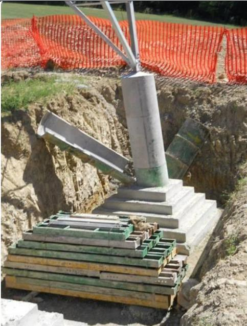
Realizzazione di fondazioni superficiali tipo CR per un sostegno a traliccio. Nell'immagine si può osservare una fondazione CR appena "scasserata". Si possono distinguere facilmente la parte inferiore a parallelepipedo tronco piramidale ed il colonnino di raccordo con la "base" del sostegno
