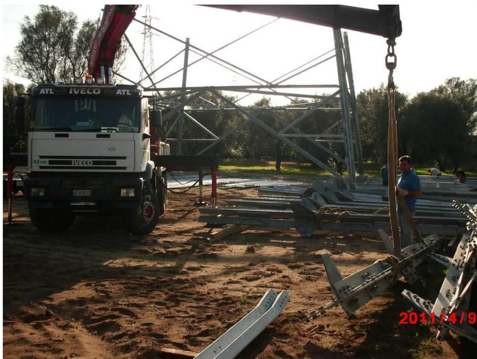
*Fasi di montaggio sostegno a traliccio*
