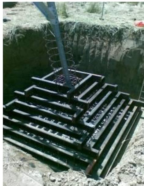
**Esempio di realizzazione di una fondazione a plinto con riseghe. Nell'immagine di sinistra si può osservare un disegno di progetto mentre nell'immagine di destra la fase di casseratura della fondazione**
