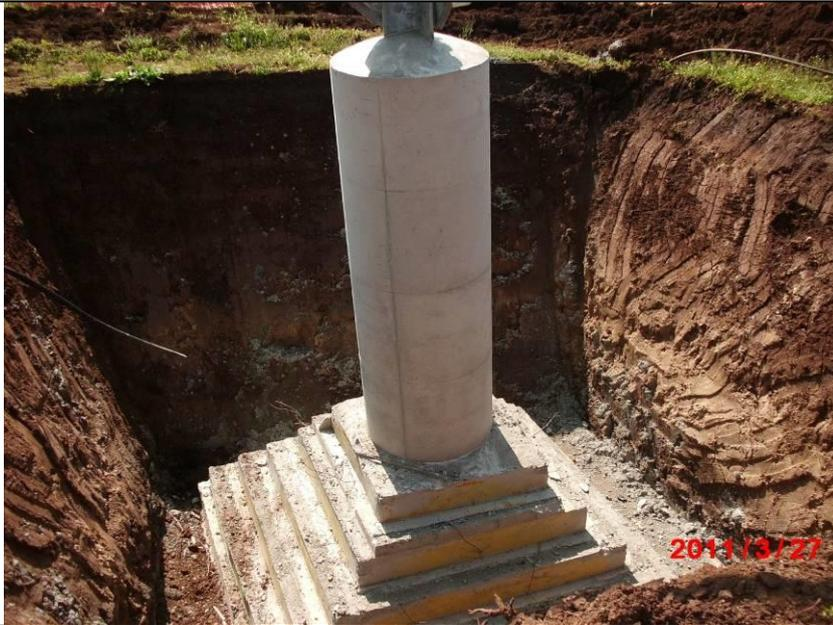
Realizzazione di fondazioni superficiali tipo CR per un sostegno a traliccio. Nell'immagine si può osservare una fondazione CR appena "scasserata". Si possono distinguere facilmente la parte inferiore a parallelepipedo tronco piramidale ed il colonnino di raccordo con la "base" del sostegno
