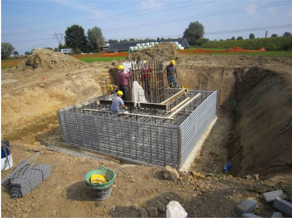
**Realizzazione di fondazione superficiale tipo plinto a monoblocco per un sostegno monostelo.**
