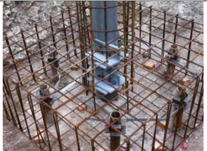
Esempio di realizzazione di una fondazione su micropali tipo tubfix. Nell'immagine di destra si può notare il particolare del raccordo tra i tubolari metallici dei micropali con l'armatura del plinto di fondazione; al centro del plinto si nota il moncone del sostegno (elemento di raccordo tra il sostegno e la fondazione) il quale viene annesso nella fondazione stessa
