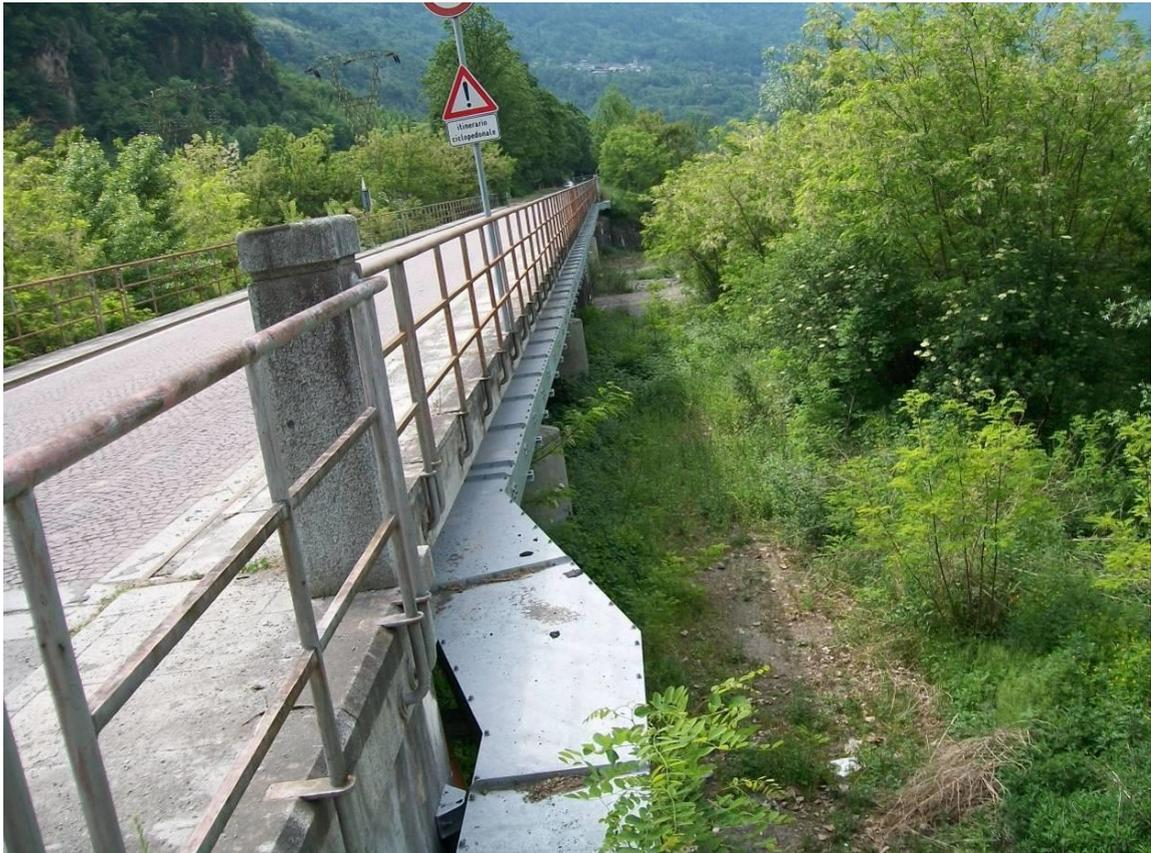
**Esempio di ancoraggio di tipo "scatolare"**
