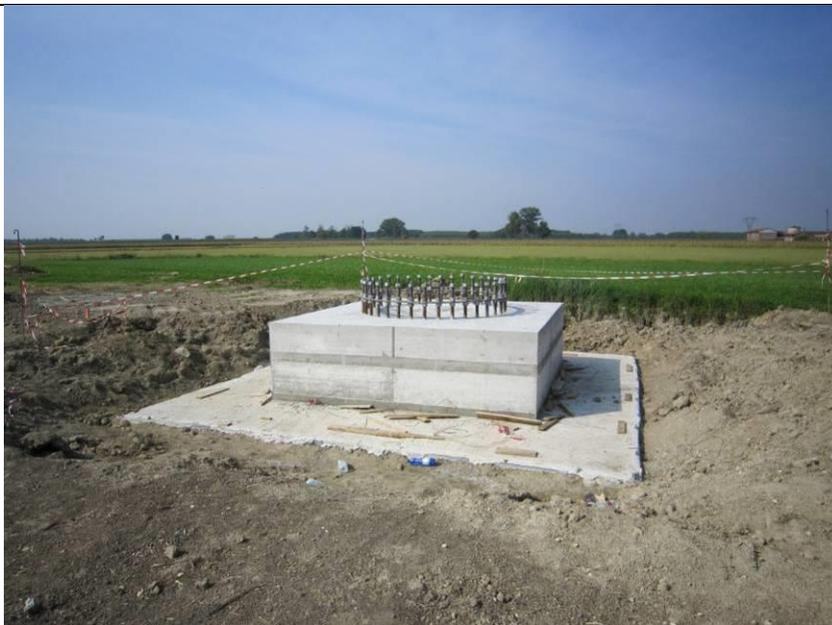
Realizzazione di fondazioni superficiali tipo plinto a monoblocco per un sostegno monostelo. Nell'immagine si può osservare una fondazione appena realizzata. Si può distinguere facilmente la flangia metallica dotata di tirafondi di raccordo con la parte in elevazione
