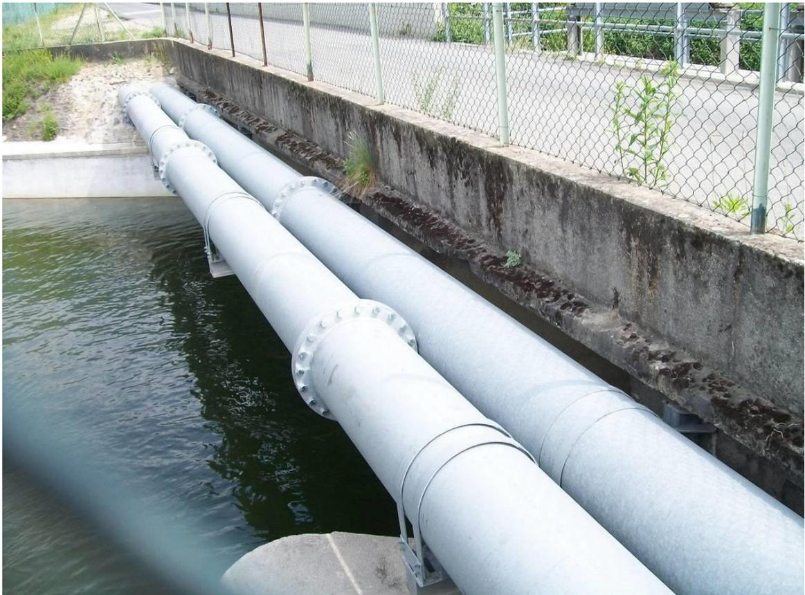
**Esempio di ancoraggio di tipo "tubiera". Si noti come in questo caso gli elettrodotti ancorati siano due.**
