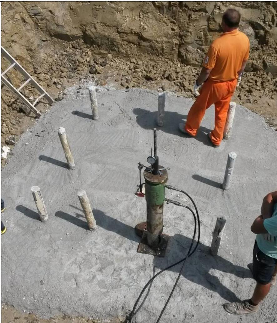
Realizzazione di micropali tipo tubfix per un sostegno a traliccio; si possono osservare i 9 micropali già realizzati ed iniettati; in questa fase, prima dell'armatura e cassatura del plinto di fondazione, si sta eseguendo una prova di tenuta del micropalo allo strappamento, al fine di verificare la corretta progettazione e realizzazione dello stesso
