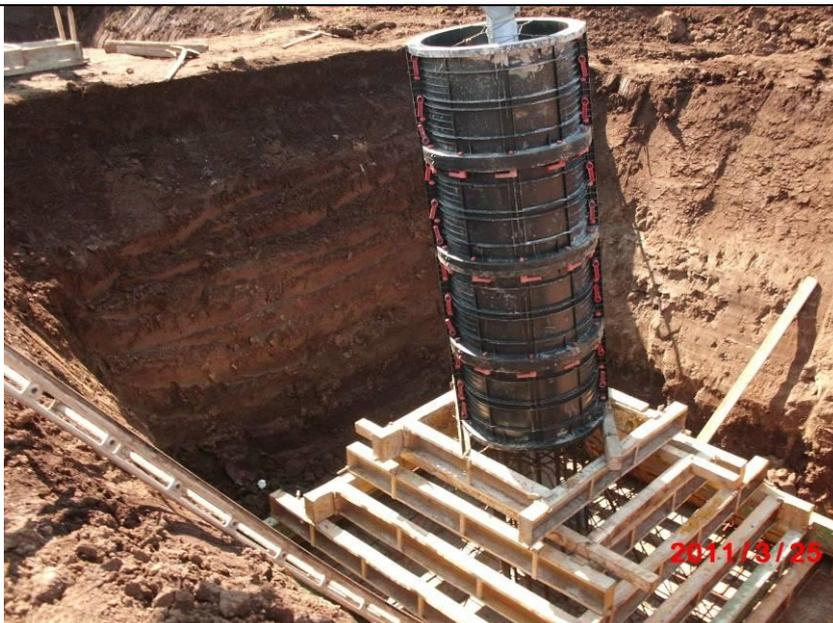
Realizzazione di fondazioni superficiali tipo CR per un sostegno a traliccio. Nell'immagine si può osservare la fase di cassatura
