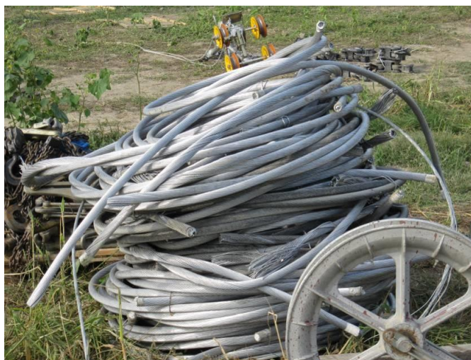
Fasi demolizione di un sostegno a traliccio
