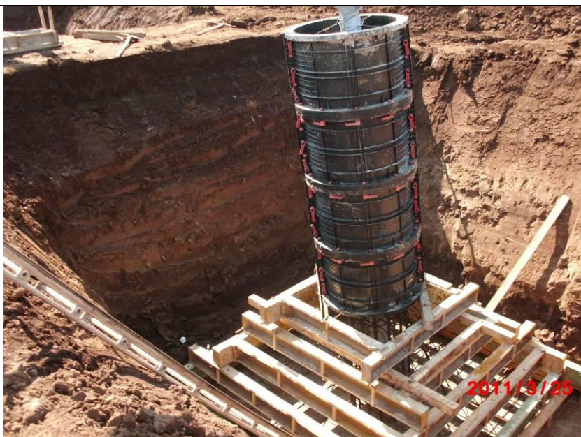
Esempio di realizzazione di una fondazione a plinto con riseghe. Nell'immagine di sinistra si può osservare un disegno di progetto mentre nell'immagine di destra la fase di cassatura della fondazione
