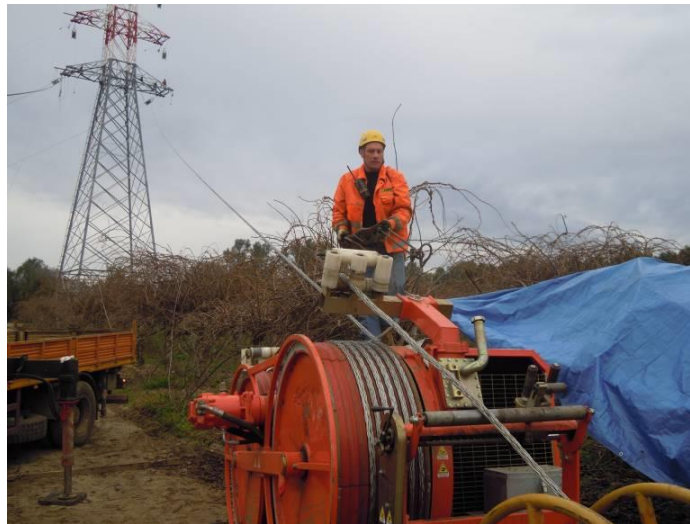
Fasi di tesatura della linea elettrica
