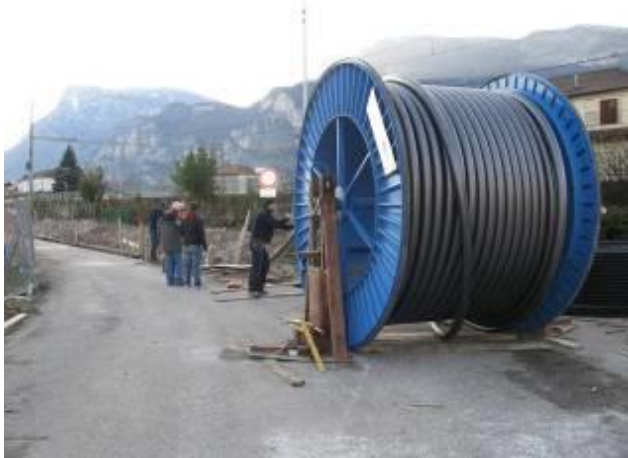
Posa rulli lungo lo scavo e stendimento del cavo
