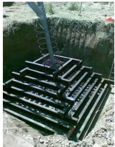
Esempio di realizzazione di una fondazione a plinto con riseghe. Nell'immagine di sinistra si può osservare un disegno di progetto mentre nell'immagine di destra la fase di cassatura della fondazione
