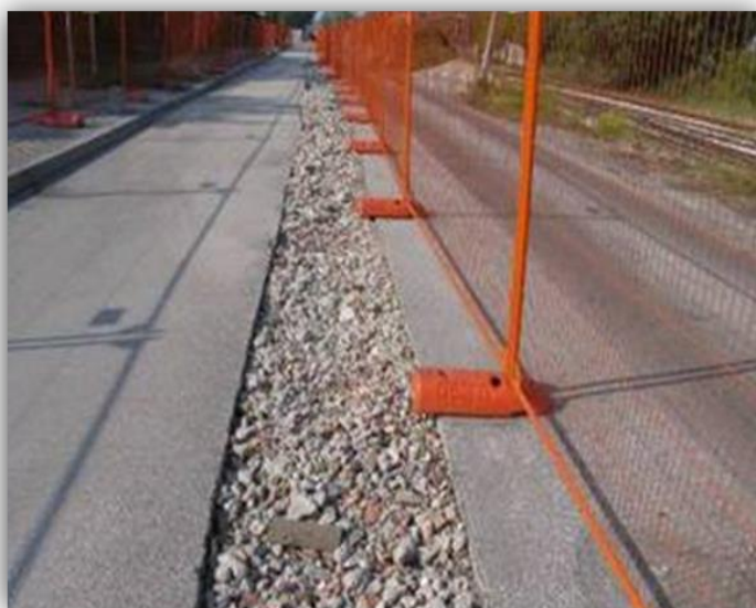
Taglio dell'asfaltatura e scavo aperto
