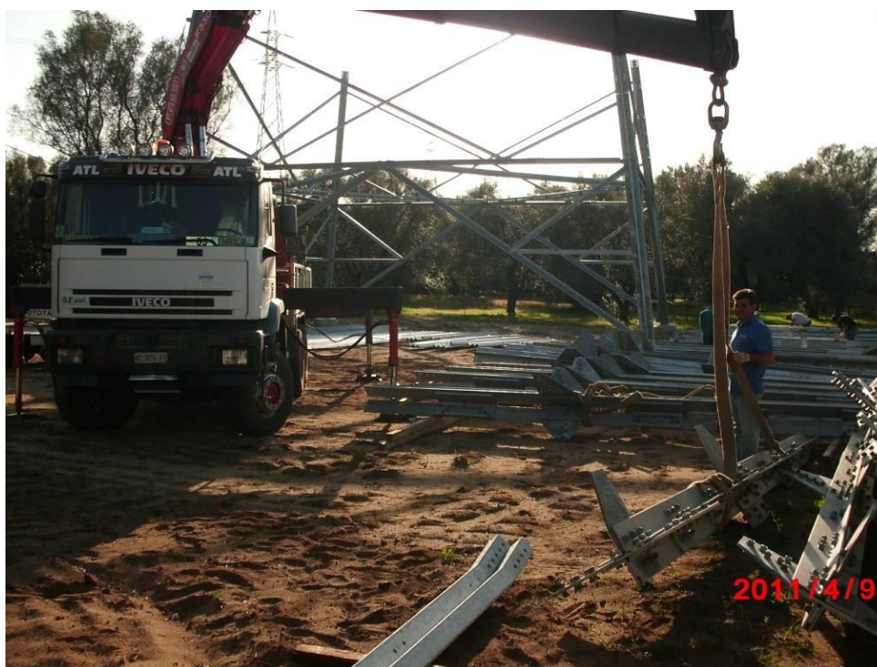
Fasi di montaggio sostegno a traliccio
