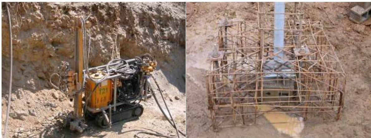
Esempio di fondazione con tiranti in roccia
