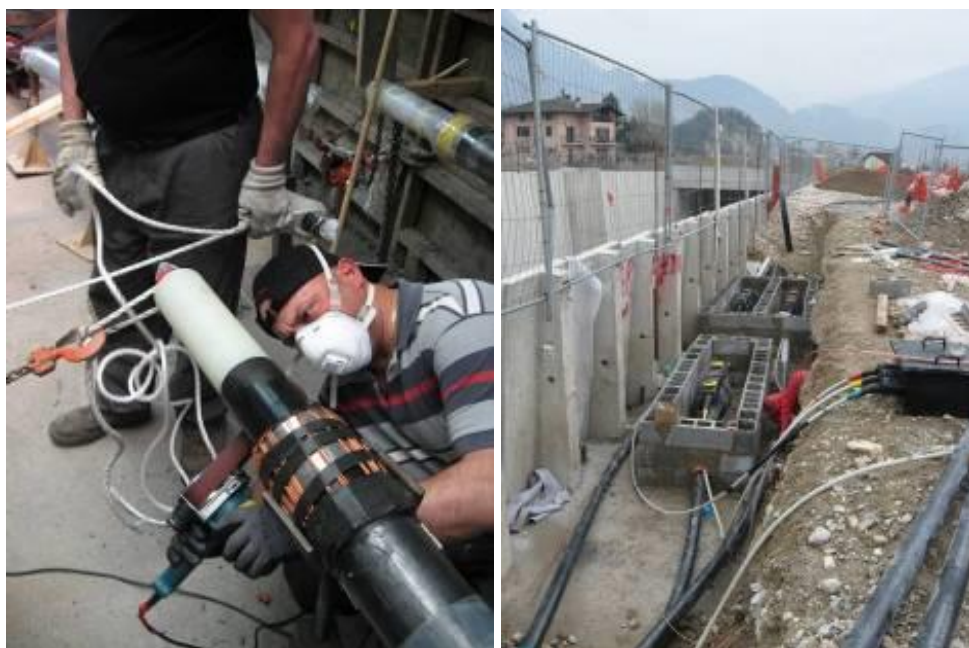
Esecuzione giunto esempio di buca giunti
