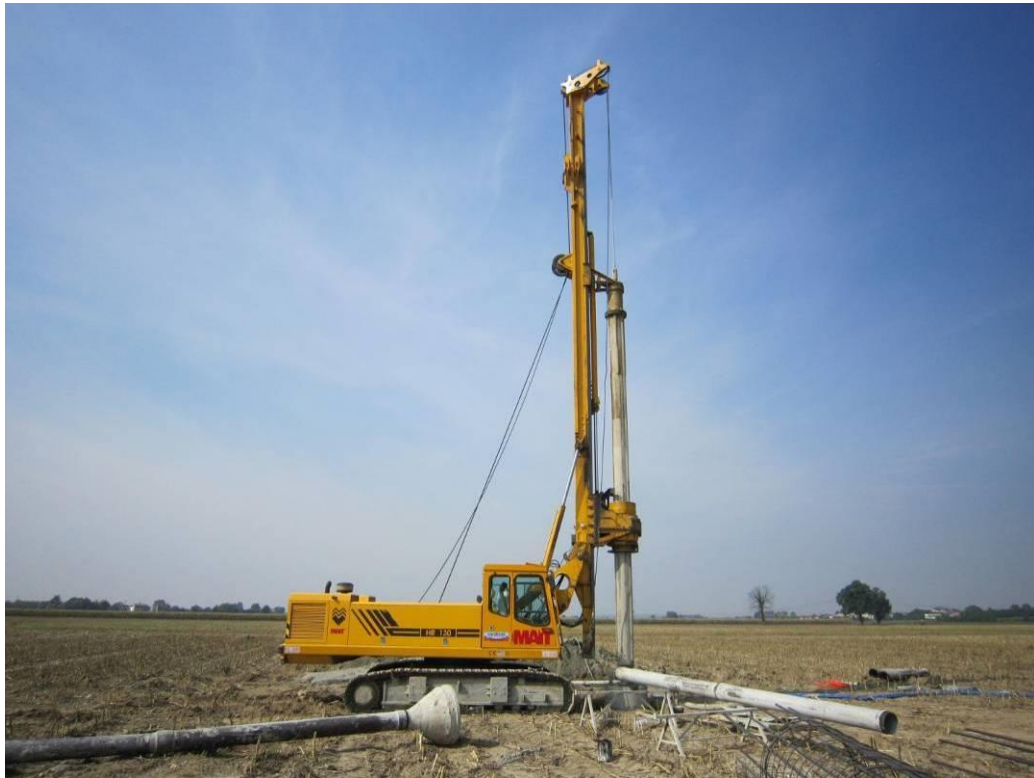
Macchina operatrice per la realizzazione di pali trivellati
