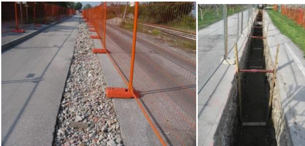
Taglio dell'asfaltatura e scavo aperto
