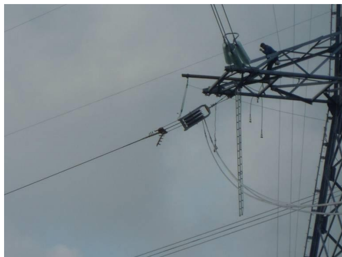
Fasi di tesatura della linea elettrica
