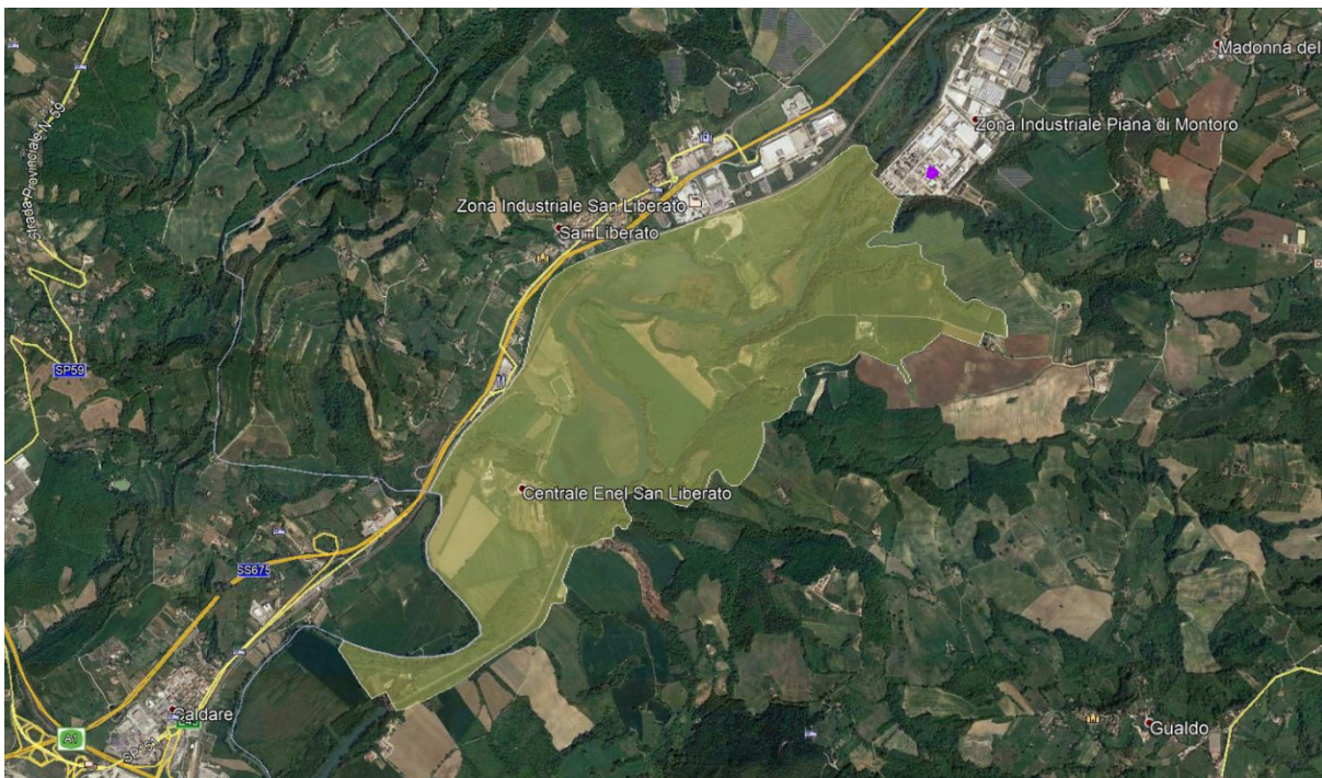
Figura 1 Localizzazione su foto aerea della ZSC/ZPS "Lago di San Liberato" (in giallo il sito tutelato, in viola l'area di intervento; fonte immagine: Google earth)
