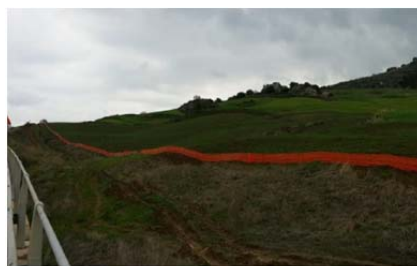
5. Morfologie ondulate e corrispondenze a monte del viadotto Ferruzze 2.
