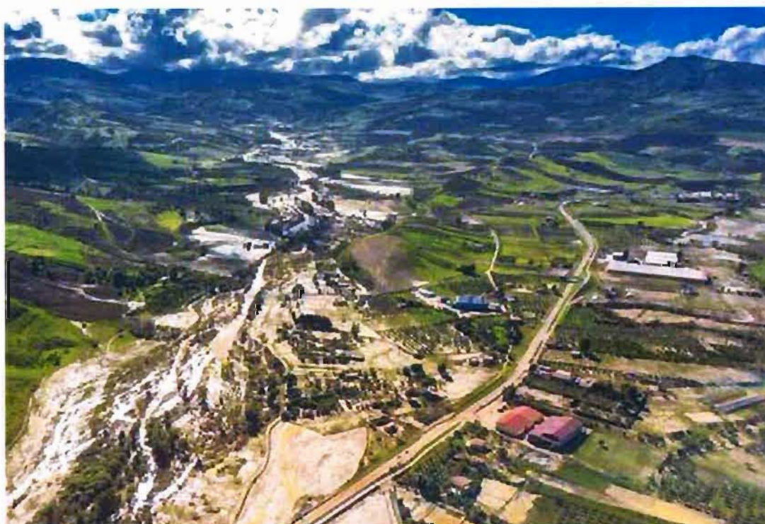
04/11/2018 – Zona AP18/Viadotto Esistente San Leonardo
