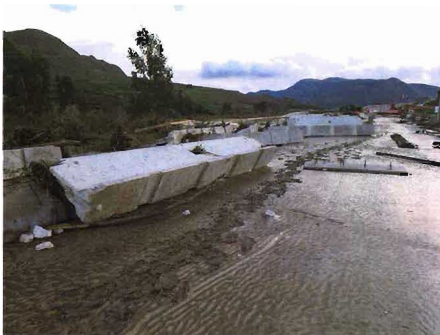
03/11/2018 - Viadotto San Leonardo (direzione AG)
