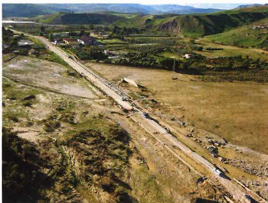
05/11/2018 – Zona AP18/Viadotto Esistente San Leonardo
