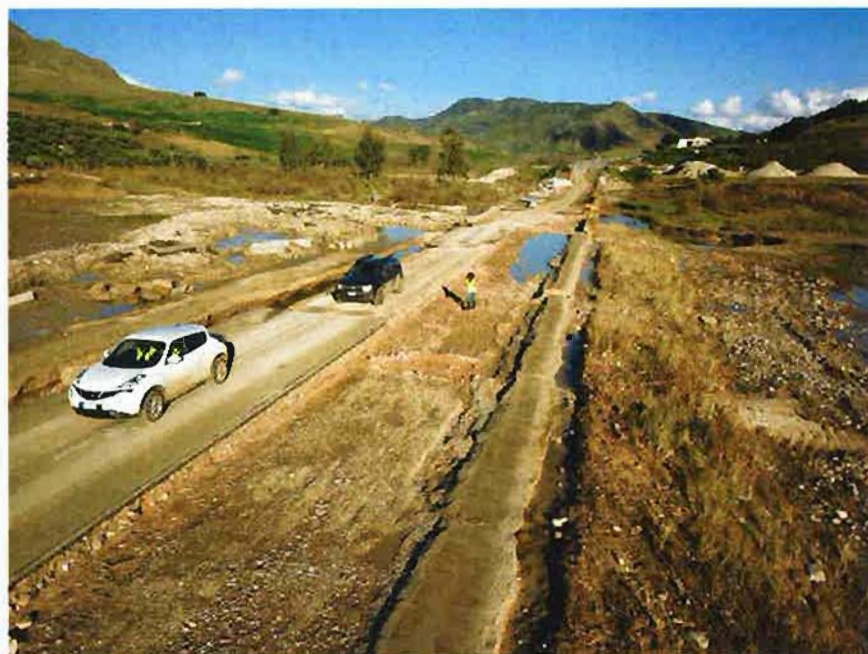
05/11/2018 – Zona AP18/Viadotto Esistente San Leonardo
