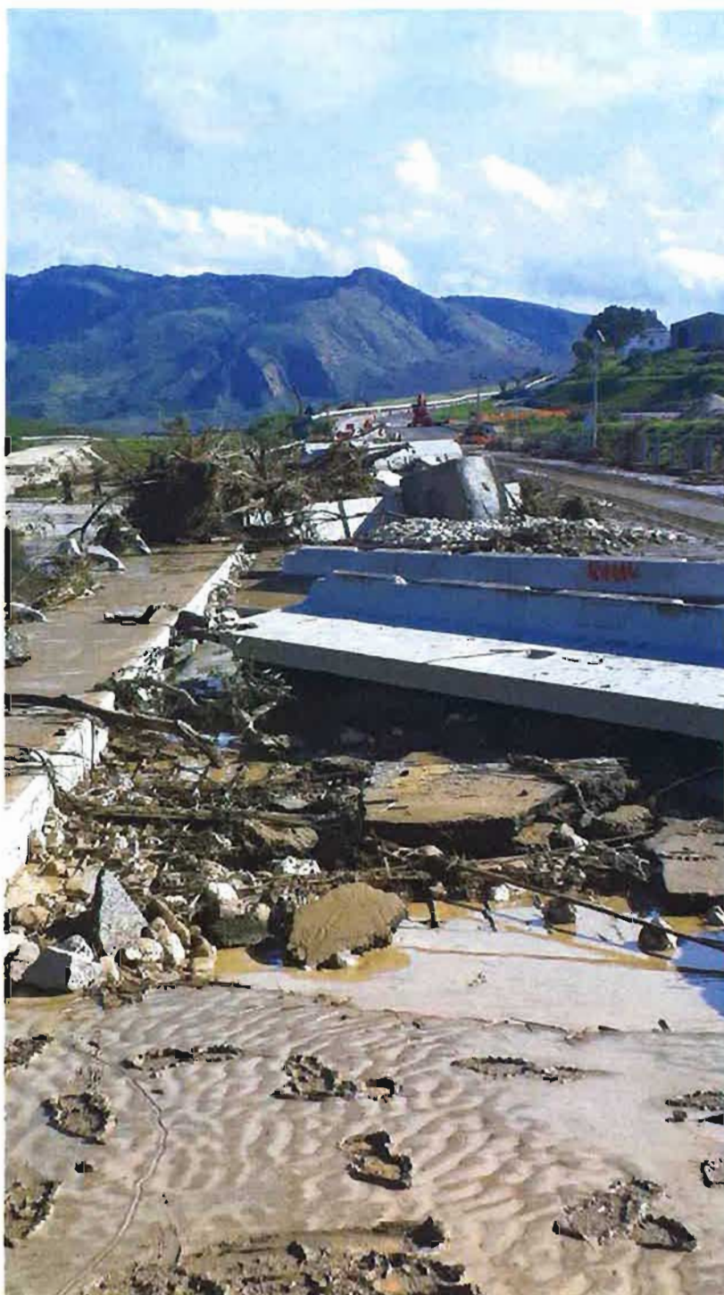
03/11/2018 - Viadotto San Leonardo (direzione AG)
