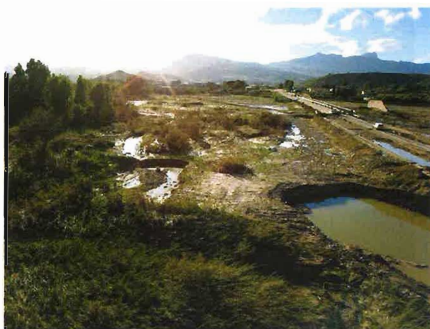
05/11/2018 – Zona AP18/Viadotto Esistente San Leonardo
