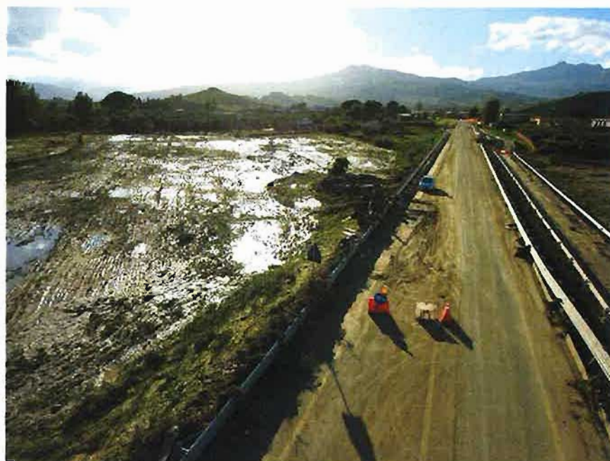
05/11/2018 – Zona AP18/Viadotto Esistente San Leonardo
