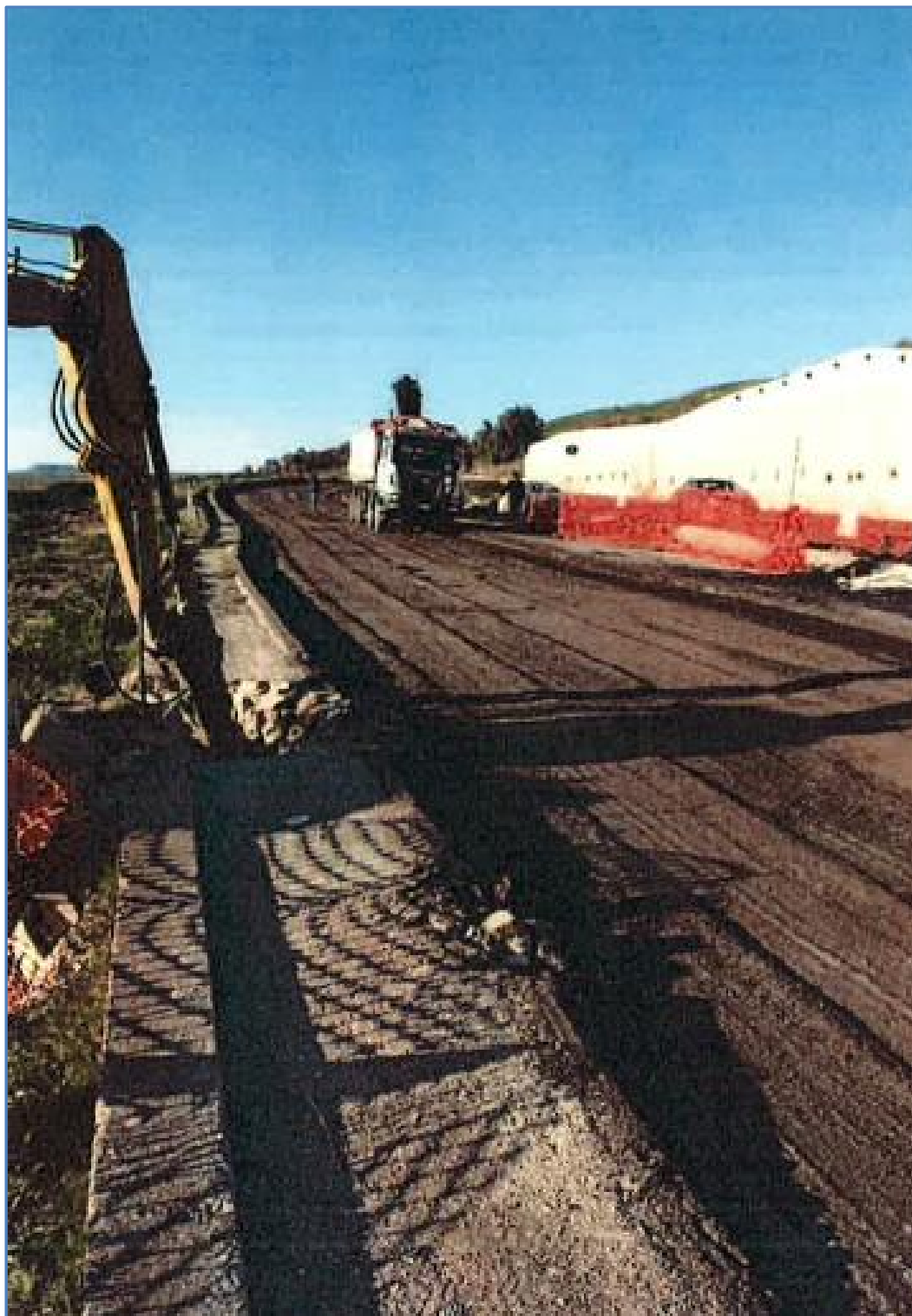
Figura n. 5 – Immagine fotografica del cordolo in sx tra la Sez. 1701 e la Sez. 1705 del tratto AP30_PA.
