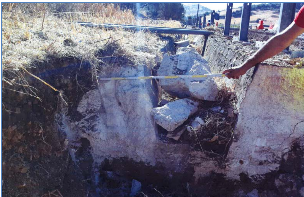
Figura n. 4 – Immagine fotografica del manufatto in c.a. – tipo "B"
