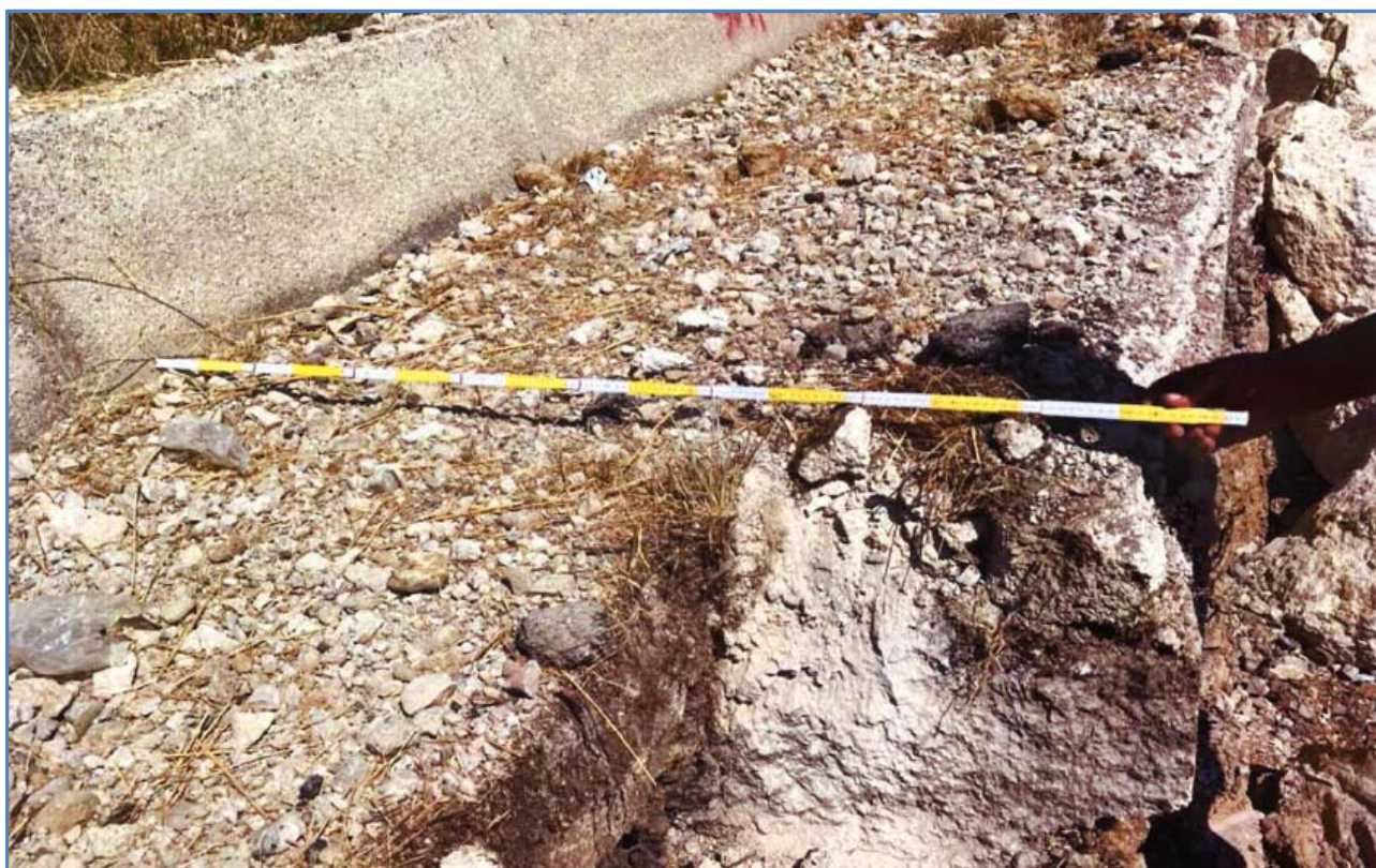
Figura n. 6 – Immagine fotografica del manufatto in c.a. – tipo "C"
