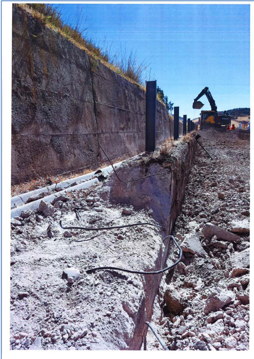
Figura n. 2 – Immagine fotografica del manufatto in c.a. – tipo "A"
