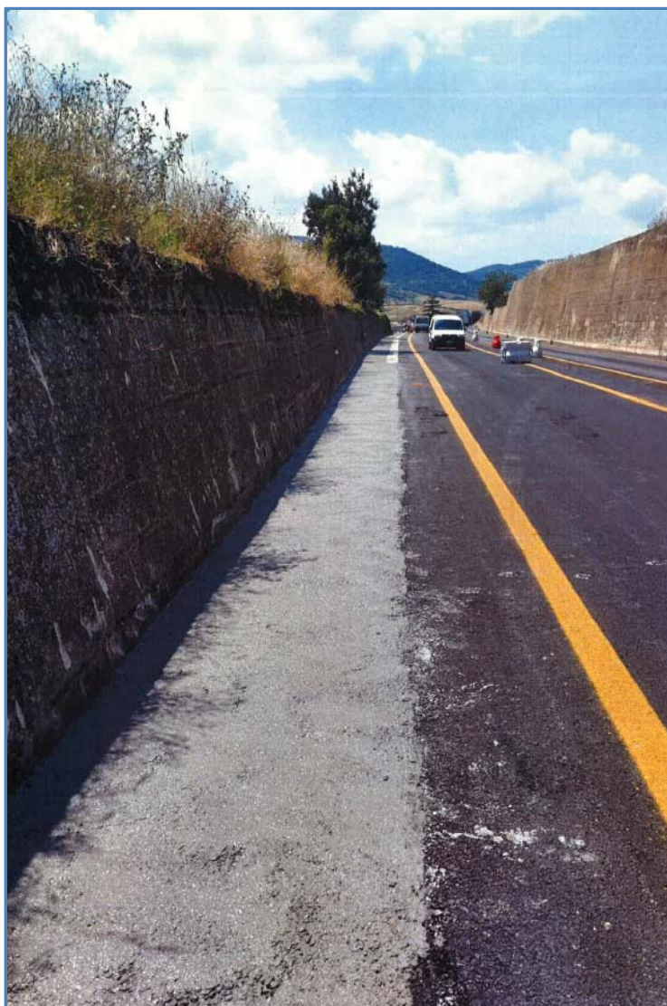
Figura n. 11 – Immagine fotografica dello strato in calcestruzzo magro realizzato al di sopra della fondazione del muro in dx compreso tra la Sez. 702 + 7,00 m e la Sez. 711 + 17 m.
