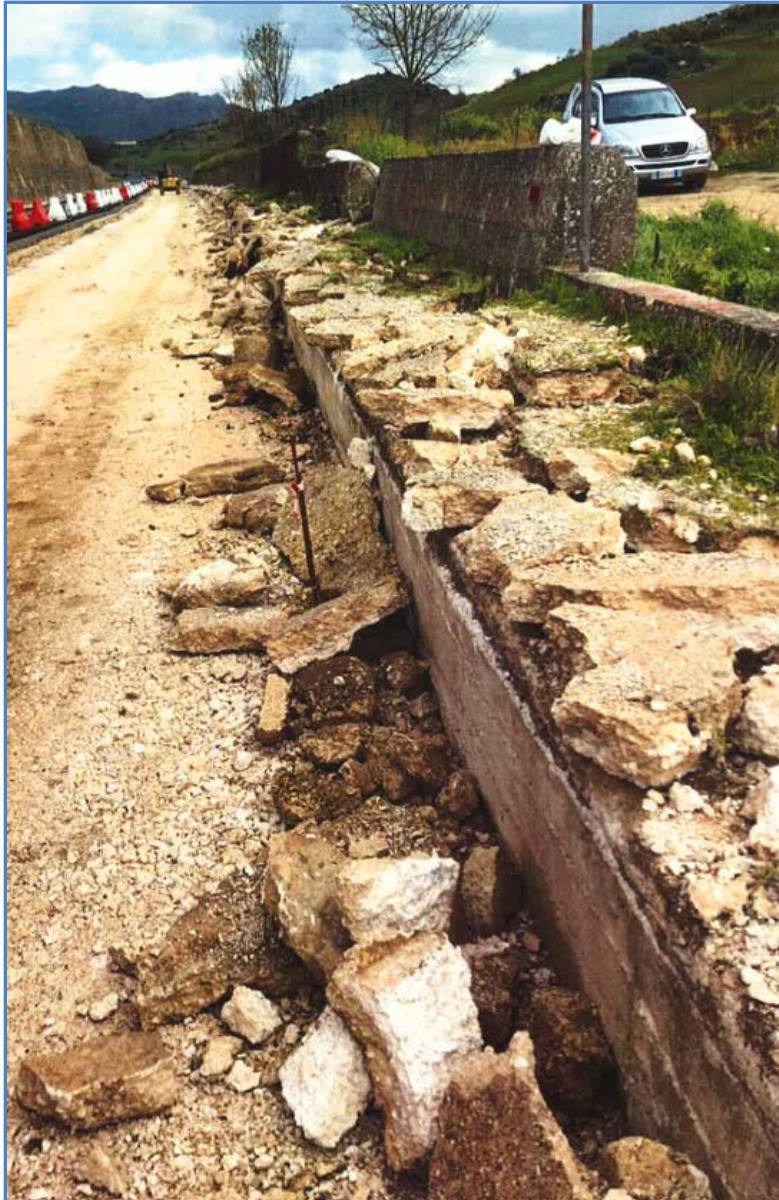
Figura n. 9 – Immagine fotografica degli strati di materiale presente sulla fondazione del muro in dx tra la Sez. 702 + 7,00 m e la Sez. 711 + 17 m.
