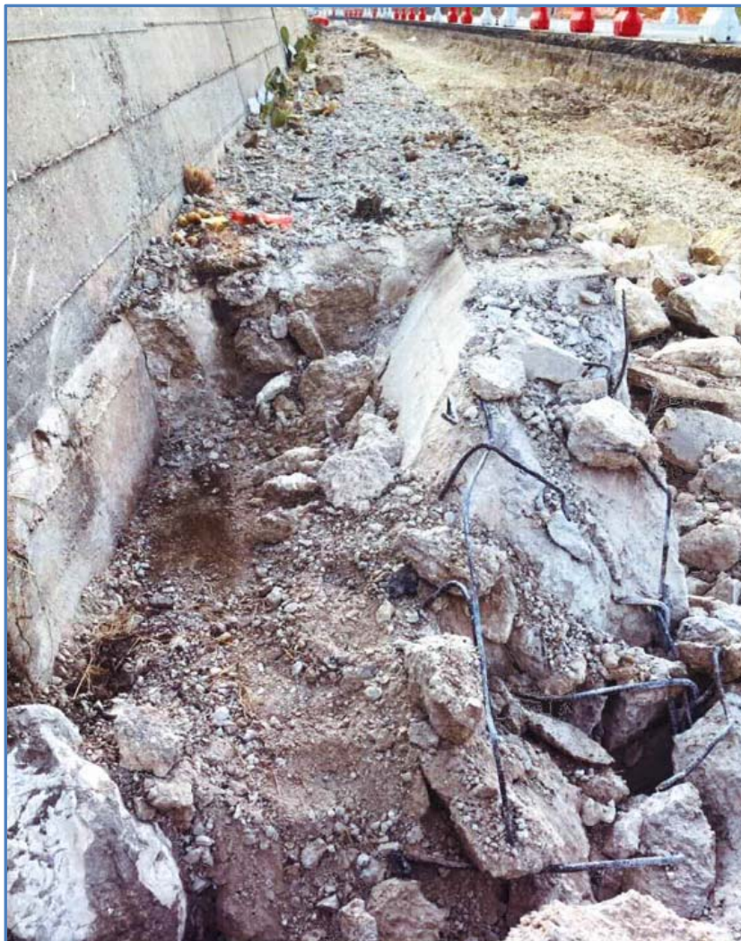
Figura n. 8 – Immagine fotografica del manufatto in c.a. – tipo "D"
