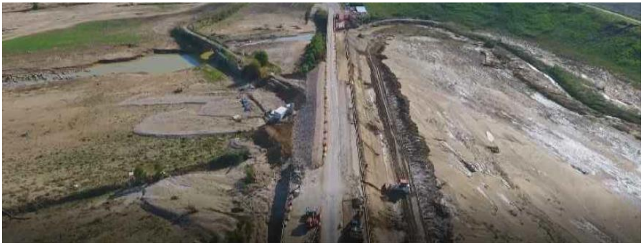
Figura 1 Foto da drone dell’area in esame a seguito dell’evento di novembre 2018; a destra i danni provocati al rilevato del tratto AP15
