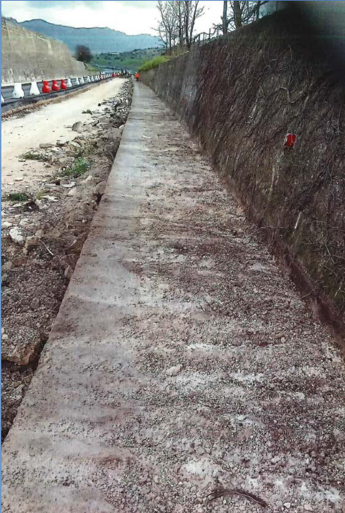
Figura n. 3 – Immagine fotografica della fondazione del muro in dx del tratto di asse principale AP11 compreso tra la Sez. 702 + 7,00 m e la Sez. 711 + 17 m, sul quale sono stati rimossi gli strati in conglomerato cementizio e bitumino aventi spessore 20 cm
