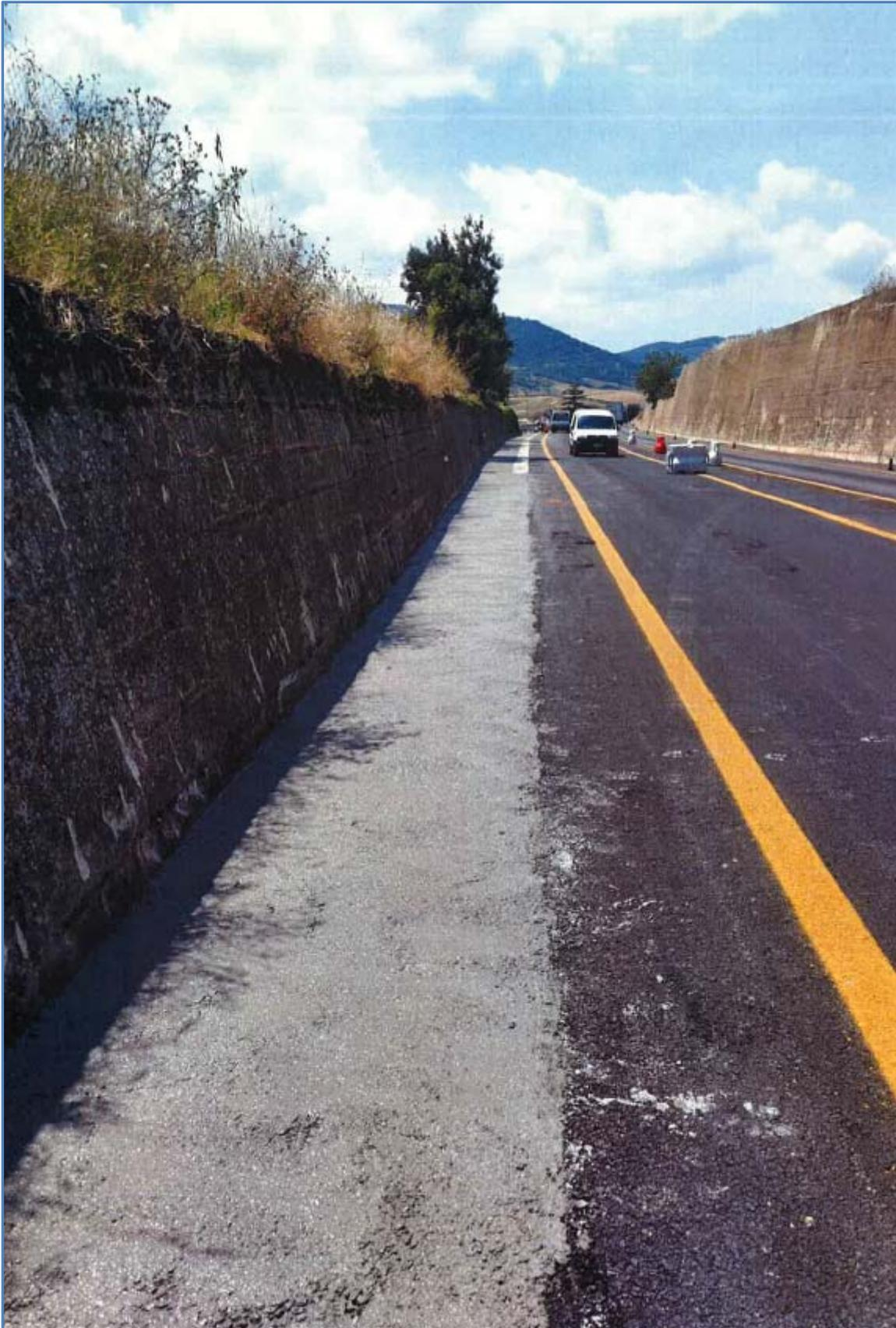
Figura n. 4 – Immagine fotografica dello strato in calcestruzzo magro realizzato al di sopra della fondazione del muro in dx compreso tra la Sez. 702 + 7,00 m e la Sez. 711 + 17 m.
