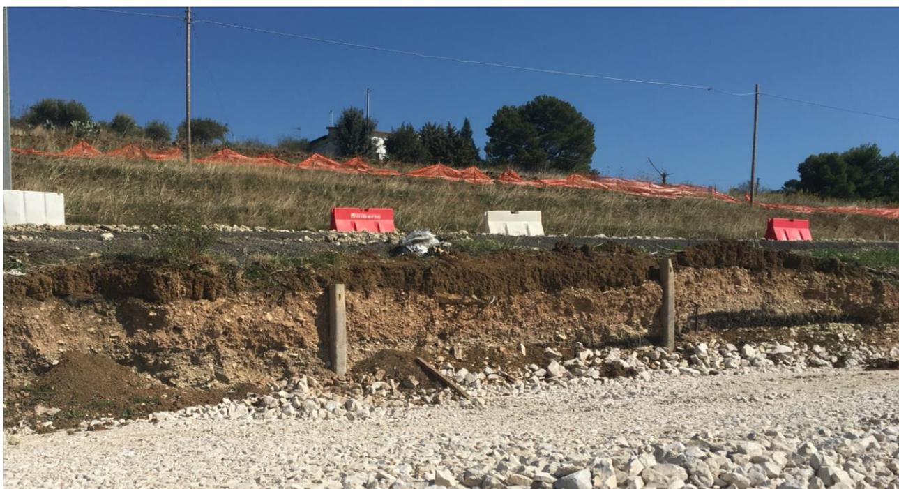
*Fig. 1. Sezione stradale n.282 - sostegni delle vecchie barriere stradali e vecchia pavimentazione ricoperti da successive ricariche di materiale da rilevato.*
