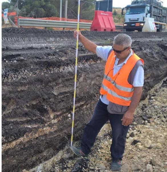
*Fig. 2. Sezione stradale n.288 – abnorme spessore di conglomerato bituminoso che testimonia le ripetute ricariche di asfalto eseguite nel tempo.*
