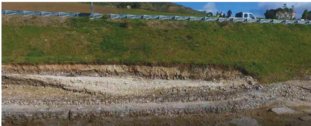
Figura 1 Foto dell’area in esame a seguito dell’evento alluvionale di Novembre 2018
