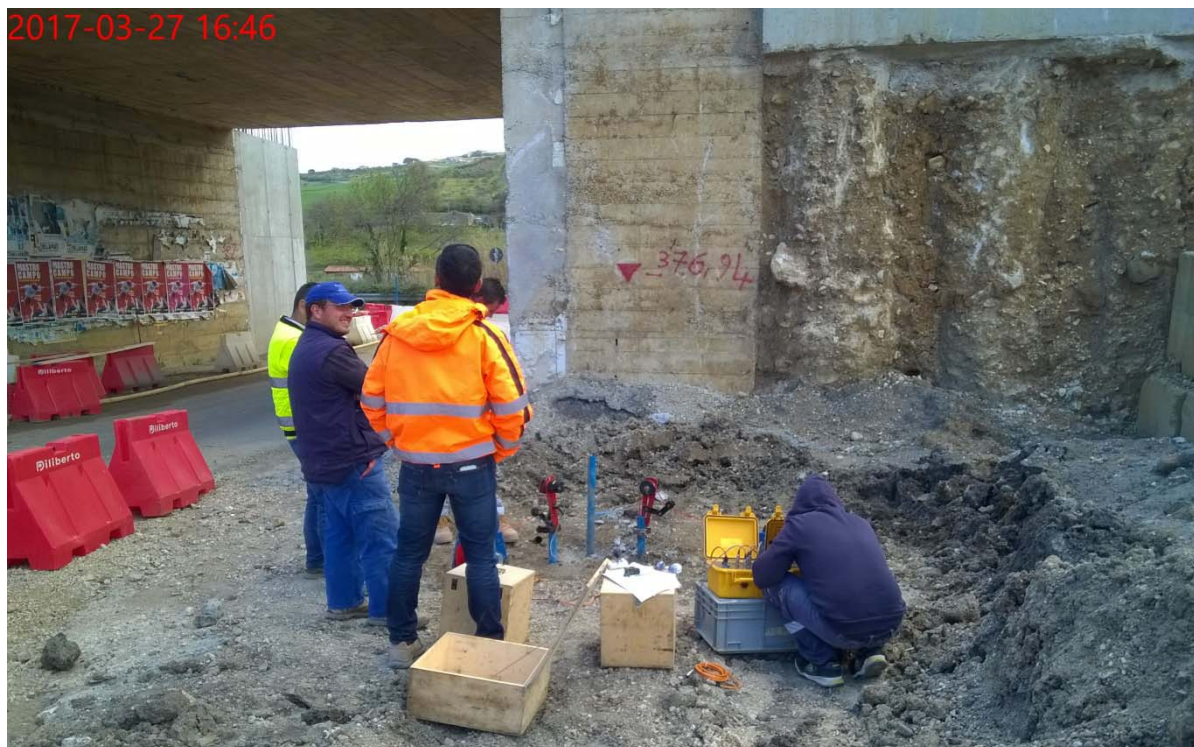
Figura 4 – Muro di risvolto esistente solidale al sottovia ST05.
