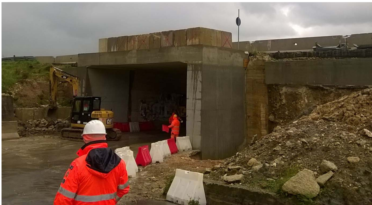
Figura 3 – Muro di risvolto esistente solidale al sottovia ST05.
