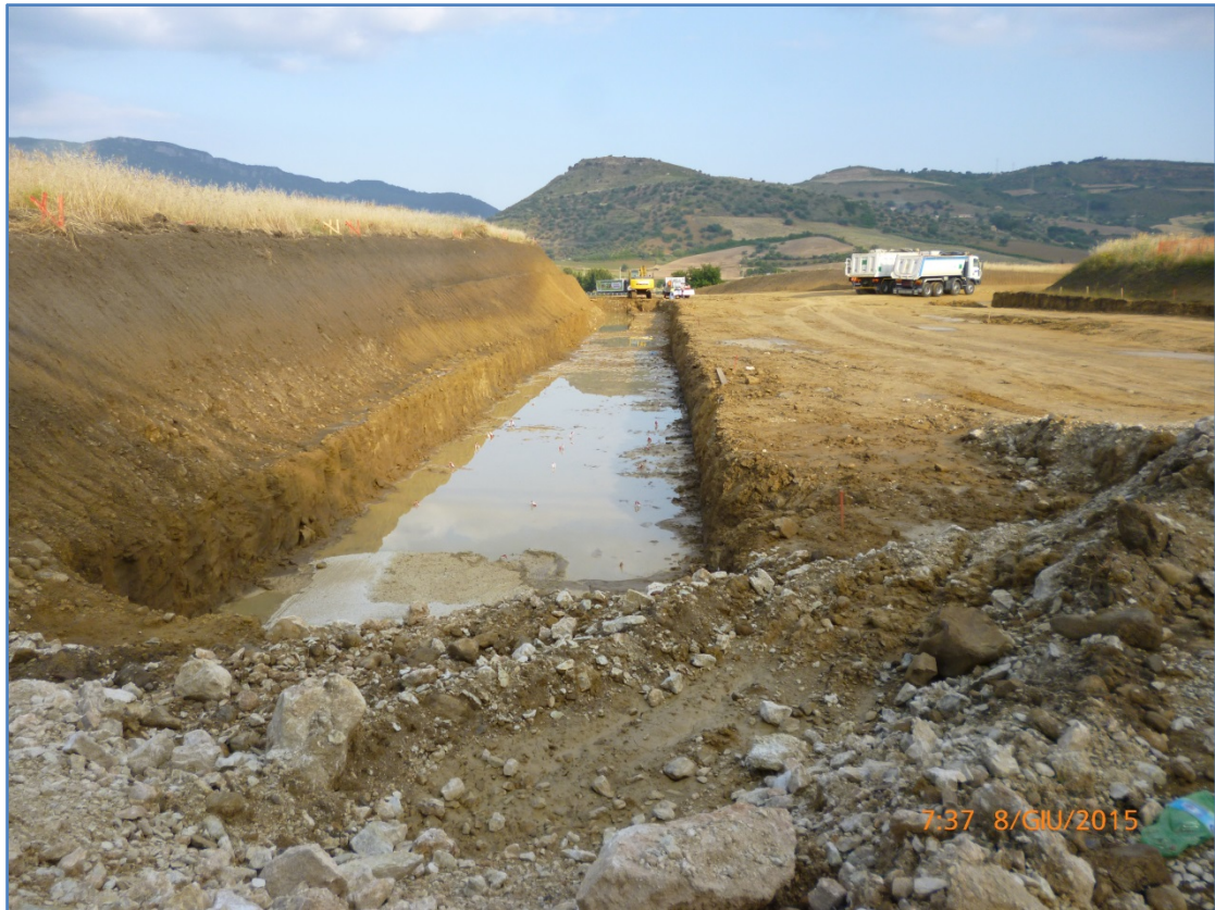
Figura 3 – Sezione di scavo muro di sostegno OS99.
