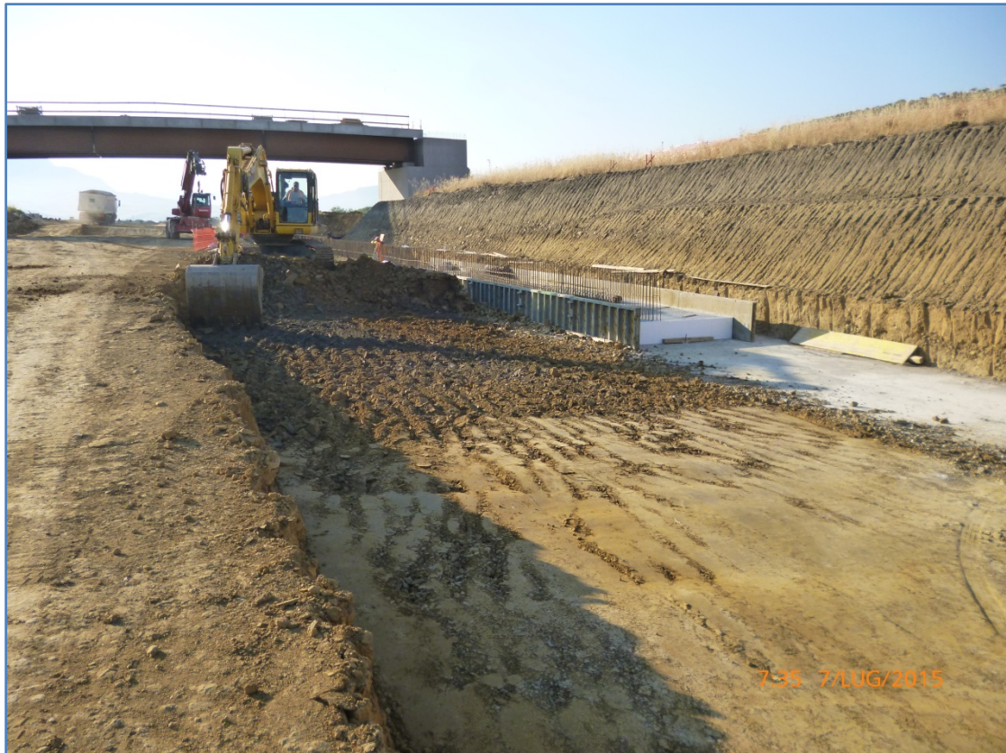
Figura 5 – Sezione di scavo muro di sostegno OS99.
