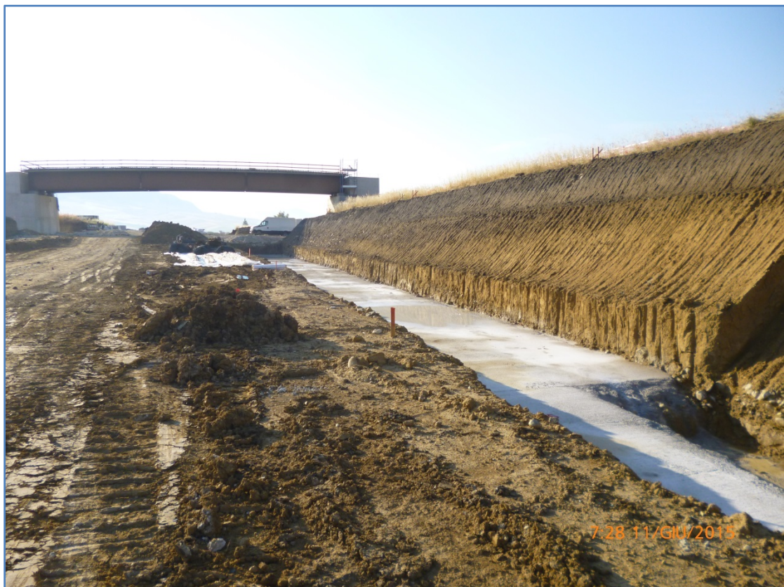
Figura 4 – Sezione di scavo muro di sostegno OS99.
