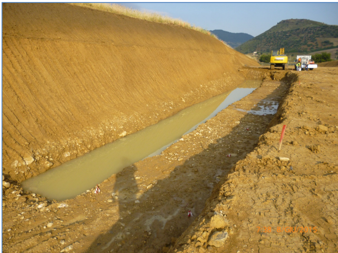
Figura 6 – Sezione di scavo muro di sostegno OS99.
