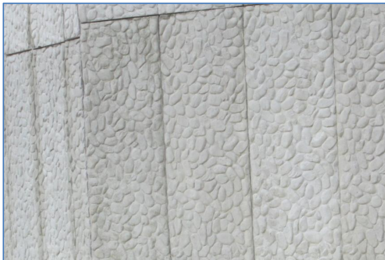
Figura 4 – Lastra prefabbricata impiegata per rivestimento della paratie.
