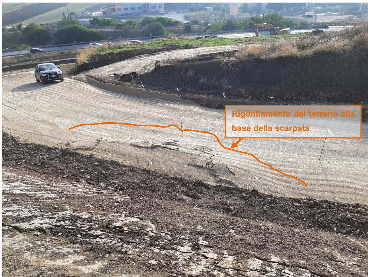
Figura 7: Foto scatta durante il sopralluogo: alla base della scarpata si evidenzia il rigonfiamento a seguito del movimento franoso.
