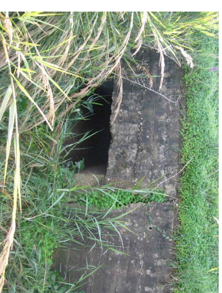
Manufatto di sbocco
