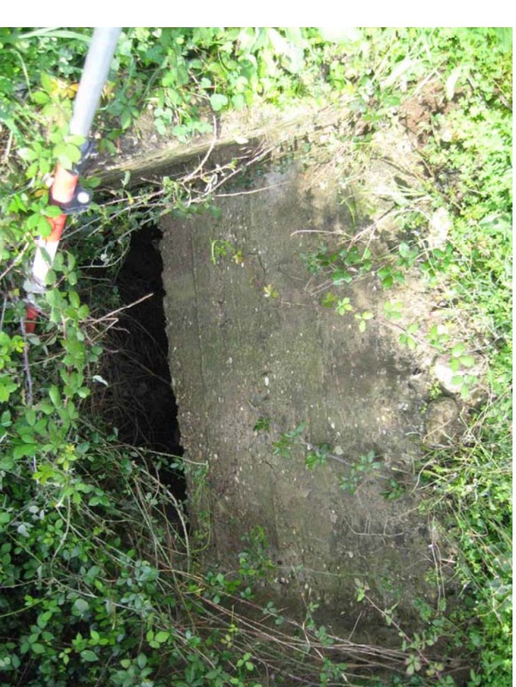
Manufatto di imbocco
