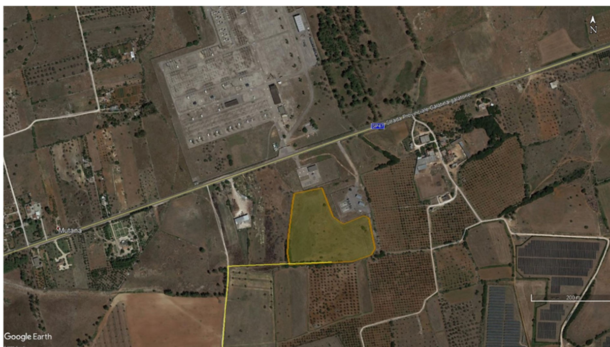
Figura 5.5: Vista della particella per la SE Lato Connessione
