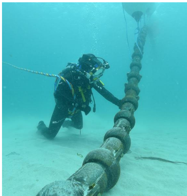
Figura 3.8: Esempio di metodo di posa con gusci di protezione
