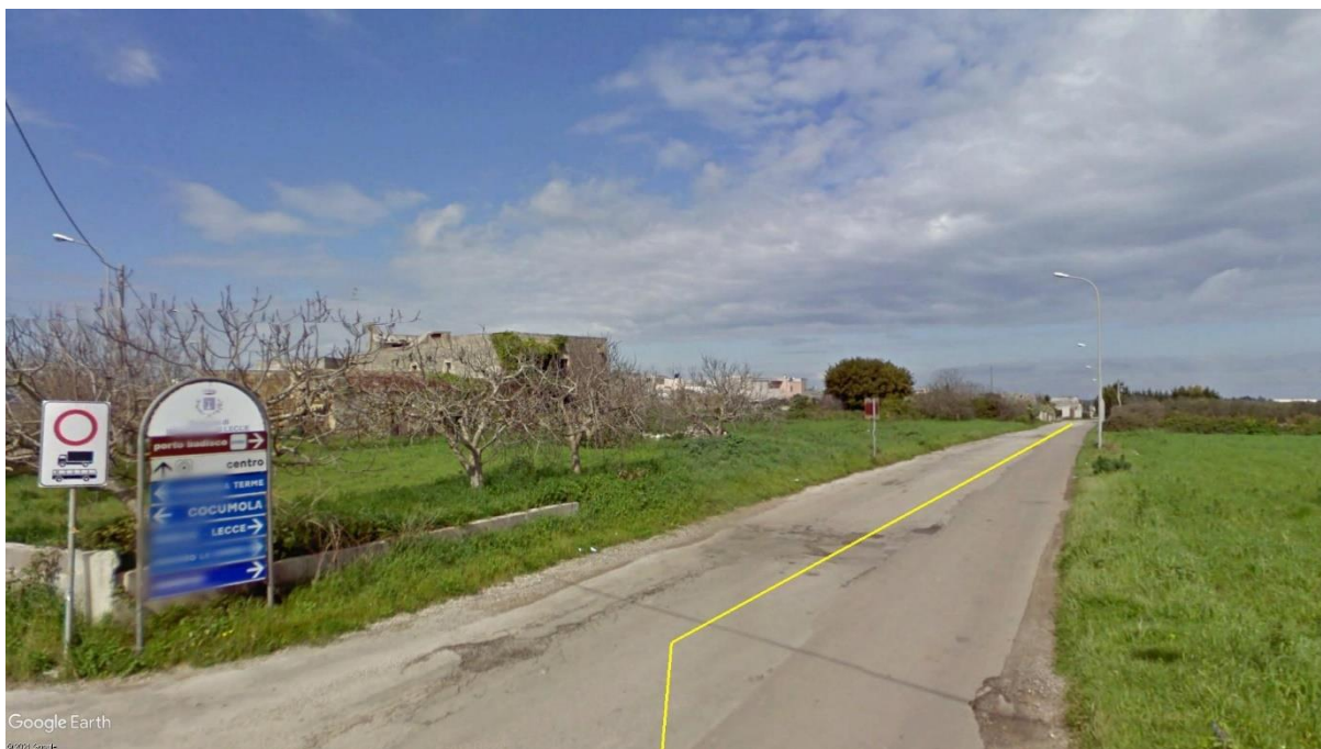
Vista 13: Deviazione su Via Fontanelle.
