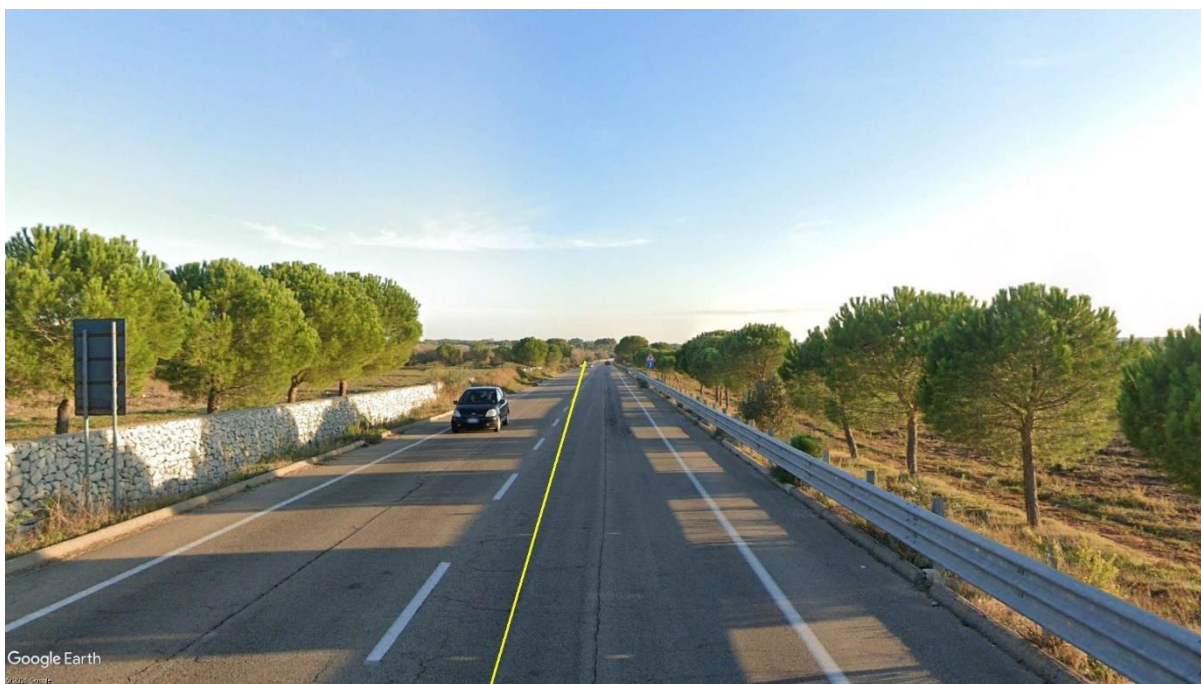
Vista 31: Continuazione su Tangenziale di Maglie in direzione SP363.
