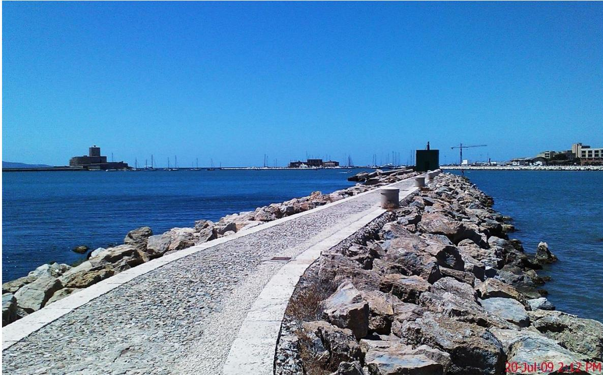
Figura 28. Attuale configurazione del tronco di radicamento a terra dello sporgente Ronciglio.
