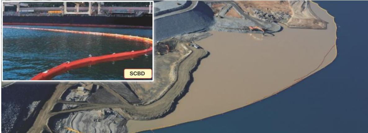
Figura 35. Utilizzo del barrieramento galleggiante modello "SALL S-CBD" per prevenire e limitare la dispersione di torbidità nelle aree di escavo marino.
