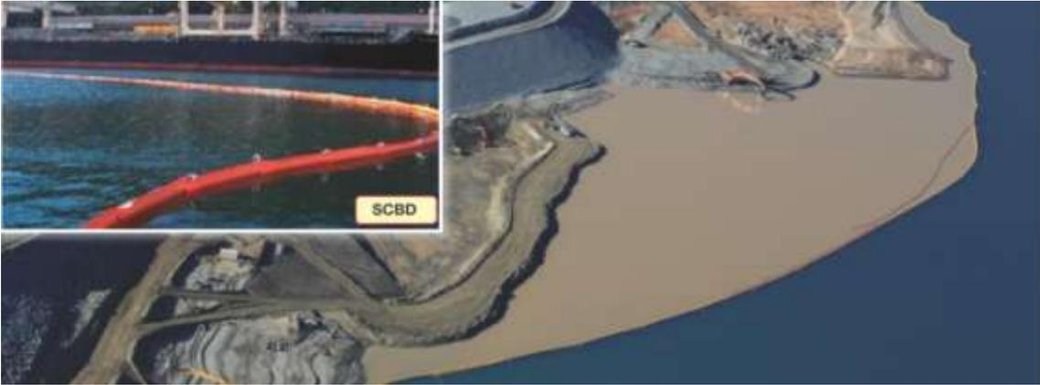
*Figura 4-3 Utilizzo del barrieramento galleggiante modello "SALL S-CBD" per prevenire e limitare la dispersione di torbidità nelle aree di escavo marino.*
