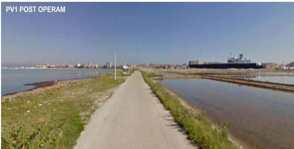
Figura 6-3 PV1 - Confronto ante e post lavori di salpamento ex diga
