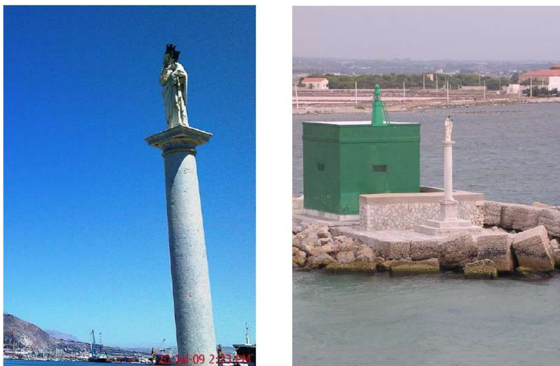
Figura 3-3 Installazioni sulla testata dello sporgente Ronciglio: vecchio fanale luce verde e colonna con statua Mariana.
