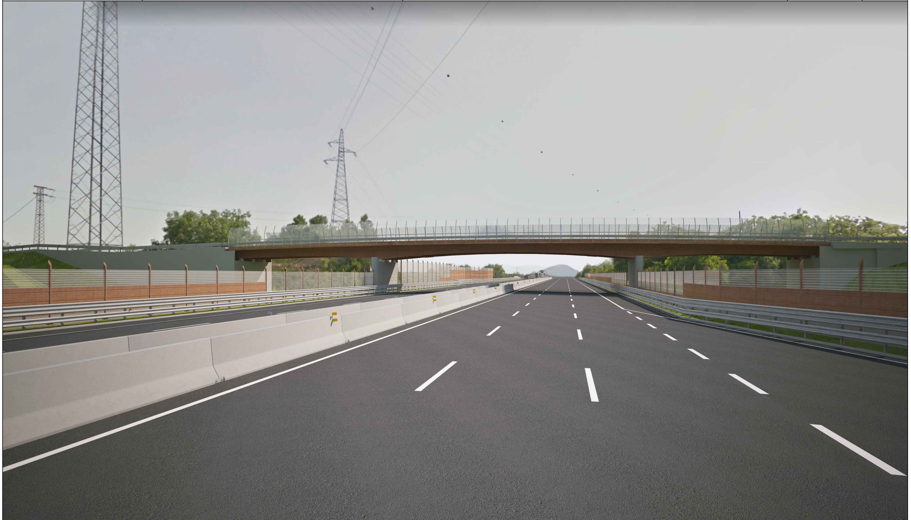
IMMAGINE B (POST OPERAM) -VISTA DIREZIONE SUD
