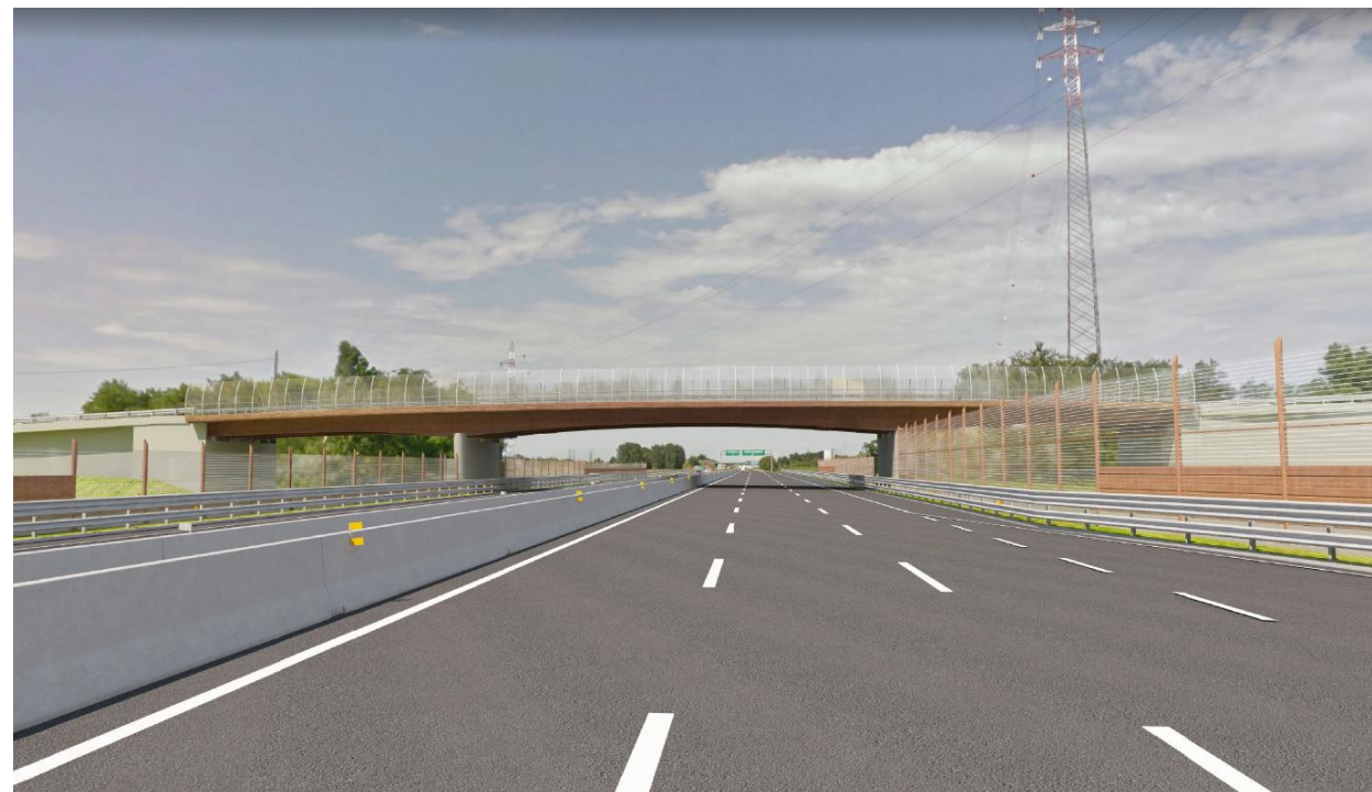
Figura 4-22. Fotoinserimento del cavalcavia di progetto "CV03" a tre luci, vista carreggiata nord. In carreggiata nord barriere acustiche h 5 m, in carreggiata sud barriere acustiche h 3 m. Per rendere simmetrico il trattamento delle due barriere e la percezione del cavalcavia si prevedono 11 campate trasparenti per entrambe i lati
