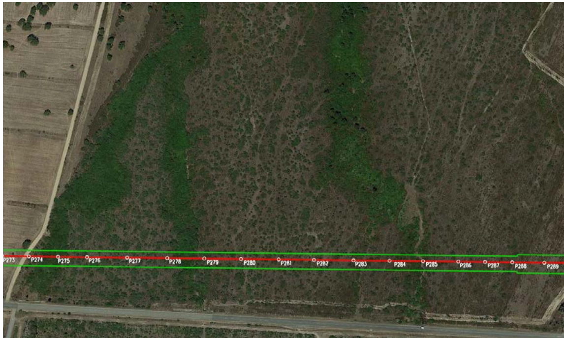
FOTO AEREA 6: Tratto P274 - P288 - la zona delimitata dalle linee verdi rappresenta la fascia ristretta di lavoro per come previsto dalla GASD C 13.40.10.02
