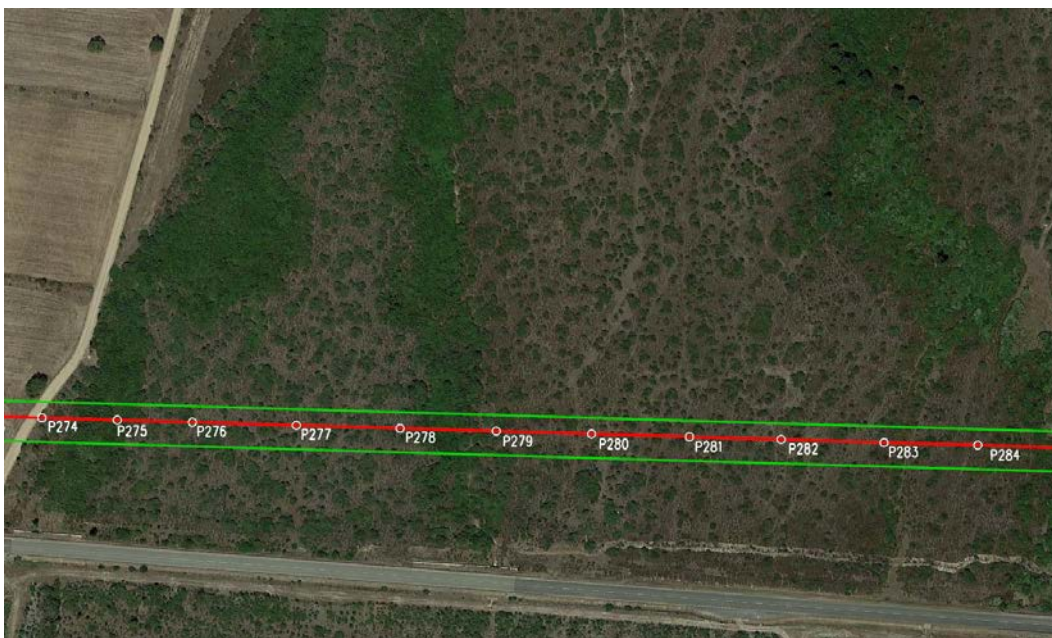
FOTO AEREA 12: Tratto P274 – P284 - la zona delimitata dalle linee verdi rappresenta la fascia ristretta di lavoro per come previsto dalla GASD C 13.40.10.02
