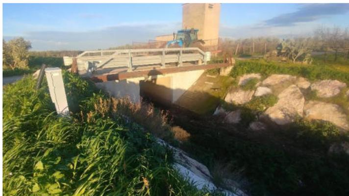
*Figura 5.13: Stato di fatto – Canale Pidocchiosa in corrispondenza dell’interferenza P05, sopralluogo gennaio 2021.*
