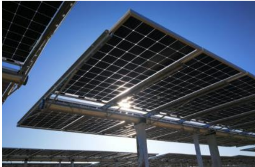
Figura 3.2: Esempio di struttura a tracker monoassiale.
