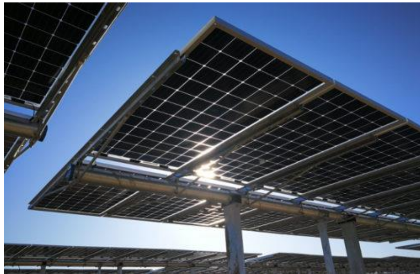
Figura 2.9 Esempio di struttura a tracker monoassiale
