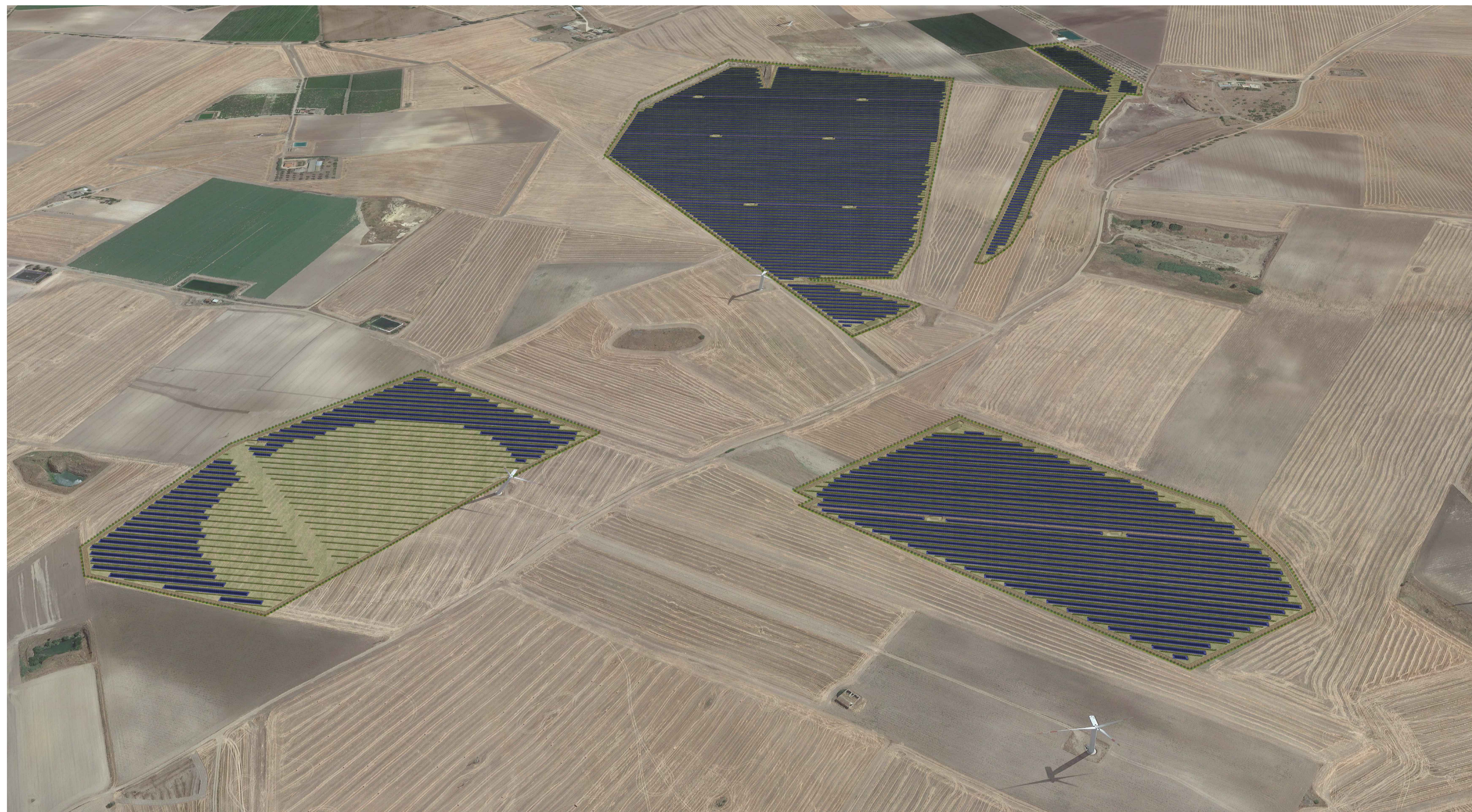
VISTA AEREA IMPIANTO
