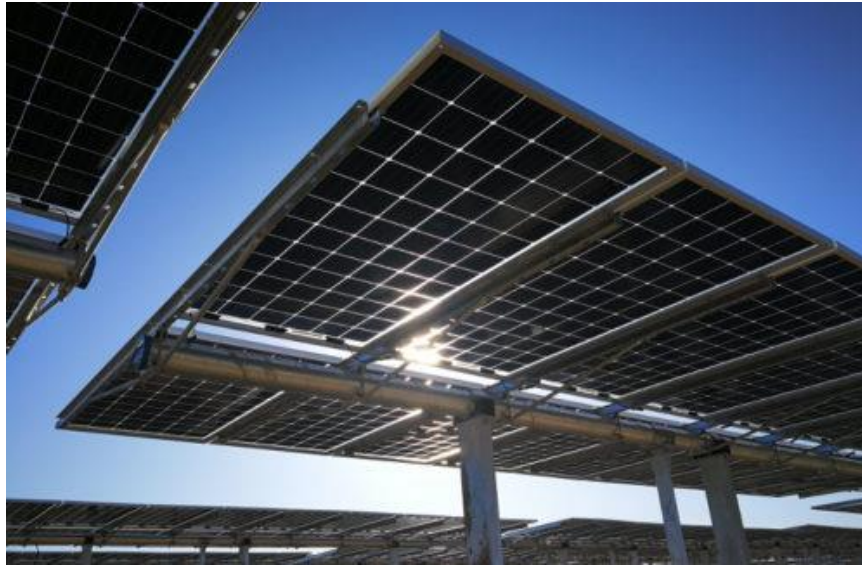
Figura 2.9 Esempio di struttura a tracker monoassiale
