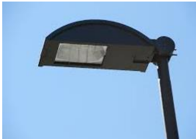
Figura 4.4: Esempio di apparecchio completamente schermato (full-cut-off).
