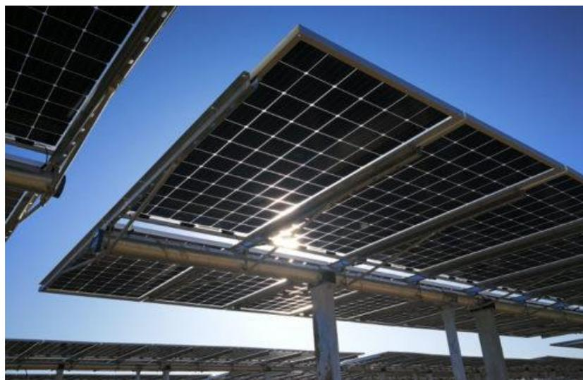
Figura 3.3 Esempio di struttura a tracker monoassiale
