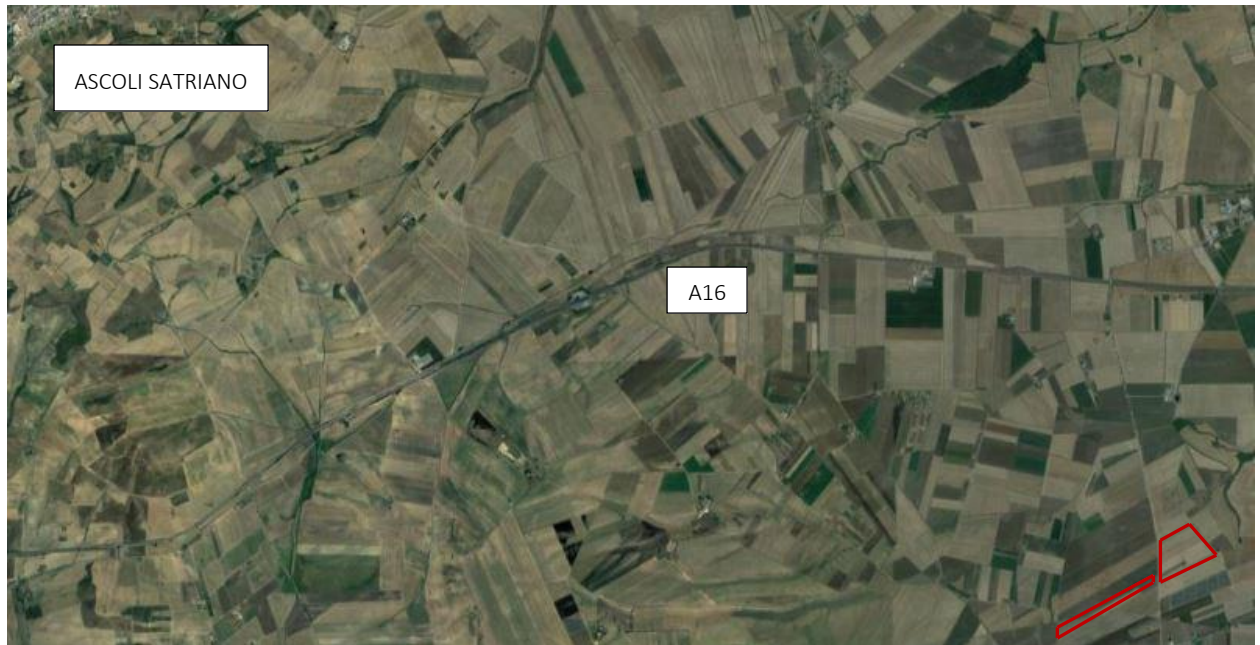
Figura 2.1: Vista satellitare area di intervento
