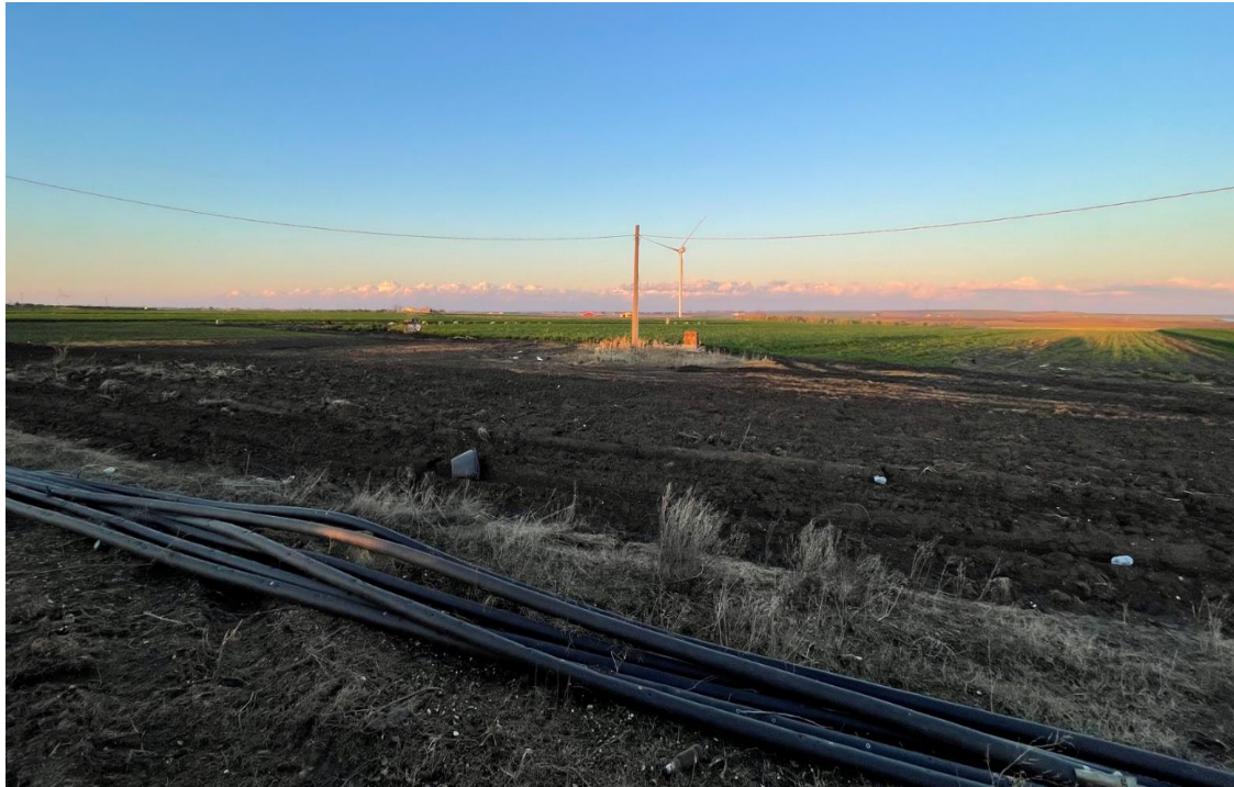
Rete irrigua interna aziendale
