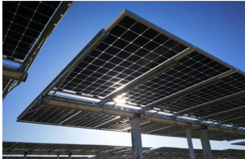
Figura 2.7 Esempio di struttura a tracker monoassiale
