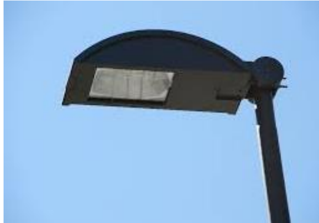
Figura 4.3: Esempio di apparecchio completamente schermato (full-cut-off).
