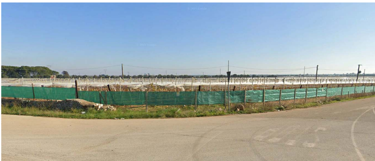
Figura 3: Area di ubicazione della Stazione elettrica RTN 380 kV di Terna SpA e relativi raccordi alla linea 380 kV “Andria – Brindisi Sud ST” (località Patalino).
