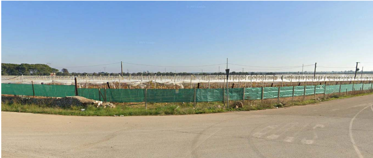
Figura 27: Area di ubicazione della Stazione elettrica RTN 380 kV di Terna SpA e relativi raccordi alla linea 380 kV “Andria – Brindisi Sud ST” (località Patalino).
