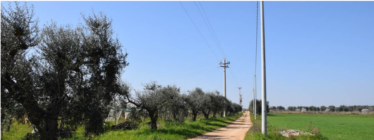
Figura 32: la strada senza denominazione di accesso all'aerogeneratore A02. La strada sarà percorsa anche dal cavidotto interrato.
