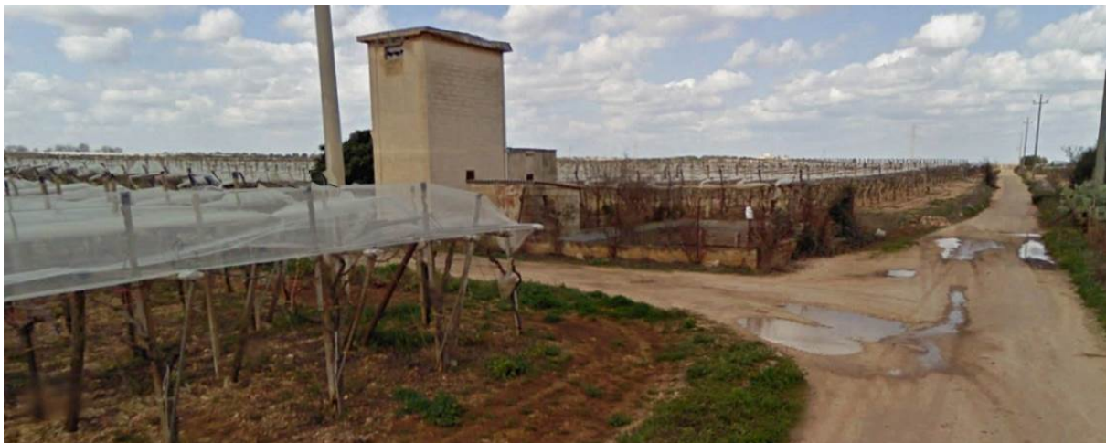
Figura 10: incrocio tra strada comunale Annunziata e la strada senza denominazione di accesso all'aerogeneratore A02; l'incrocio dovrà essere adeguato come pure la carreggiata della strada locale di accesso alla A02.
