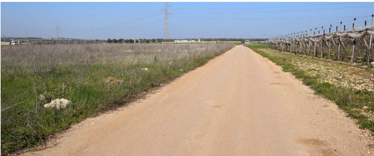
Figura 34: la strada asfaltata nei pressi dell'aerogeneratore A04. La strada sarà percorsa anche dal cavidotto interrato.
