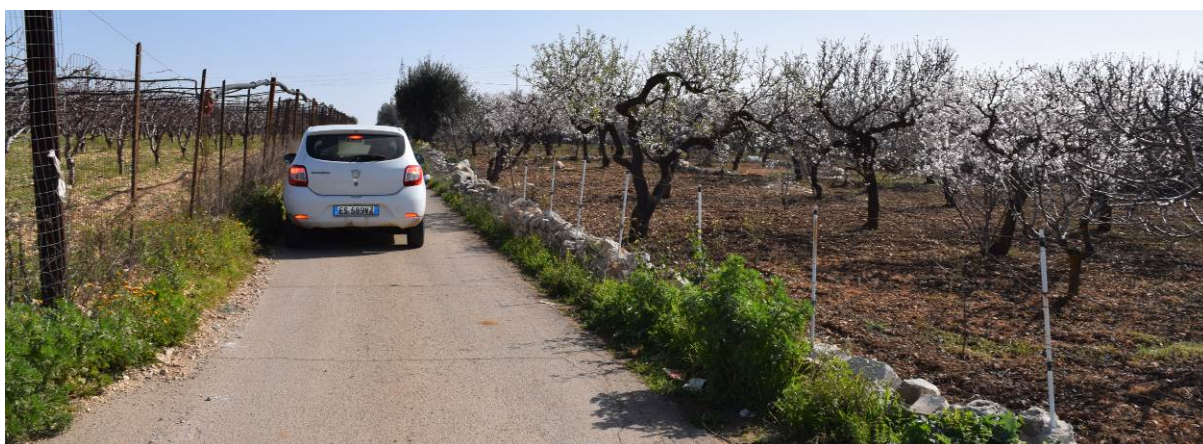
Figura 8: la strada comunale Guidotti: sono necessari puntuali allargamenti della carreggiata o temporanei spostamenti delle recinzioni dei campi.
