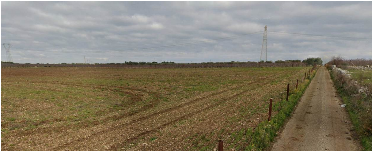
Figura 25: Area di ubicazione della Stazione elettrica di trasformazione 30/150 kV in località Patalino. La strada di accesso dovrà essere puntualmente adeguata. Sullo sfondo si notano i tralicci della linea 380 kV “Andria – Brindisi Sud ST”.
