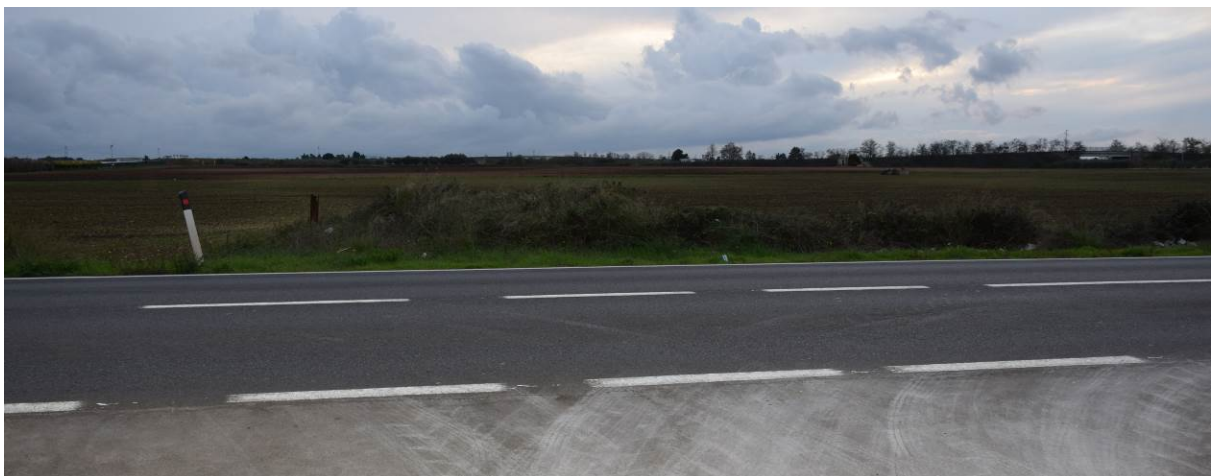
Figura 40: tratto di cavidotto che dalla SS172 si sposta su limite di fondo agricolo.
