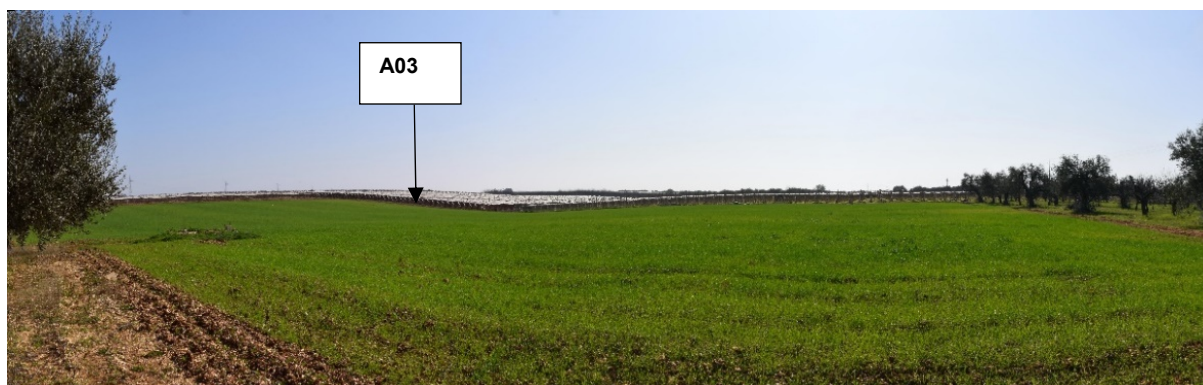
Figura 12: la freccia indica la posizione dell'aerogeneratore A03.
