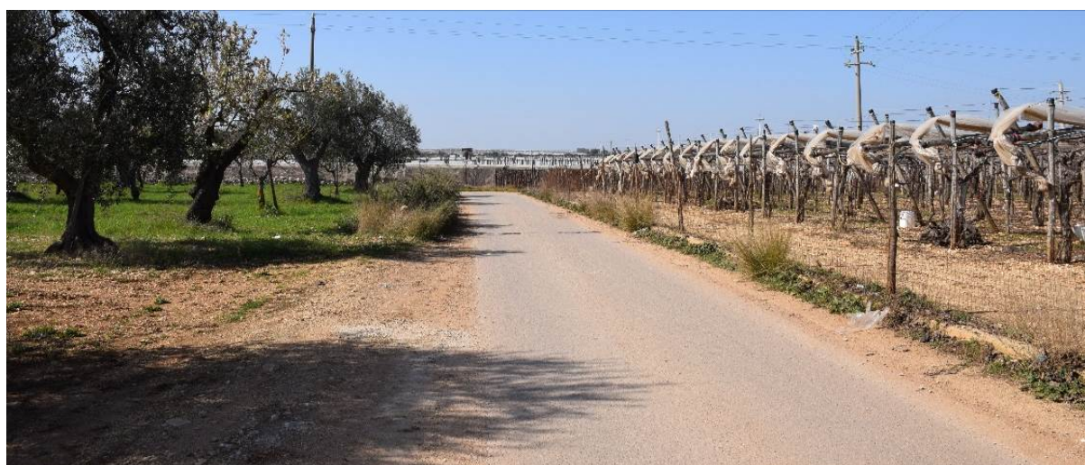
Figura 13: la strada asfaltata nei pressi dell'aerogeneratore A03, generalmente idonea ai trasporti. La strada sarà percorsa anche dal cavidotto interrato.
