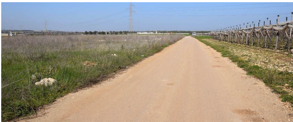
Figura 15: la strada asfaltata nei pressi dell'aerogeneratore A04, generalmente idonea ai trasporti. La strada sarà percorsa anche dal cavidotto interrato.
