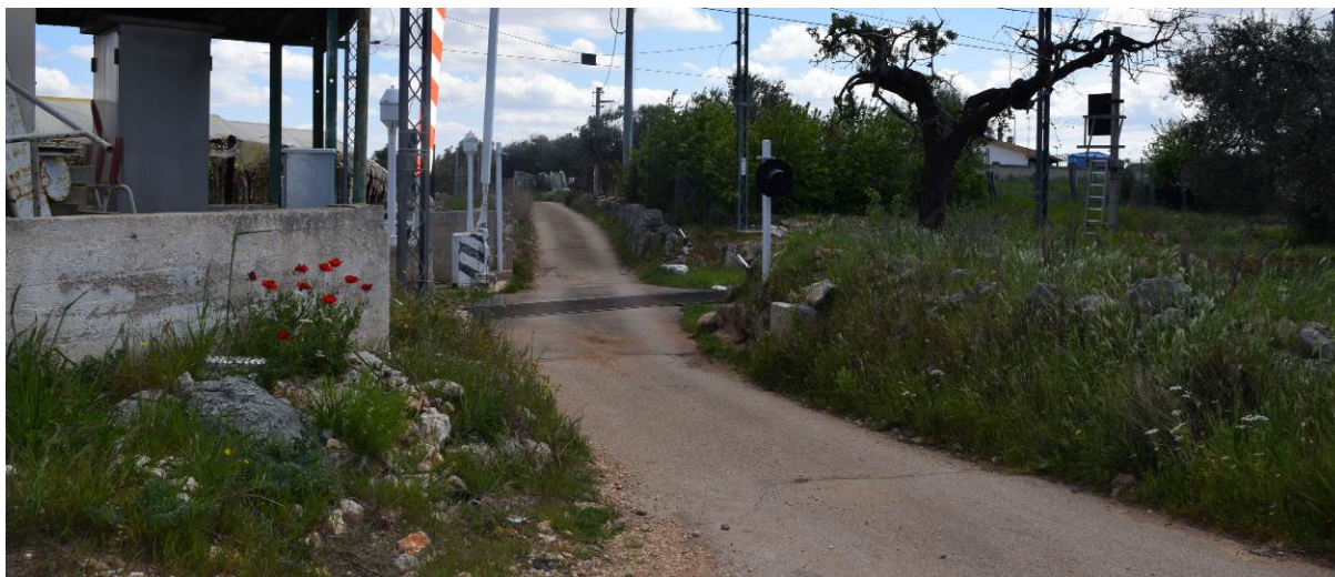
Figura 41: attraversamento della ferrovia tramite TOC.
