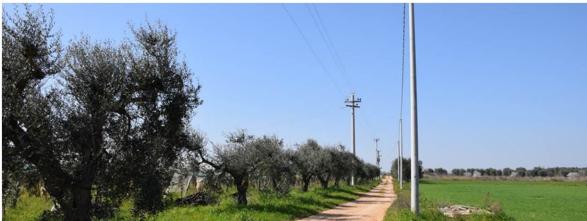
Figura 11: la strada senza denominazione di accesso all'aerogeneratore A02 che ha necessità di allargamenti della carreggiata. La strada sarà percorsa anche dal cavidotto interrato.
