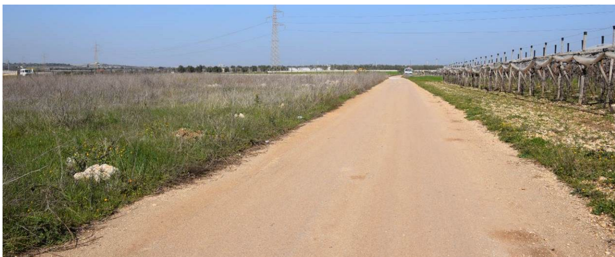
Figura 23: la strada asfaltata nei pressi dell'aerogeneratore A04, generalmente idonea ai trasporti. La strada sarà percorsa anche dal cavidotto interrato.
