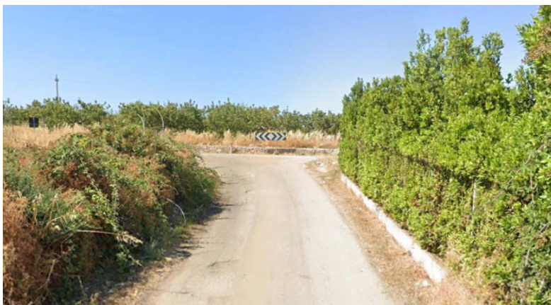
Figura 10: le foto mostrano l'incrocio tra la strada comunale "da Turi a Cellamare" e la SP65 dove sono previste opere di adeguamento stradale ricadenti nell'area di rispetto della zona di interesse archeologico. L'adeguamento stradale è contenute alla carreggiata delle strade esistenti.
