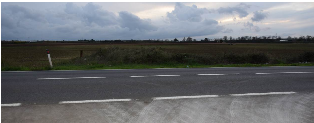
Figura 48: tratto di cavidotto che dalla SS172 si sposta su limite di fondo agricolo.
