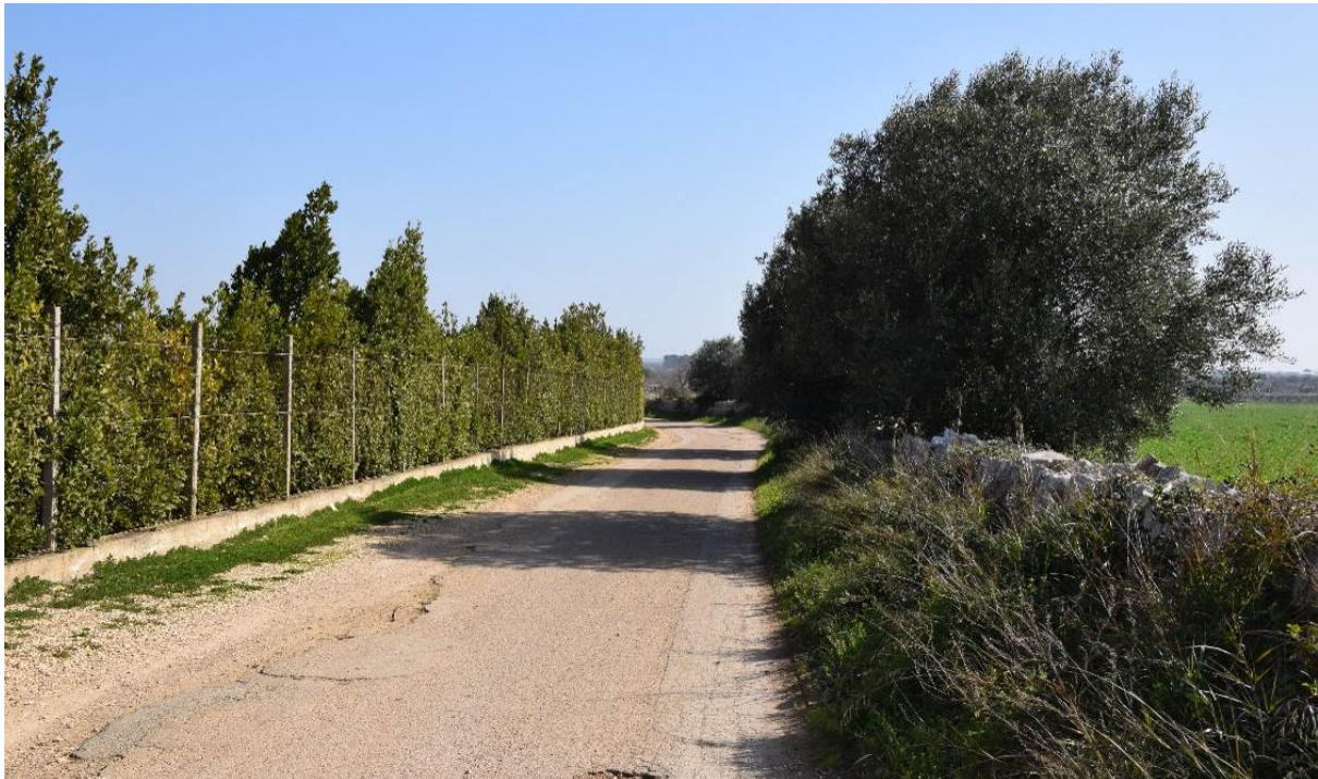
Figura 31: Strada comunale Cellamare, di accesso al sito di ubicazione dell'aerogeneratore A07.
