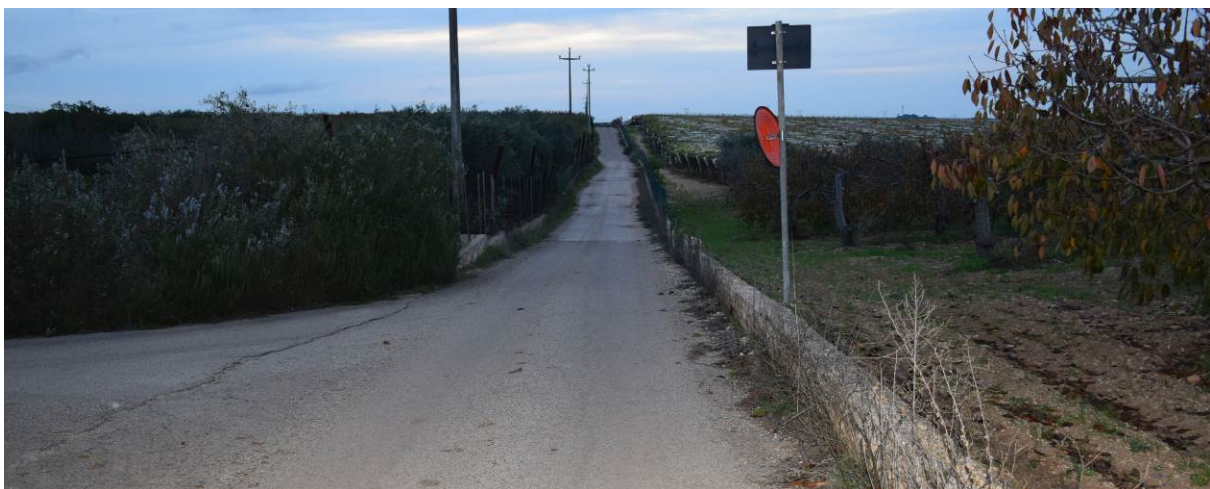
Figura 45: La strada locale percorsa dal cavidotto interrato tra A07 e A06.
