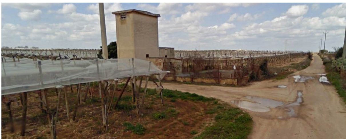
Figura 18: incrocio tra strada comunale Annunziata e la strada senza denominazione di accesso all'aerogeneratore A02; l'incrocio dovrà essere adeguato come pure la carreggiata della strada locale di accesso alla A02.
