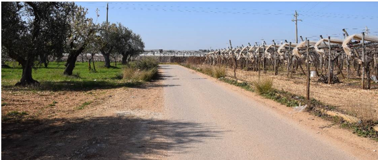
Figura 41: la strada asfaltata nei pressi dell'aerogeneratore A03. La strada sarà percorsa anche dal cavidotto interrato.
