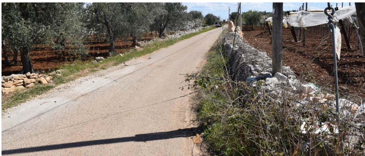
Figura 50: tratto di cavidotto esterno su strada vicinale Cardo.
