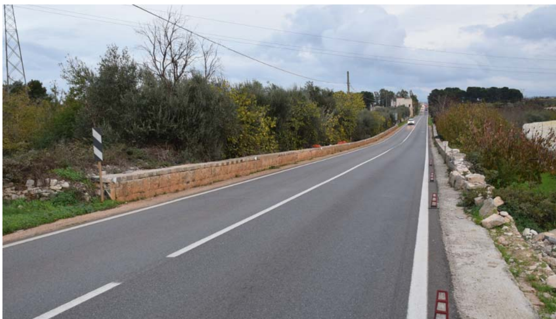
Figura 4: la foto mostra la SS172 lungo la quale verrà posato il cavidotto esterno in corrispondenza del reticolo idrografico di connessione della rete RER " il Lamone". L'attraversamento del Lamone verrà effettuato mediante la tecnologia TOC.
