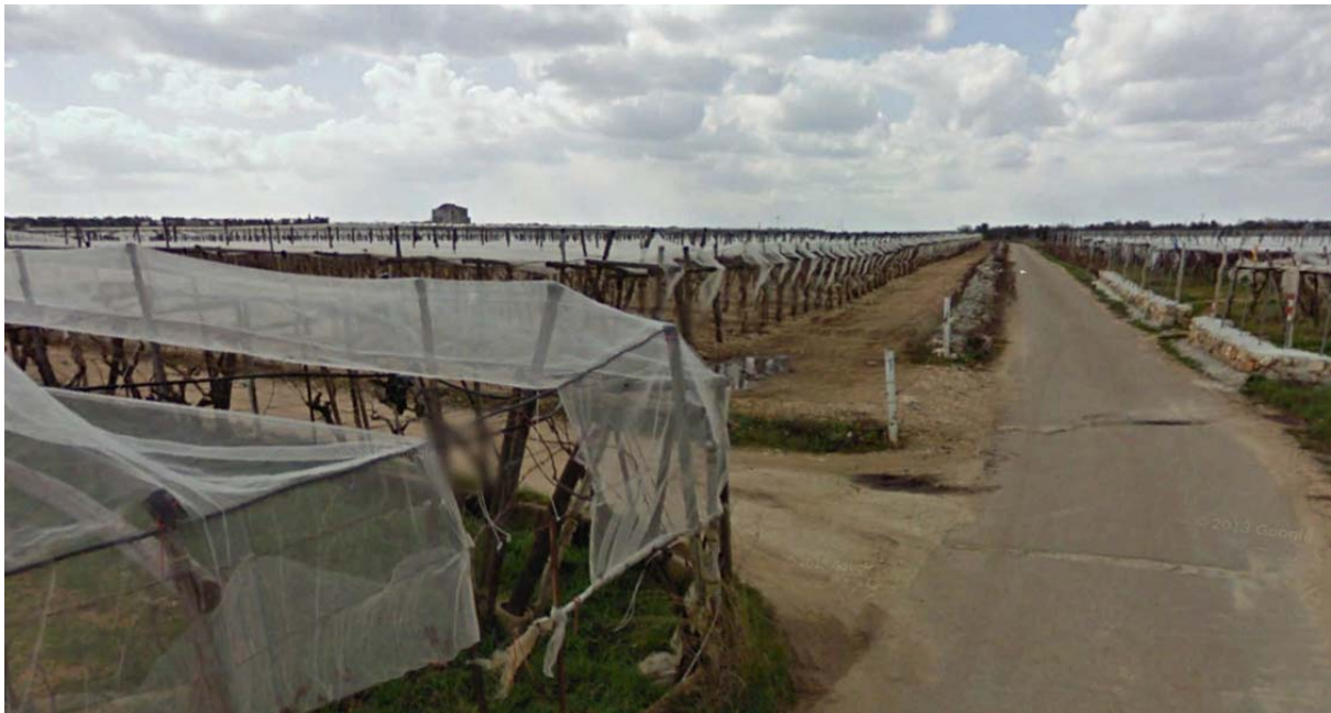
Figura 26: imbocco della strada interpoderale in massiciata e finitura in stabilizzato da cui si serve l'aerogeneratore A05, vista dalla strada asfaltata; l'imbocco dovrà essere allargato per consentire il transito dei mezzi di trasporto delle strutture. La strada sarà percorsa anche dal cavidotto interrato.
