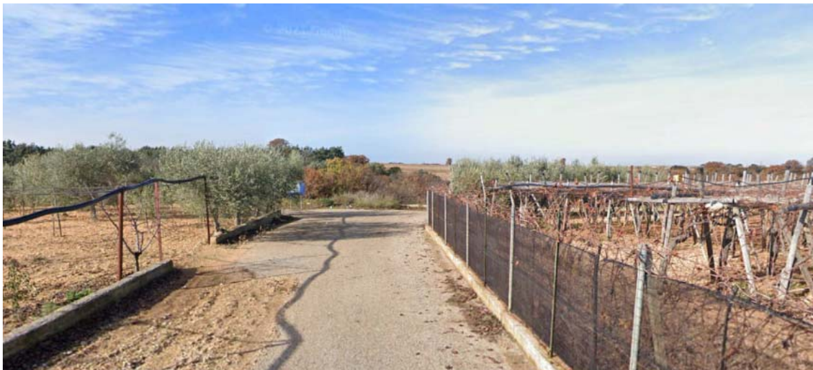
Figura 8: la foto mostra la strada interpodereale lungo la quale verrà posato il cavidotto interno in corrispondenza della Lama San Giorgio che verrà attraversata con posa del cavidotto mediante la tecnologia TOC.
