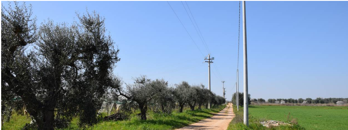
Figura 40: la strada senza denominazione di accesso all'aerogeneratore A02. La strada sarà percorsa anche dal cavidotto interrato.
