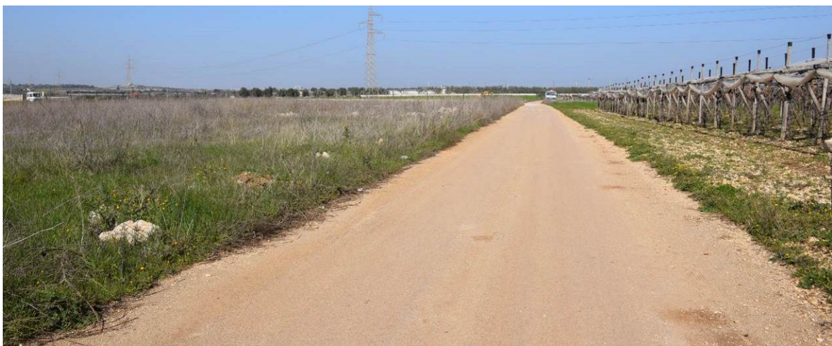
Figura 42: la strada asfaltata nei pressi dell'aerogeneratore A04. La strada sarà percorsa anche dal cavidotto interrato.
