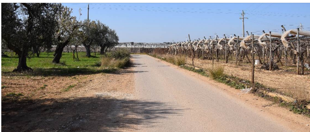
Figura 21: la strada asfaltata nei pressi dell'aerogeneratore A03, generalmente idonea ai trasporti. La strada sarà percorsa anche dal cavidotto interrato.
