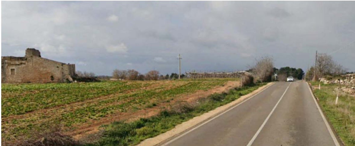
Figura 11: SS172 lungo la quale sarà posato il cavidotto esterno in corrispondenza della Chiesetta rurale Santa Maria di Monticello.
