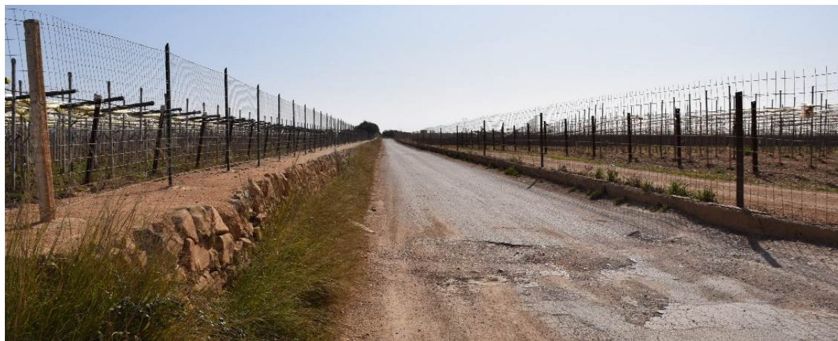
Figura 28: strada vicinale Tarantina nei pressi dell'accesso all'aerogeneratore A06. La strada è generalmente idonea per il transito dei mezzi: vi è la necessità di piccoli interventi di adeguamento del piano viario e di puntuali allargamenti della carreggiata. La strada sarà percorsa anche dal cavidotto interrato.
