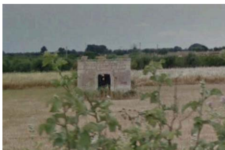
Figura 30: Fabbricato fatiscente nei pressi dell'aerogeneratore A07.
