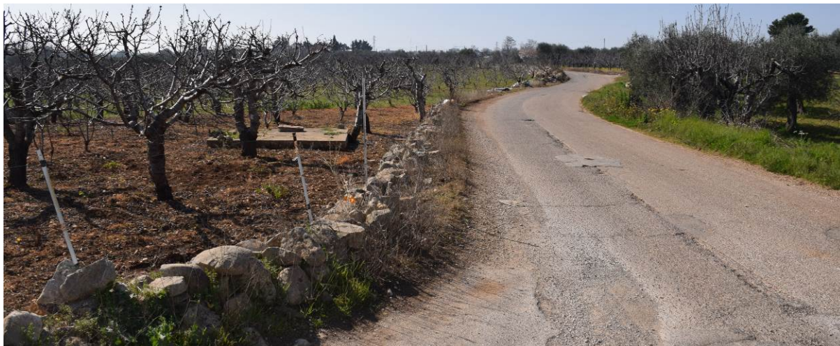
Figura 15: tratto della SP179 in prossimità dell'imbocco della strada comunale Guidotti di accesso alla A01
