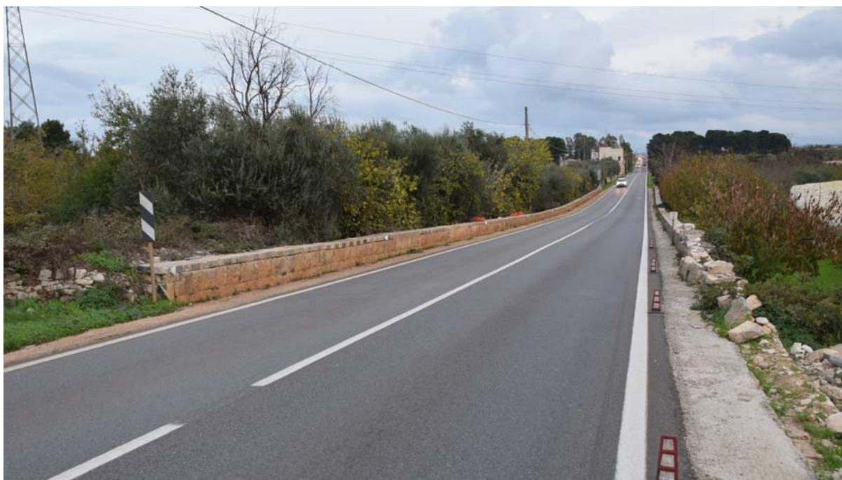
**Figura 1: la foto mostra la SS172 lungo la quale verrà posato il cavidotto esterno in corrispondenza del reticolo idrografico di connessione della rete RER “ il Lamone”. L'attraversamento del Lamone verrà effettuato mediante la tecnologia TOC.**
