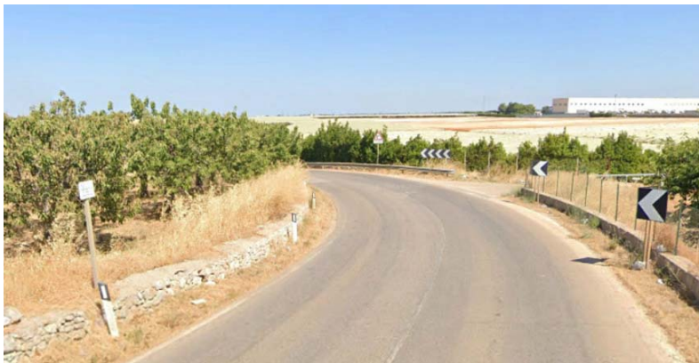
Figura 31: la foto mostra la strada che permette l'accesso all'aerogeneratore A04 in corrispondenza della Masseria Panicelli. In tale tratto sarà necessario effettuare delle operazioni di adeguamento stradale consistenti nella rimozione della recinzione che si trova sul lato opposto alla masseria, sulla destra nella foto, con temporaneo allargamento della carreggiata stradale.
