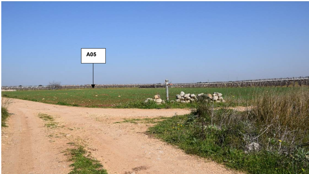
Figura 14: la freccia indica la posizione dell'aerogeneratore A05 nel fondo destinato a seminativo. La strada interpodereale in massiciata e finitura in stabilizzato da cui si serve l'aerogeneratore è sostanzialmente adeguata.
