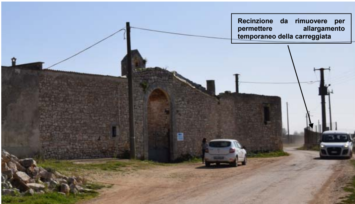
Figura 31: la foto mostra la strada che permette l'accesso all'aerogeneratore A04 in corrispondenza della Masseria Panicelli. In tale tratto sarà necessario effettuare delle operazioni di adeguamento stradale consistenti nella rimozione della recinzione che si trova sul lato opposto alla masseria, sulla destra nella foto, con temporaneo allargamento della carreggiata stradale.
