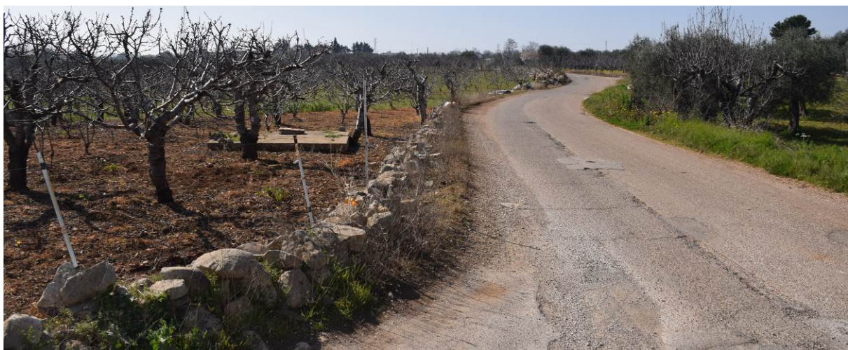
Figura 4: tratto della SP179 in prossimità dell’imbocco della strada comunale Guidotti di accesso alla A01
