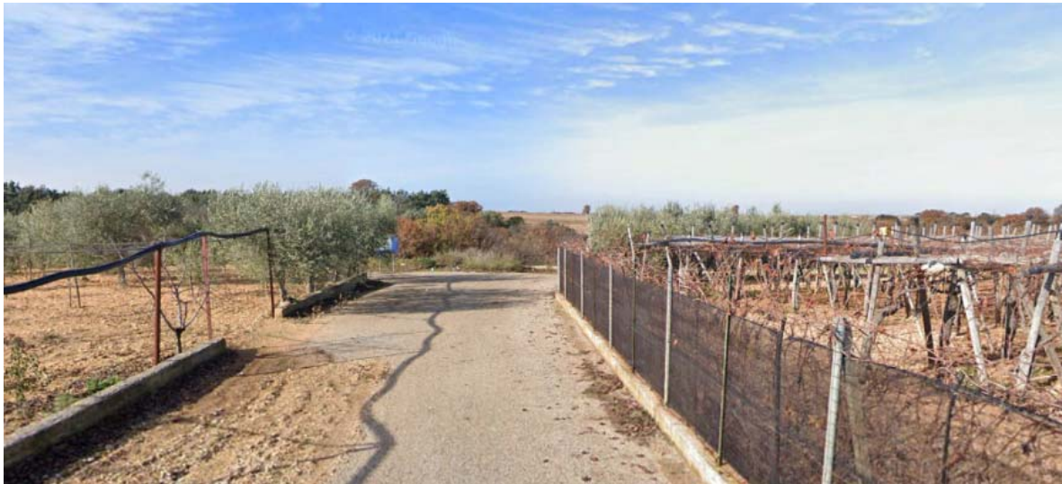
Figura 30: la foto mostra la strada interpodereale lungo la quale verrà posato il cavidotto interno in corrispondenza della Lama San Giorgio che verrà attraversata con posa del cavidotto mediante la tecnologia TOC.
