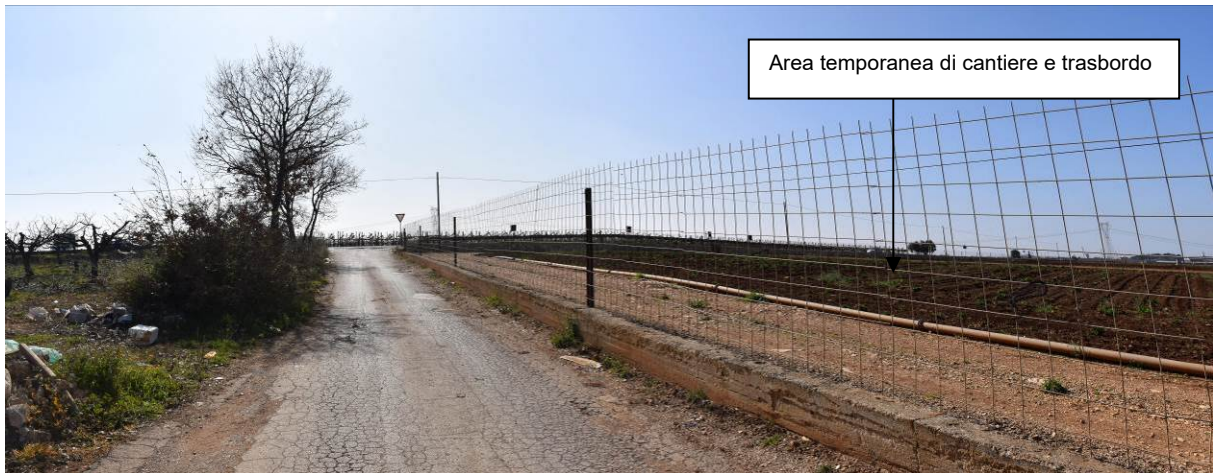
Figura 25: vista della strada vicinale Tarantina all'imbocco dalla SS172. Da questa strada si accede a gran parte dell'impianto. Sulla sinistra è visibile l'area agricola che sarà occupata temporaneamente dall'area di cantiere e dal trasbordo delle componenti degli aerogeneratori.
