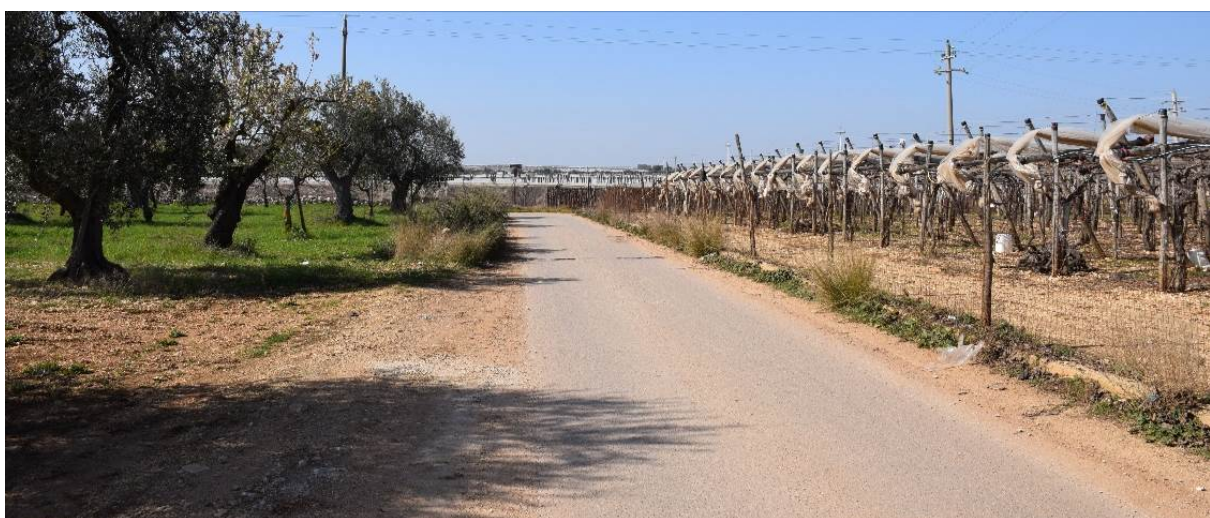
Figura 10: la strada asfaltata nei pressi dell'aerogeneratore A03, generalmente idonea ai trasporti. La strada sarà percorsa anche dal cavidotto interrato.
