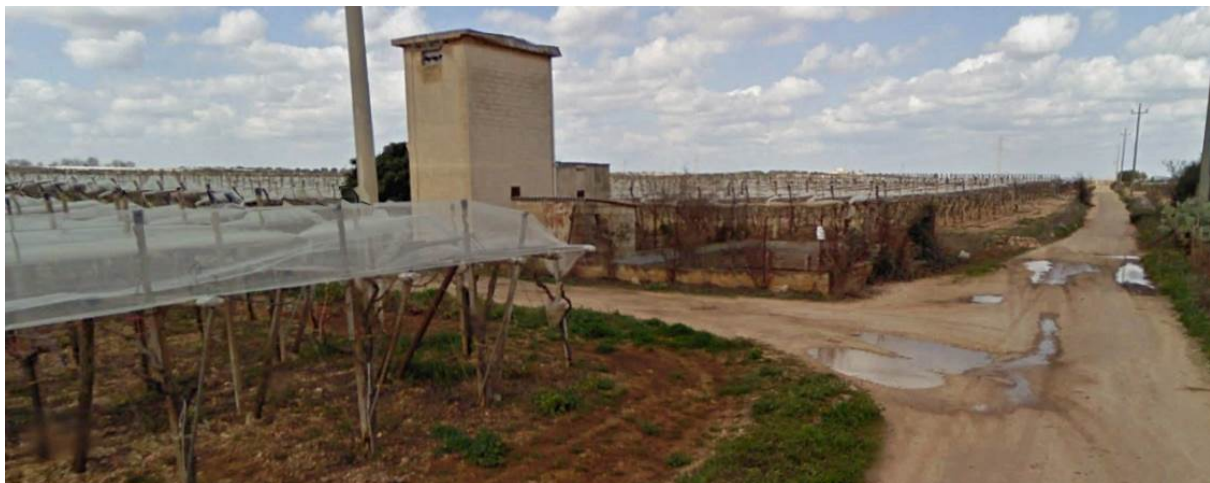
Figura 7: incrocio tra strada comunale Annunziata e la strada senza denominazione di accesso all'aerogeneratore A02; l'incrocio dovrà essere adeguato come pure la carreggiata della strada locale di accesso alla A02.
