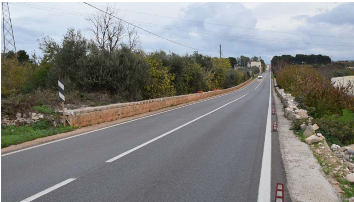
Figura 26: la foto mostra la SS172 lungo la quale verrà posato il cavidotto esterno in corrispondenza del reticolo idrografico di connessione della rete RER " il Lamone". L'attraversamento del Lamone verrà effettuato mediante la tecnologia TOC.
