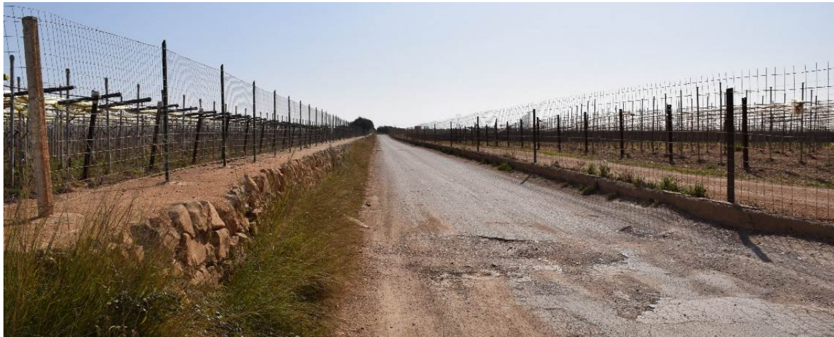
Figura 17: strada vicinale Tarantina nei pressi dell'accesso all'aerogeneratore A06. La strada è generalmente idonea per il transito dei mezzi: vi è la necessità di piccoli interventi di adeguamento del piano viario e di puntuali allargamenti della carreggiata. La strada sarà percorsa anche dal cavidotto interrato.
