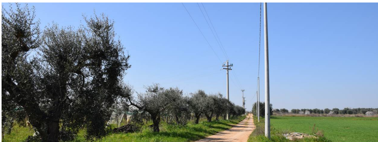
Figura 8: la strada senza denominazione di accesso all'aerogeneratore A02 che ha necessità di allargamenti della carreggiata. La strada sarà percorsa anche dal cavidotto interrato.
