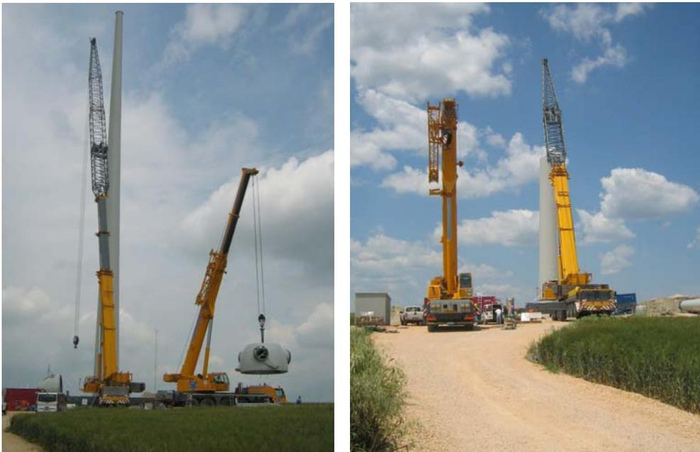
**Figura 3:** smontaggio navicella**Figura 4:** particolare smontaggio torre
