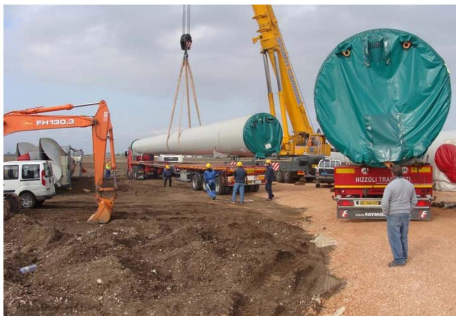
**Figura 6:** elementi torre smontata da trasportare
