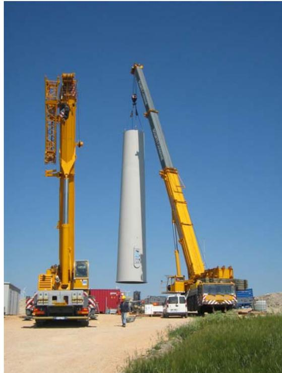
**Figura 5:** elemento torre smontata da trasportare
