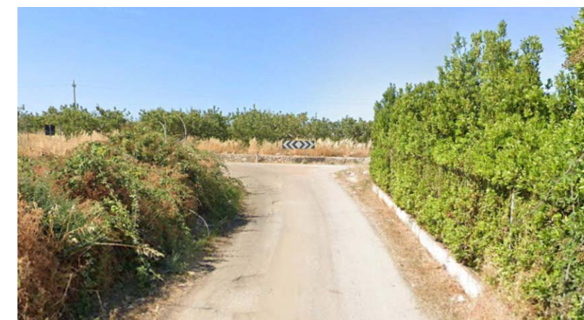
Figura 7: le foto mostrano l'incrocio tra la strada comunale "da Turi a Cellamare" e la SP65 dove sono previste opere di adeguamento stradale ricadenti nell'area di rispetto della zona di interesse archeologico. L'adeguamento stradale è conterminato alla carreggiata delle strade esistenti.
