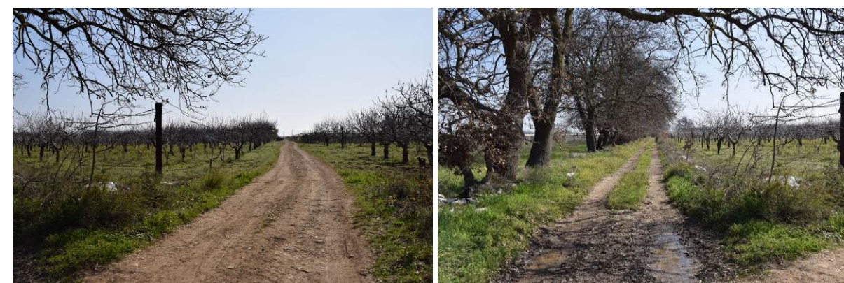
Figura 25: stradine interpoderali che saranno oggetto di adeguamenti per consentire l'accesso all'aerogeneratore A04.
