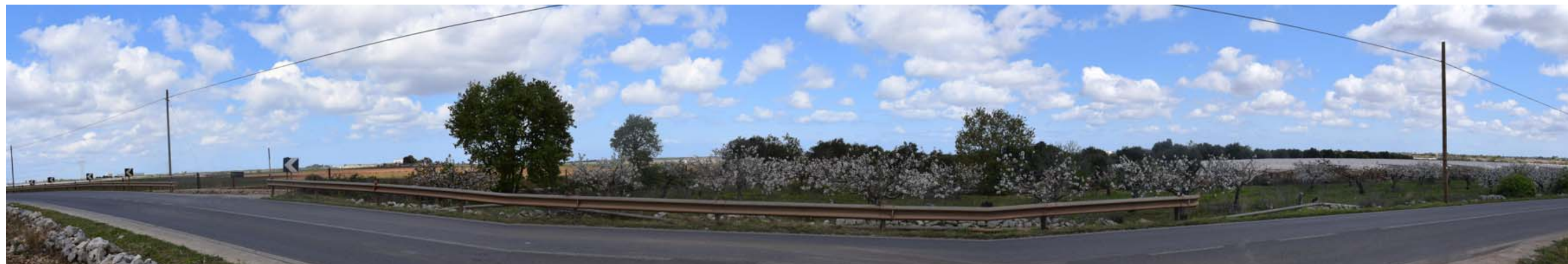
Panoramica 21 - SP 172 – STATO DI FATTO
