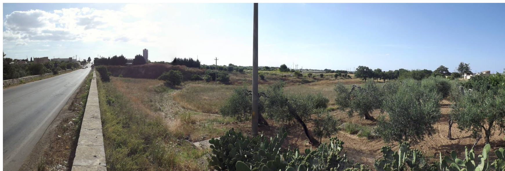
Figura 12: vista della Lama San Giorgio dal ponte con il quale la SP 84 la attraversa
