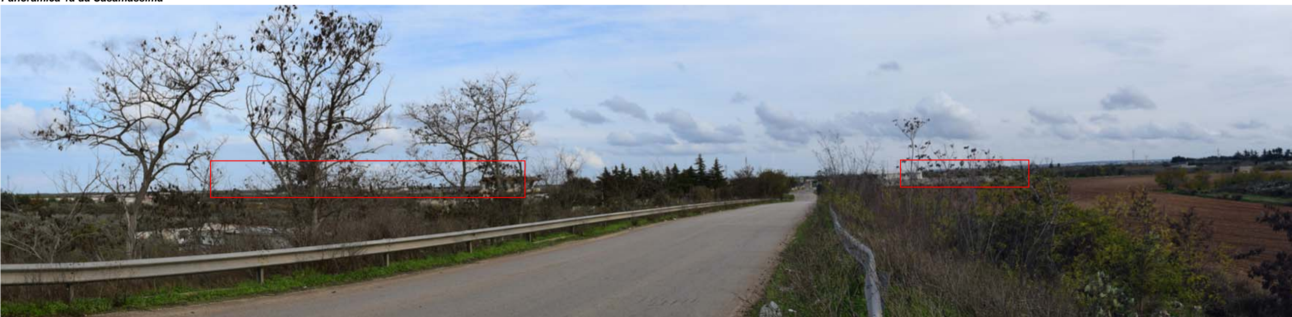
Panoramica 1b da Casamassima SP65_cavalcavia su SS100
