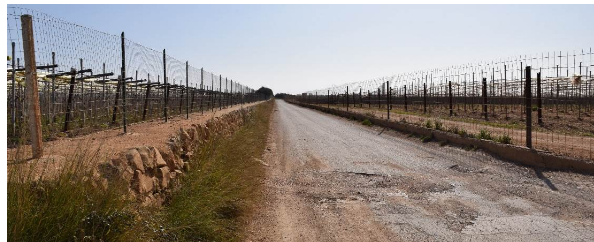
Figura 29: strada vicinale Tarantina nei pressi dell'accesso all'aerogeneratore A06. La strada è generalmente idonea per il transito dei mezzi: vi è la necessità di piccoli interventi di adeguamento del piano viario e di puntuali allargamenti della carreggiata. La strada sarà percorsa anche dal cavidotto interrato.
