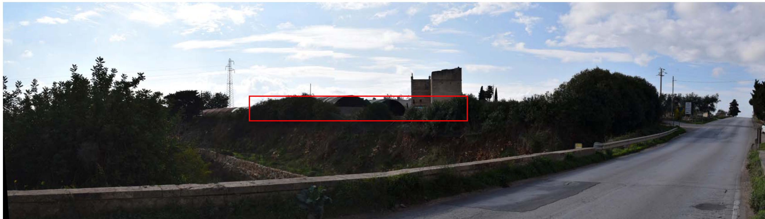
Panoramica 15a- Panoramica ripresa dalla SP84 in corrispondenza del ponte sulla Lama San Giorgio
