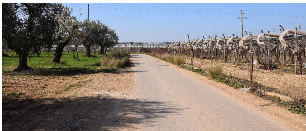
Figura 22: la strada asfaltata nei pressi dell'aerogeneratore A03, generalmente idonea ai trasporti. La strada sarà percorsa anche dal cavidotto interrato.
