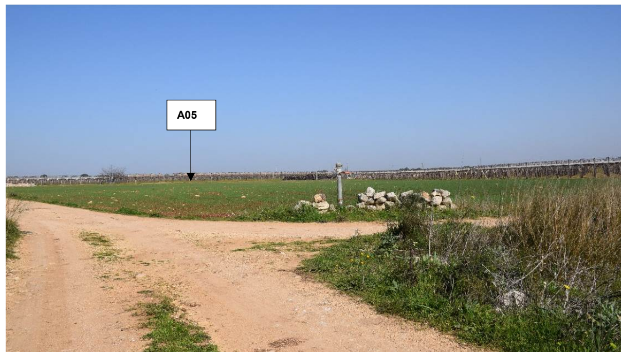
Figura 26: la freccia indica la posizione dell'aerogeneratore A05 nel fondo destinato a seminativo. La strada interpodereale in massicciata e finitura in stabilizzato da cui si serve l'aerogeneratore è sostanzialmente adeguata.
