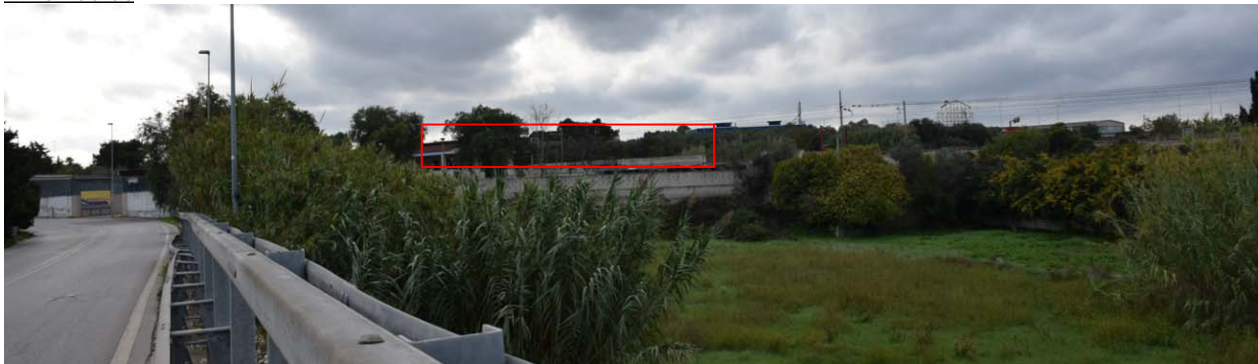
Panoramica 11– dalla località costiera Cala San Giorgio.
