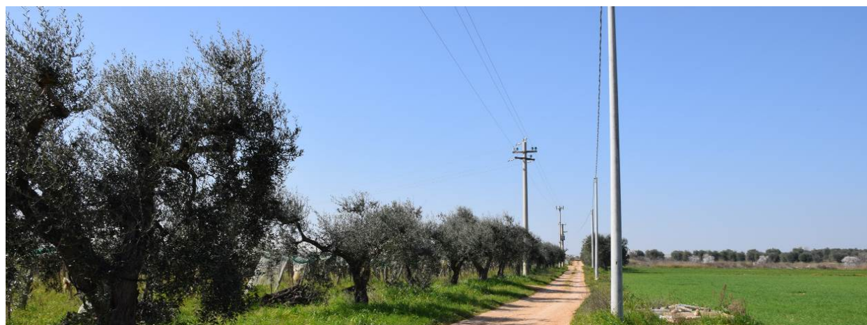
Figura 20: la strada senza denominazione di accesso all'aerogeneratore A02 che ha necessità di allargamenti della carreggiata. La strada sarà percorsa anche dal cavidotto interrato.
