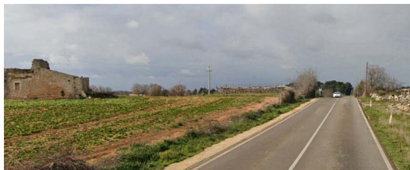
Figura 8: SS172 lungo la quale sarà posato il cavidotto esterno in corrispondenza della Chiesetta rurale Santa Maria di Monticello.
