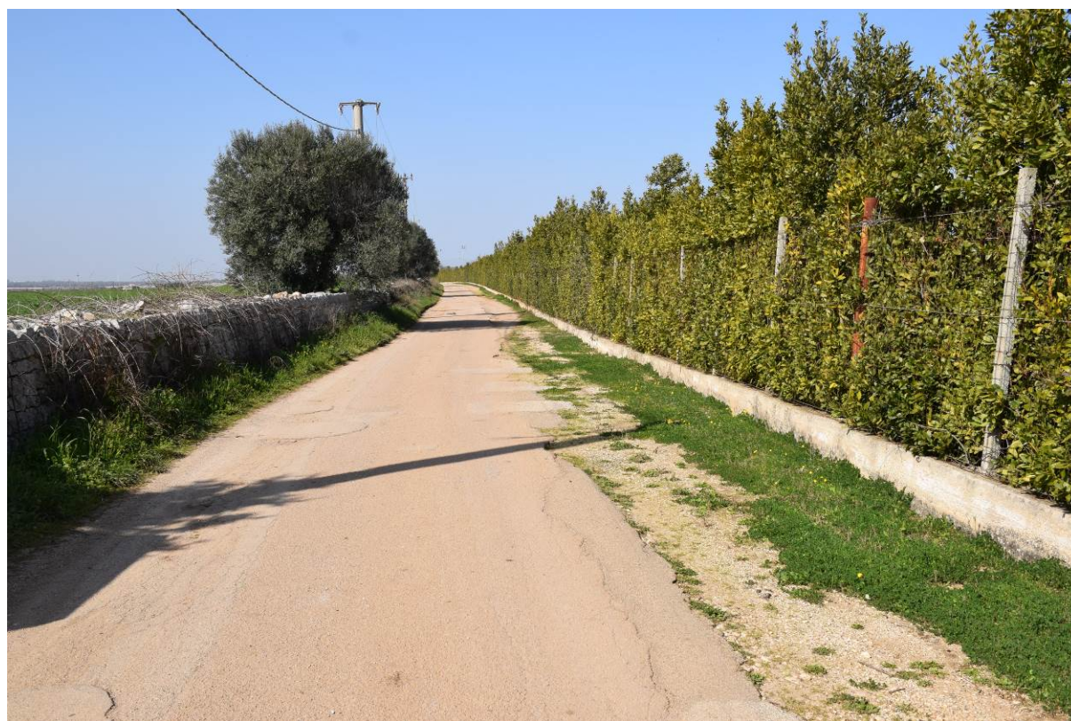
Figura 32: la strada comunale da Turi a Cellamare: sono necessari puntuali allargamenti della carreggiata o temporanei spostamenti delle recinzioni dei campi.
