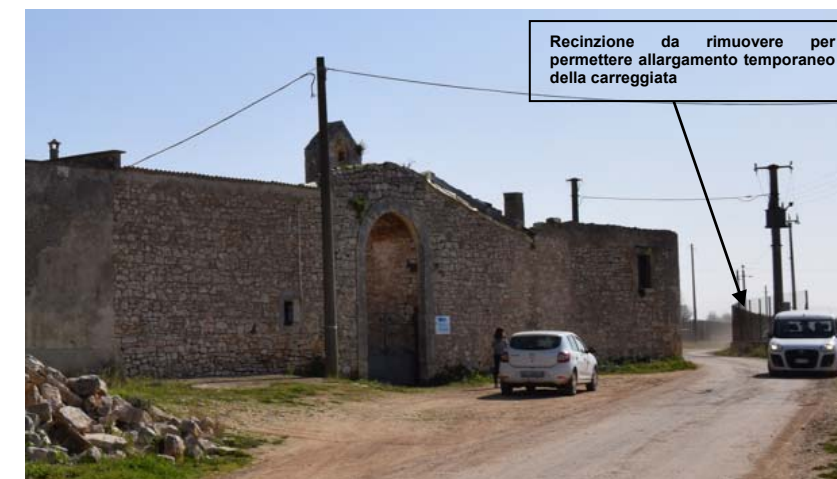
Figura 6: la foto mostra la strada che permette l'accesso all'aerogeneratore A04 in corrispondenza della Masseria Panicelli. In tale tratto sarà necessario effettuare delle operazioni di adeguamento stradale consistenti nella rimozione della recinzione che si trova sul lato opposto alla masseria, sulla destra nella foto, con temporaneo allargamento della carreggiata stradale.
