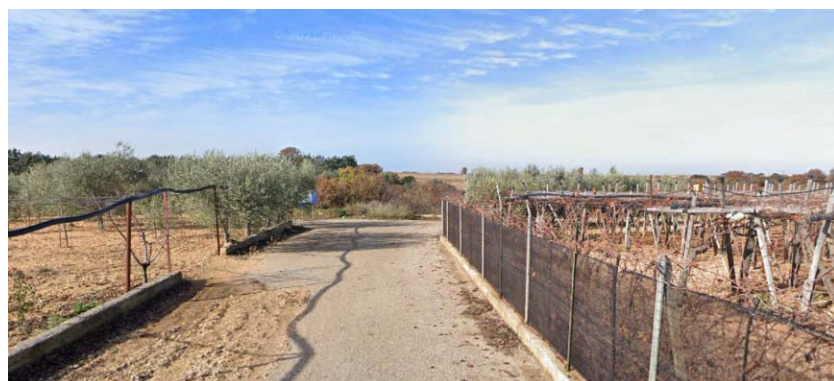
Figura 5: la foto mostra la strada interpodere lungo la quale verrà posato il cavidotto interno in corrispondenza della Lama San Giorgio che verrà attraversata con posa del cavidotto mediante la tecnologia TOC.
