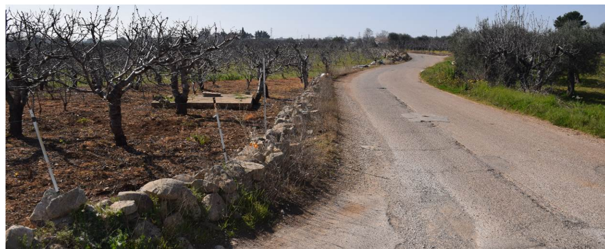
Figura 16: tratto della SP179 in prossimità dell'imbocco della strada comunale Guidotti di accesso alla A01
