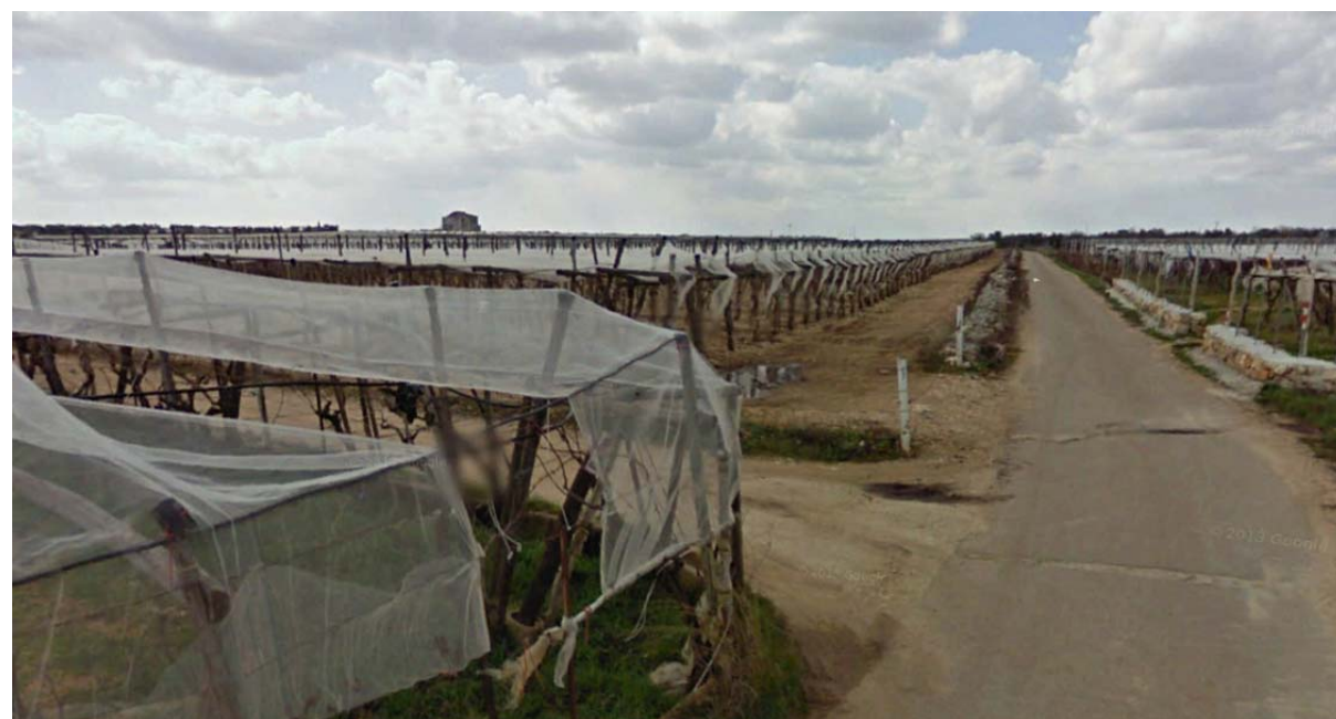
Figura 27: imbocco della strada interpodereale in massicciata e finitura in stabilizzato da cui si serve l'aerogeneratore A05, vista dalla strada asfaltata; l'imbocco dovrà essere allargato per consentire il transito dei mezzi di trasporto delle strutture. La strada sarà percorsa anche dal cavidotto interrato.
