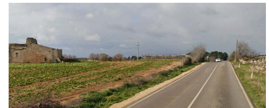
Figura 12: SS172 lungo la quale sarà posato il cavidotto esterno in corrispondenza della Chiesetta rurale Santa Maria di Monticello.
