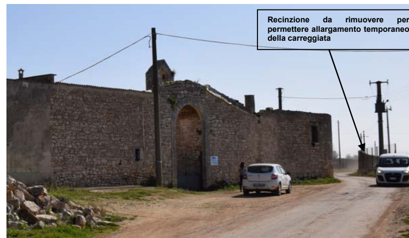
Figura 10: la foto mostra la strada che permette l'accesso all'aerogeneratore A04 in corrispondenza della Masseria Panicelli. In tale tratto sarà necessario effettuare delle operazioni di adeguamento stradale consistenti nella rimozione della recinzione che si trova sul lato opposto alla masseria, sulla destra nella foto, con temporaneo allargamento della carreggiata stradale.
