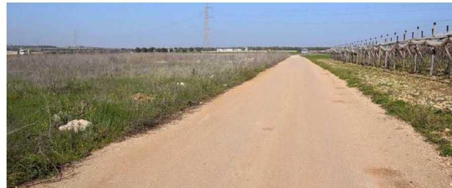
Figura 6: la strada asfaltata nei pressi dell'aerogeneratore A04. La strada sarà percorsa anche dal cavidotto interrato.
