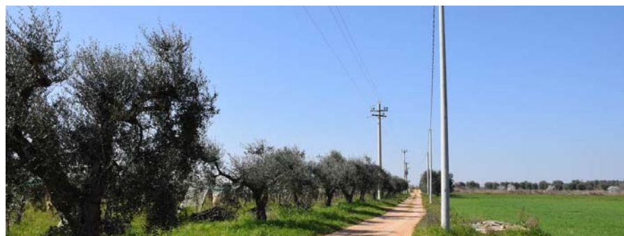
Figura 4: la strada senza denominazione di accesso all'aerogeneratore A02. La strada sarà percorsa anche dal cavidotto interrato.
