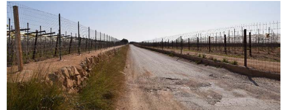
Figura 10: strada vicinale Tarantina nei pressi dell'accesso all'aerogeneratore A06. Da questo punto parte il tracciato esterno del cavidotto interrato.
