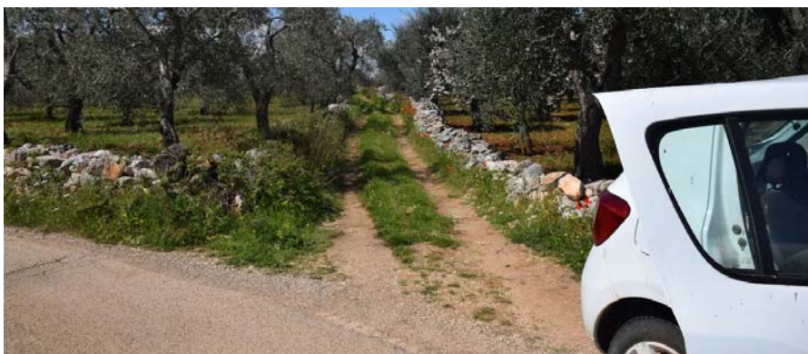
Figura 15: tratto di cavidotto esterno su strada vicinale Pezzafina; data la esigua larghezza della carreggiata e la presenza di muretti a secco, la posa del cavo in tale tratto di strada sarà effettuata con TOC.
